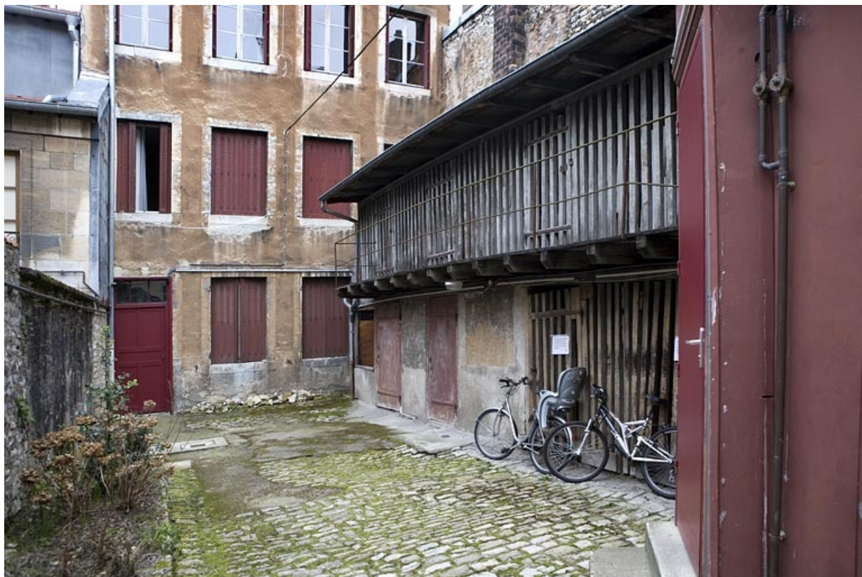
Détail du rez-de-chaussée de la façade postérieure du premier logis secondaire et des bûchers situés dans la deuxième cour. 25, Besançon, 22 rue Ronchoux, lieudit : îlot Granvelle
