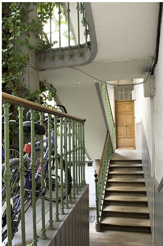
Détail de l'escalier à cage ouverte depuis la première volée.
