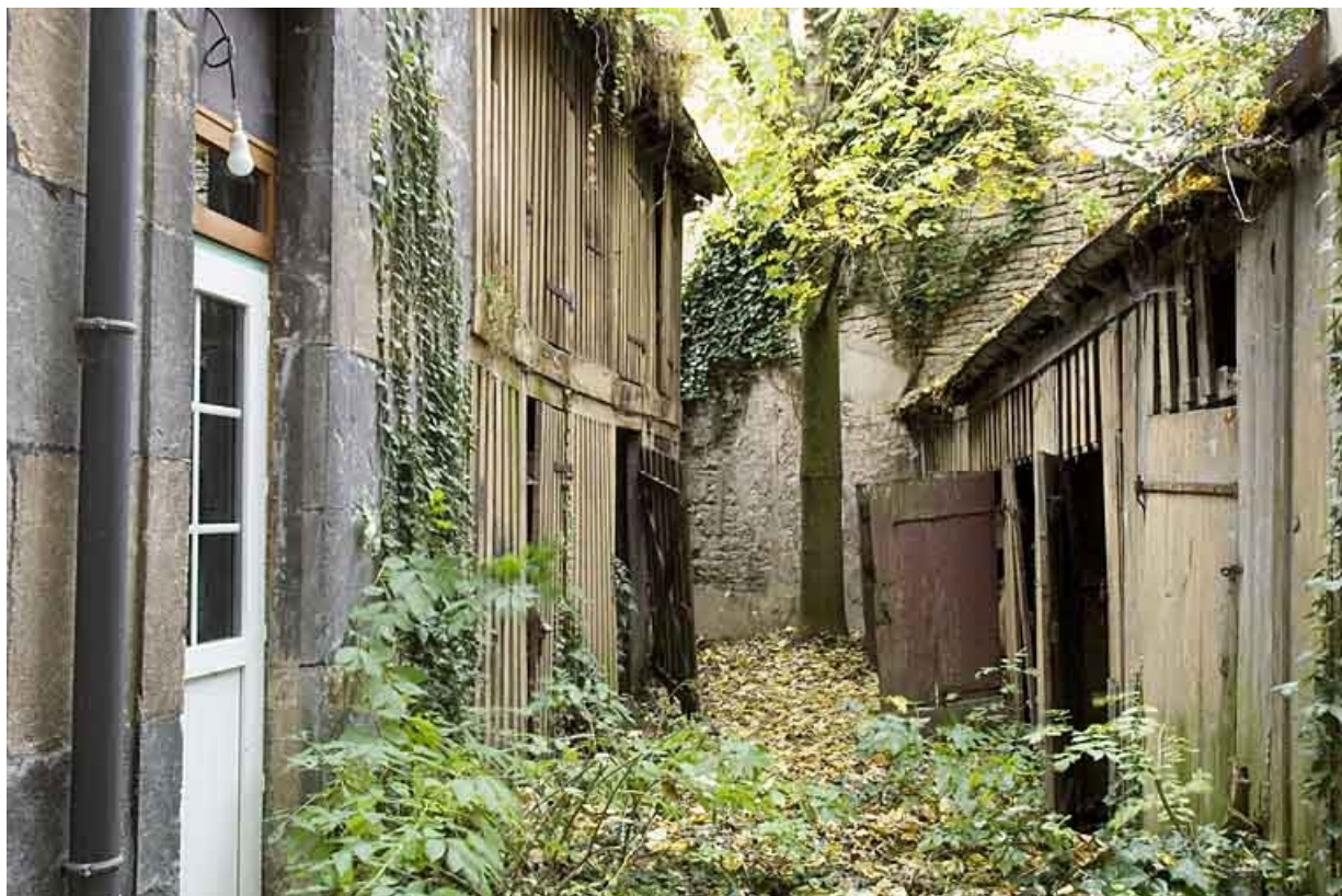
Vue d'ensemble de la deuxième cour depuis l'entrée.
