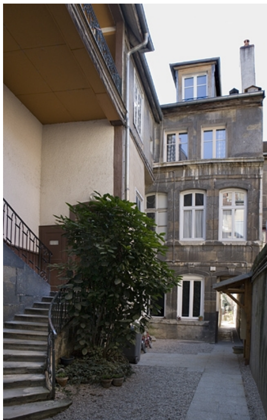
Vue d'ensemble de la façade antérieure du logis secondaire.
