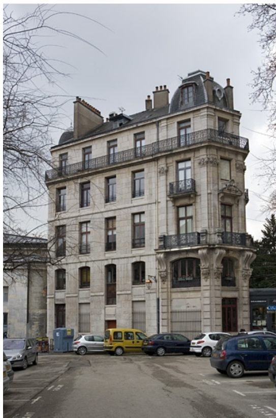
Vue d'ensemble de la façade sur la place du Théâtre, de trois quarts droit.
