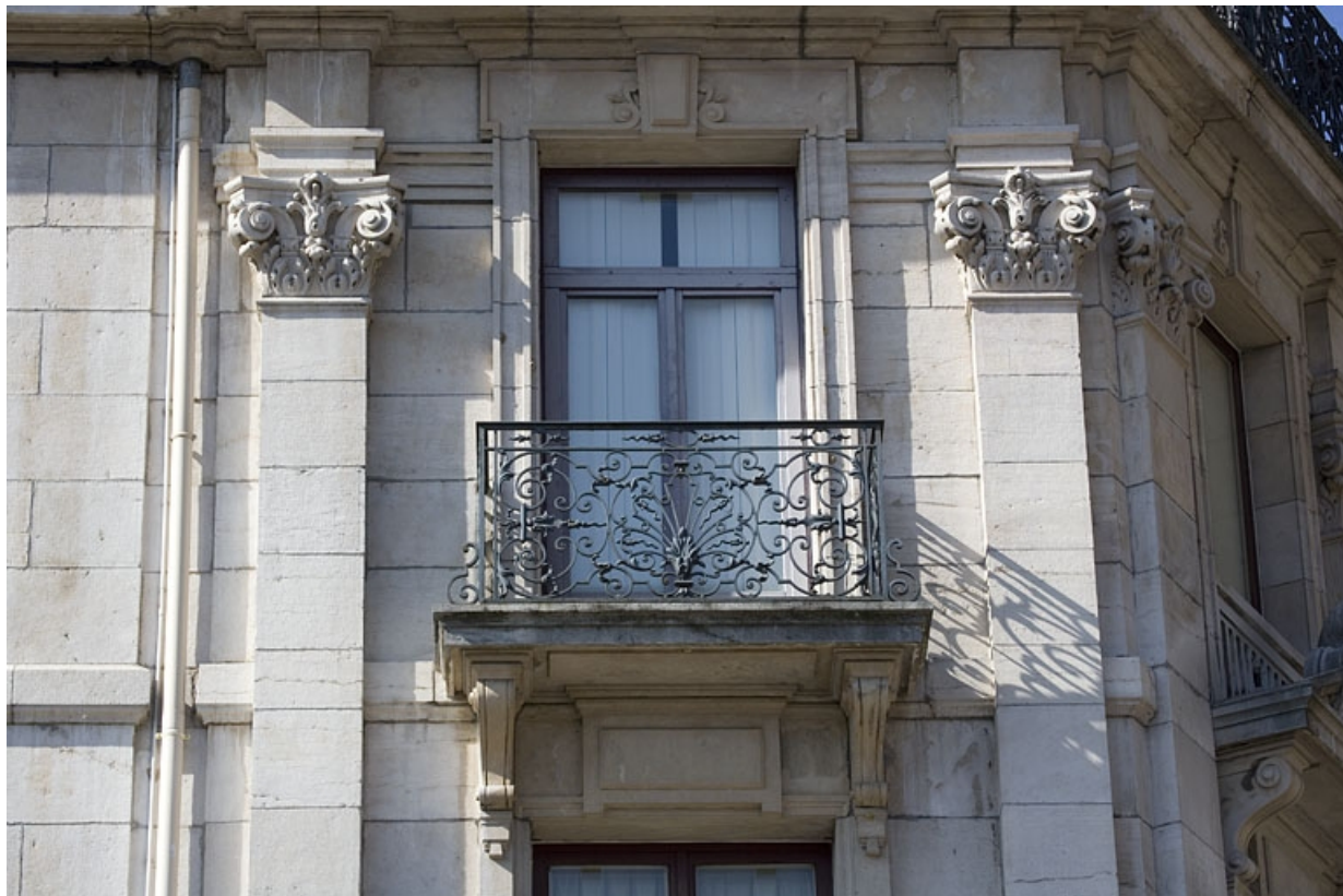
Détail d'un balcon ponctuel entre deux pilastres.
