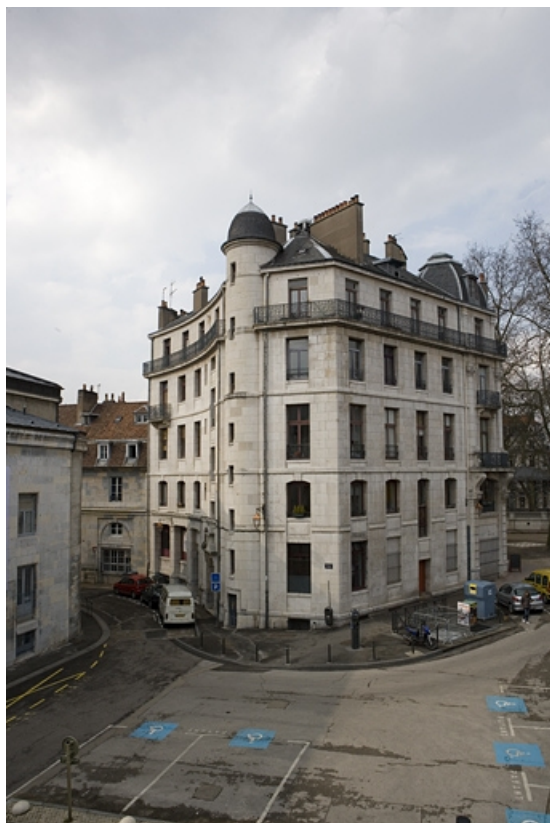
Vue d'ensemble de l'immeuble à l'angle de la place Granvelle et de la rue Lacoré. 25, Besançon, 2 rue Lacoré, lieudit : îlot Granvelle
