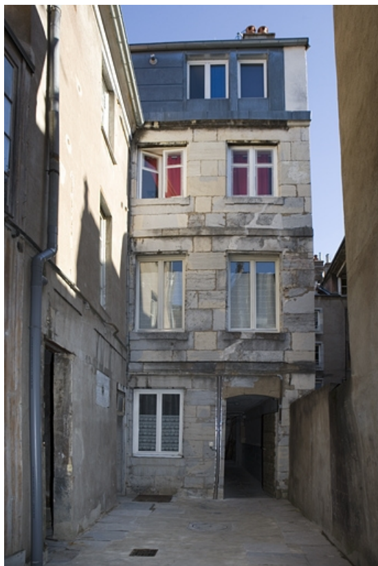
Vue d'ensemble de la façade postérieure du premier logis secondaire.
