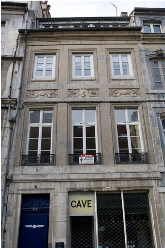
Vue d'ensemble de la façade antérieure : de face. 25, Besançon Grande Rue 122, lieudit : îlot Granvelle
