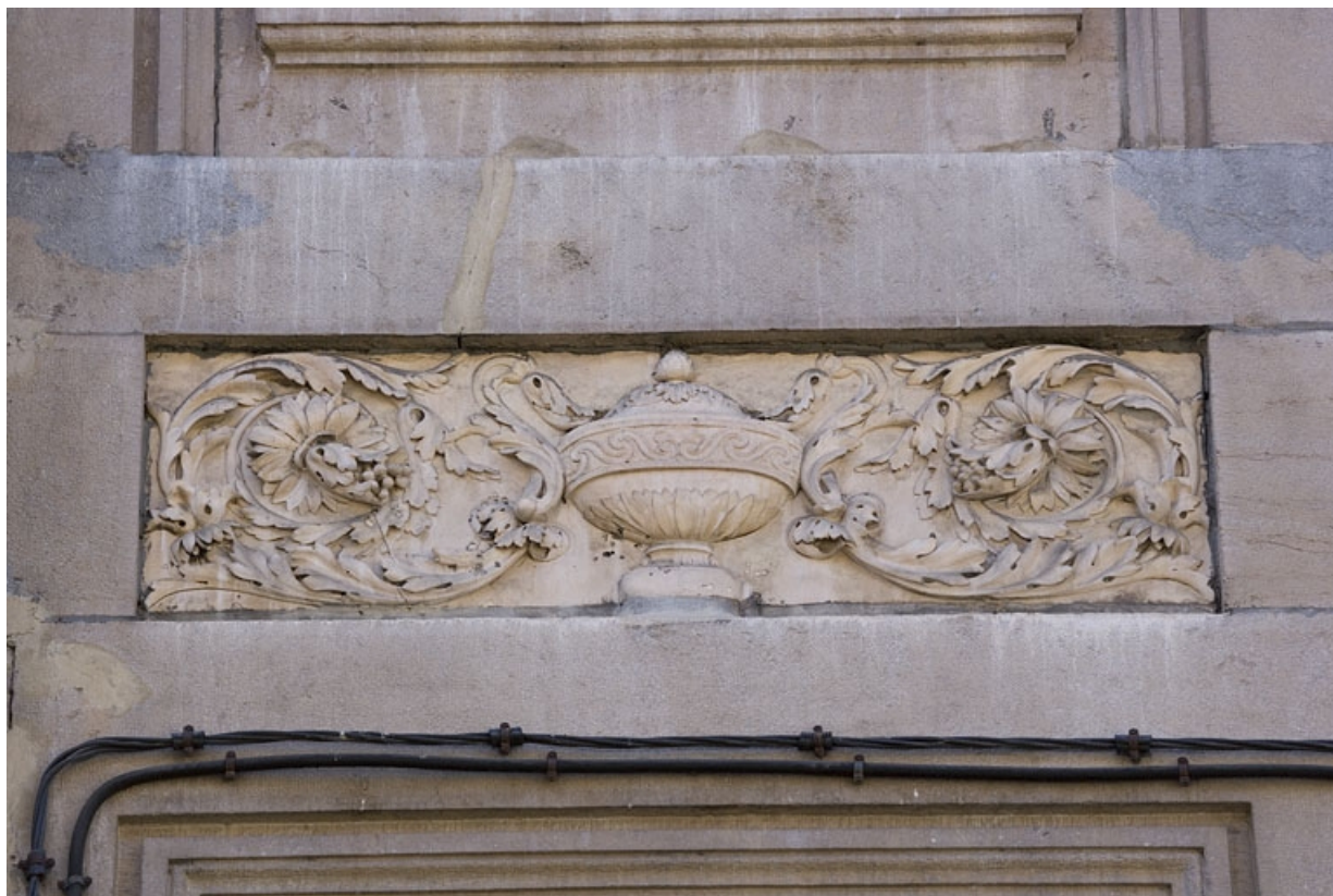
Détail du décor d'une table rentrante entre le premier et le deuxième étage : urne encadrée de feuillages. 25, Besançon Grande Rue 122, lieudit : îlot Granvelle
