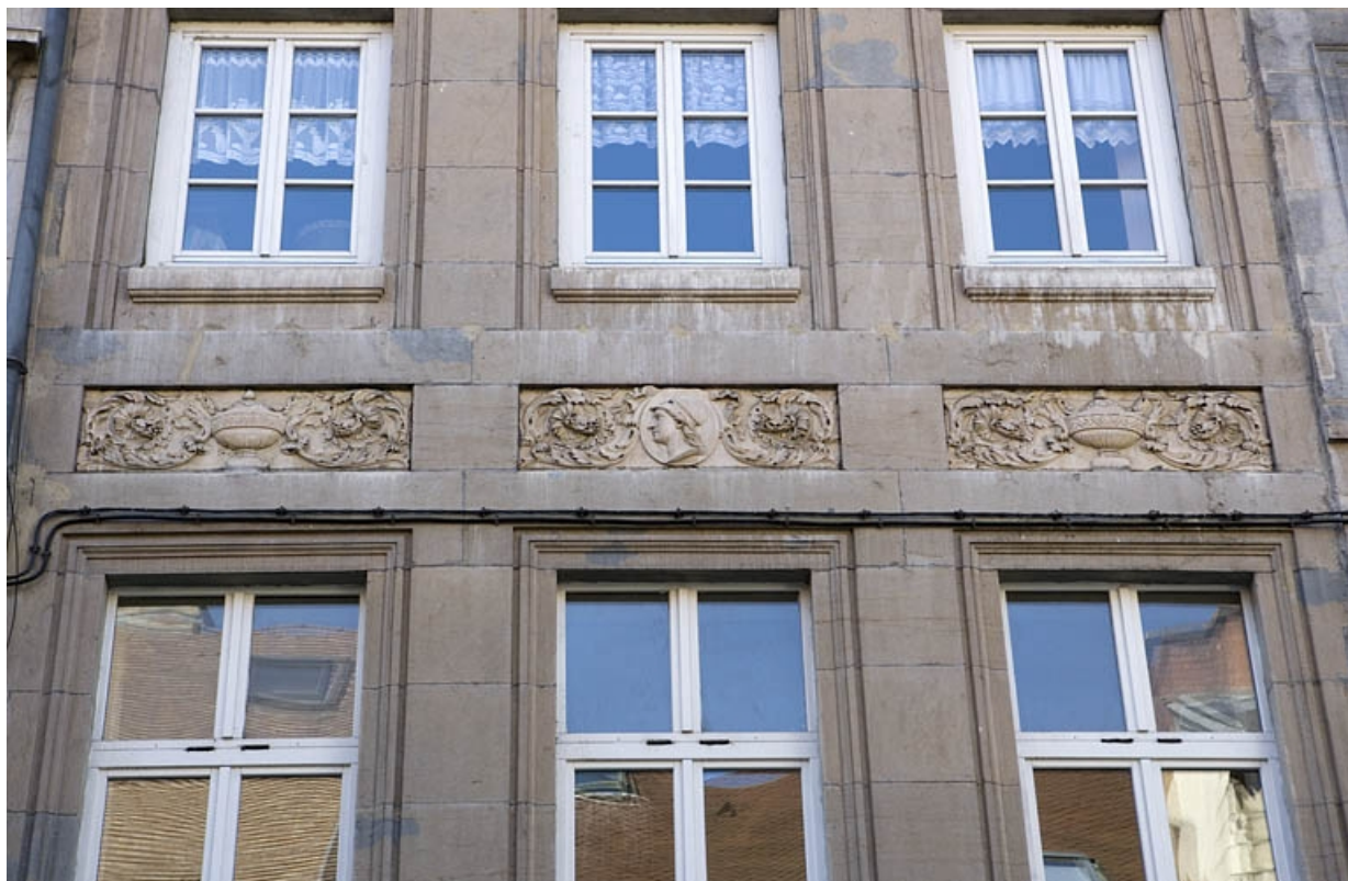
Détail du décor des tables rentrantes entre le premier et le deuxième étage.
