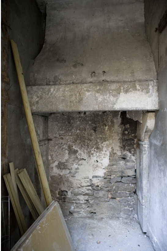
Détail de la cheminée d'une cuisine située dans l'aile droite de la deuxième cour. 25, Besançon Grande Rue 122, lieudit : îlot Granvelle
