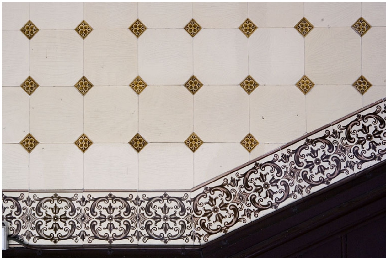
Détail d'un décor en faïence de la cage de l'escalier : bordure.
