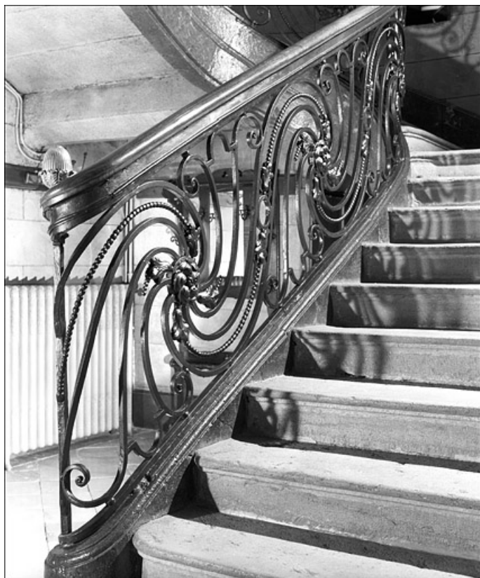
Détail de la rampe de l'escalier d'honneur de l'hôtel. 25, Besançon Grande Rue 104, lieudit : îlot Granvelle
