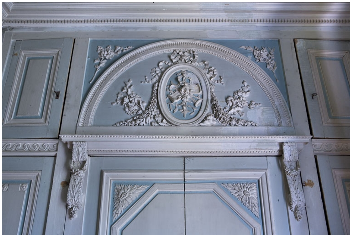
Hôtel en fond de cour : détail de la partie supérieure des lambris, mur droit de l'ancien boudoir. 25, Besançon Grande Rue 104, lieudit : îlot Granvelle
