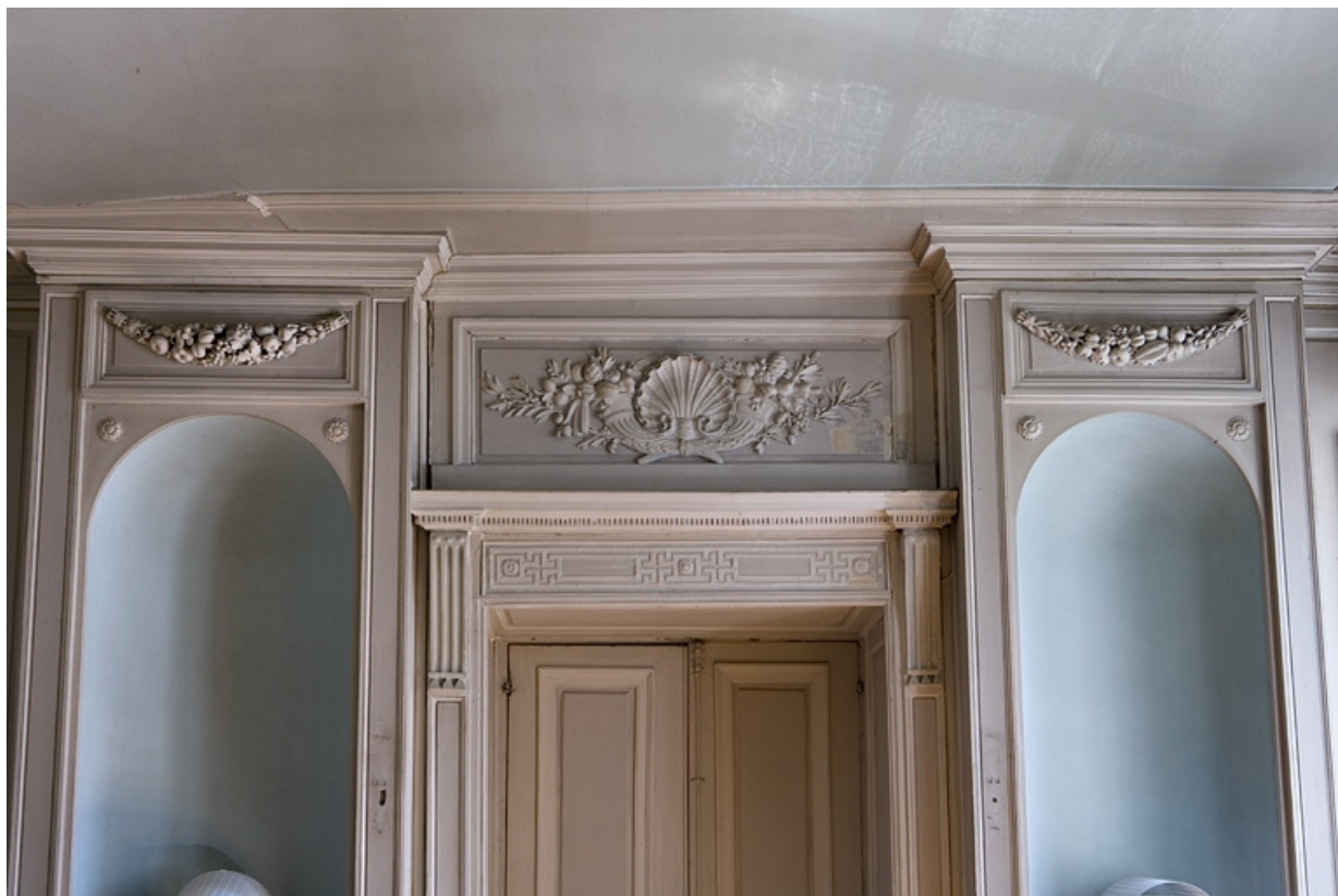
Hôtel en fond de cour, antichambre : décor du dessus de porte et des deux niches sur le mur du fond. 25, Besançon Grande Rue 104, lieudit : îlot Granvelle
