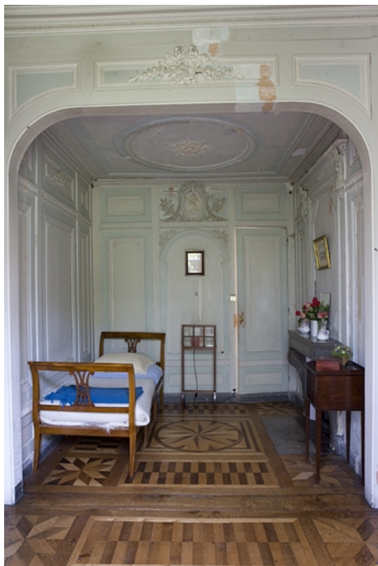
Hôtel en fond de cour : vue d'ensemble de l'ancien cabinet de toilette.
