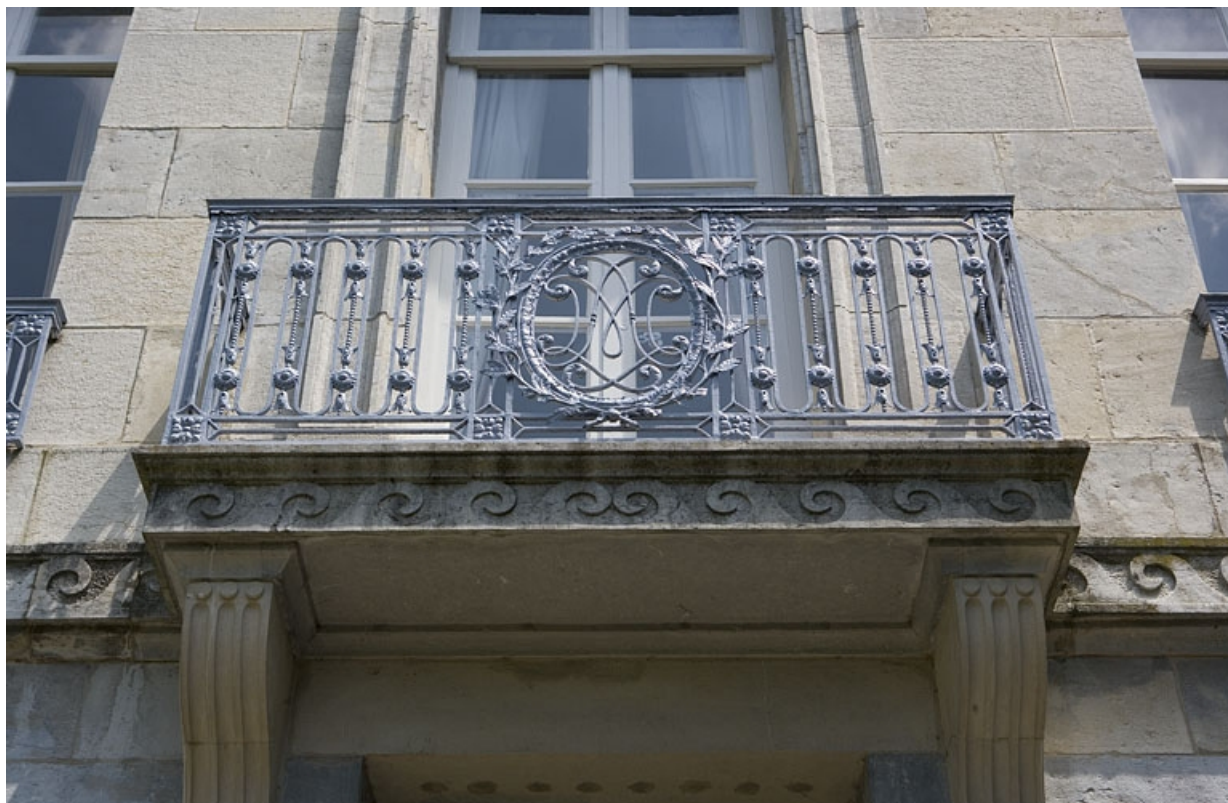
Hôtel en fond de cour : détail du balcon sur la façade postérieure. 25, Besançon Grande Rue 104, lieudit : îlot Granvelle
