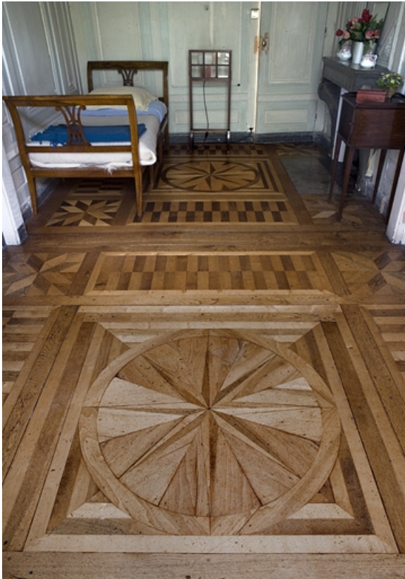
Hôtel en fond de cour : détail des planchers des anciens boudoir et cabinet de toilette. 25, Besançon Grande Rue 104, lieudit : îlot Granvelle
