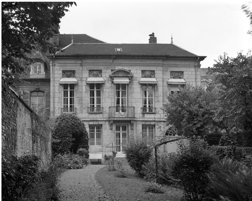
Vue d'ensemble de la façade sur jardin de l'hôtel. 25, Besançon Grande Rue 104, lieudit : îlot Granvelle
