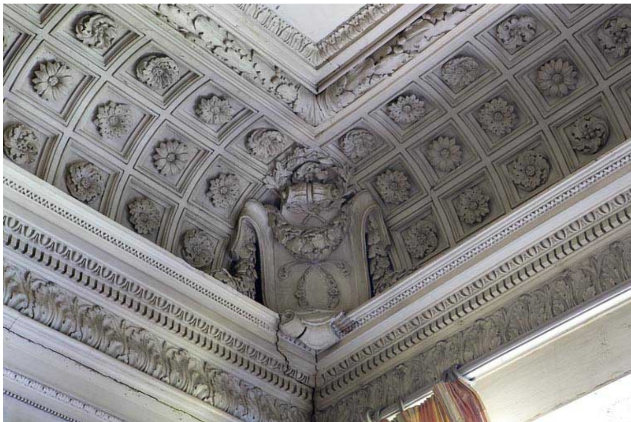
Hôtel en fond de cour, grand salon : détail d'un angle du plafond portant le monogramme C. 25, Besançon Grande Rue 104, lieudit : îlot Granvelle
