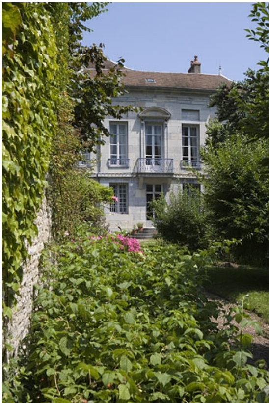
Hôtel en fond de cour : vue d'ensemble de la façade postérieure depuis le fond du jardin. 25, Besançon Grande Rue 104, lieudit : îlot Granvelle
