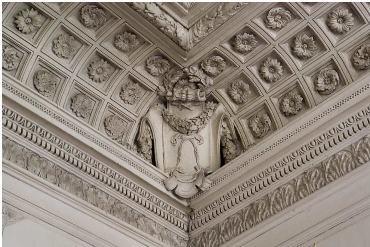
Hôtel en fond de cour, grand salon : détail d'un angle du plafond portant le monogramme L. 25, Besançon Grande Rue 104, lieudit : îlot Granvelle
