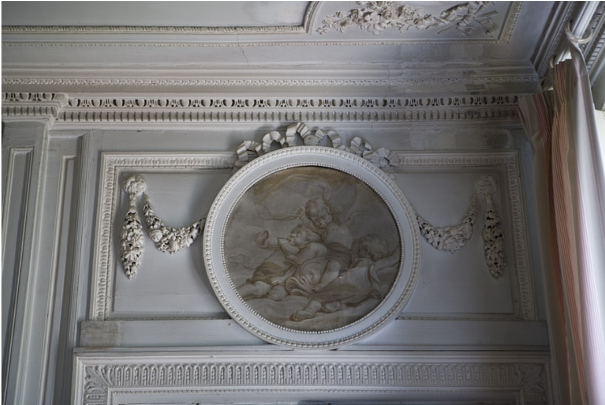
Hôtel en fond de cour, chambre : détail du médaillon peint en grisaille au-dessus de la porte donnant accès au boudoir. 25, Besançon Grande Rue 104, lieudit : îlot Granvelle
