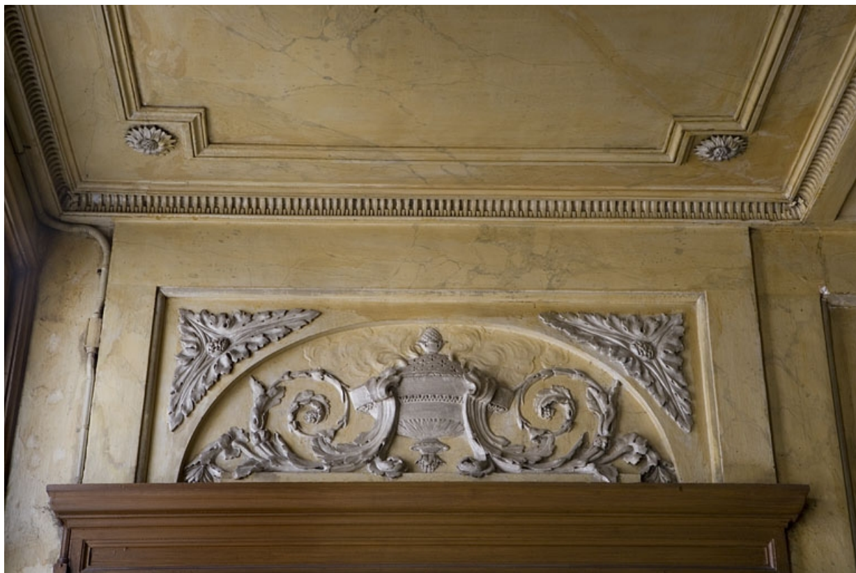
Hôtel en fond de cour, escalier : détail du décor en stuc du dessus de porte, à droite du palier. 25, Besançon Grande Rue 104, lieudit : îlot Granvelle
