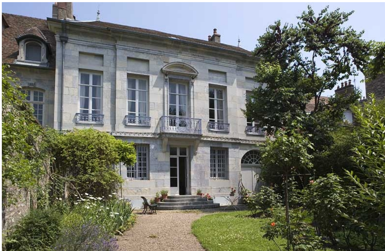
Hôtel en fond de cour : vue d'ensemble de la façade sur jardin.
