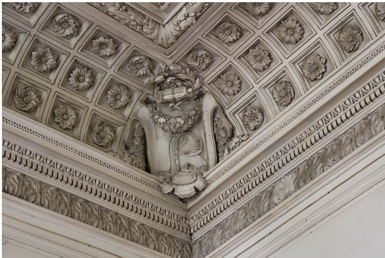
Hôtel en fond de cour, grand salon : détail d'un angle du plafond portant le monogramme B. 25, Besançon Grande Rue 104, lieudit : îlot Granvelle
