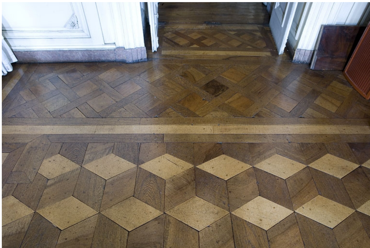
Hôtel en fond de cour : détail du plancher du grand salon vers la porte d'entrée donnant sur l'antichambre. 25, Besançon Grande Rue 104, lieudit : îlot Granvelle
