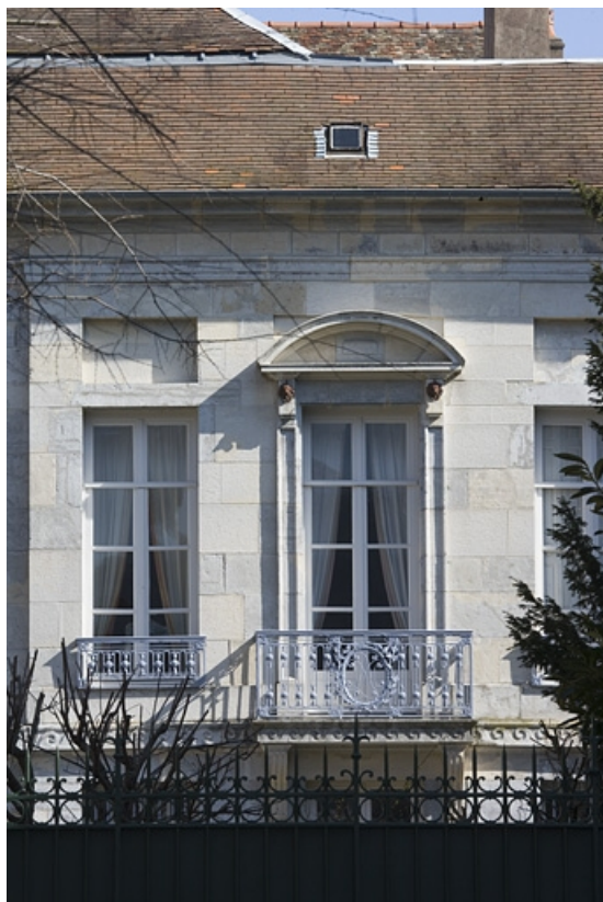
Hôtel en fond de cour : détail de la fenêtre centrale, premier étage sur jardin. 25, Besançon Grande Rue 104, lieudit : îlot Granvelle
