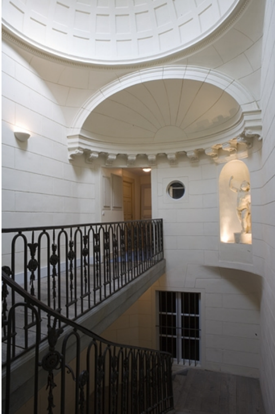
Escalier, dernier palier : détail de la demi-coupole. 25, Besançon Grande Rue 102, lieudit : îlot Granvelle
