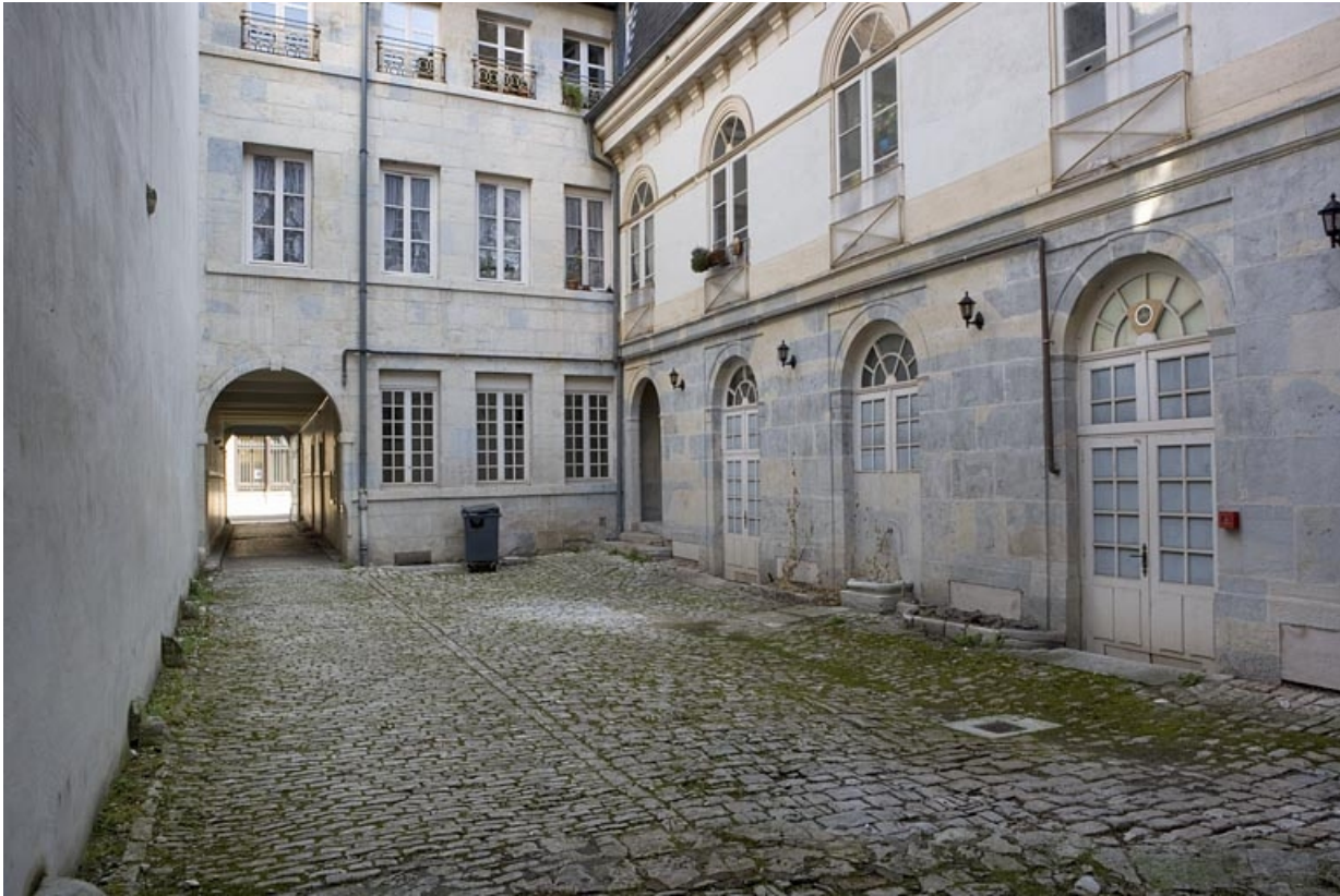
Façade postérieure du logis sur rue et aile sur cour : rez-de-chaussée et premier étage. 25, Besançon Grande Rue 102, lieudit : îlot Granvelle
