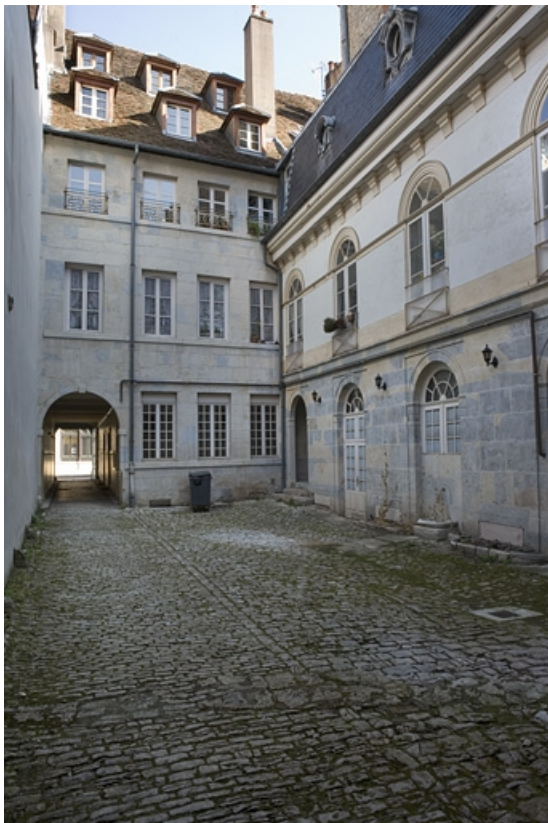
Façade postérieure du logis sur rue et l'aile sur cour. 25, Besançon Grande Rue 102, lieudit : îlot Granvelle
