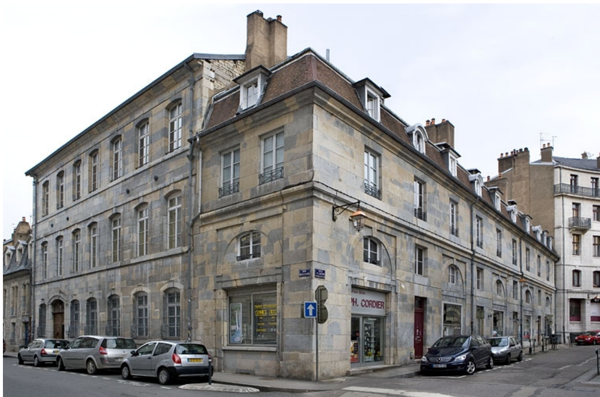
Vue d'ensemble du logis principal à l'angle des deux rues.
