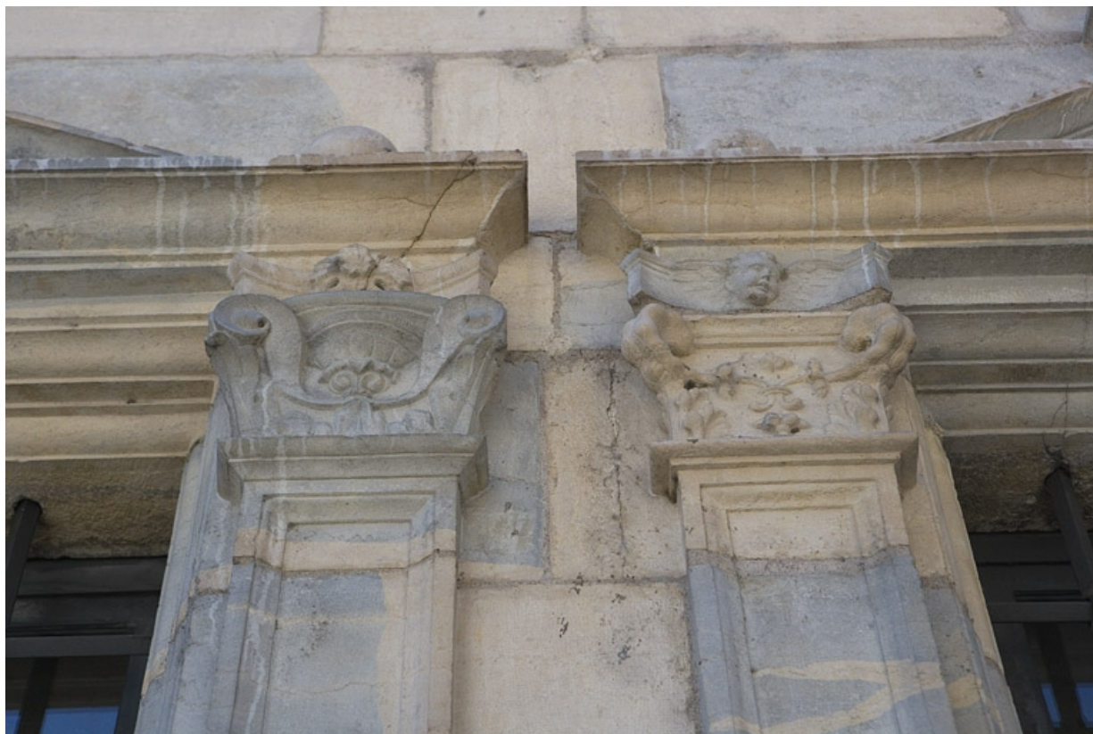
Façade principale : détail de deux chapiteaux encadrant les fenêtres du rez-de-chaussée.
