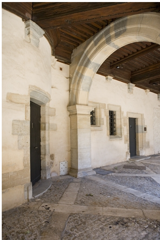
Détail de l'extrémité du portique nord-est.
