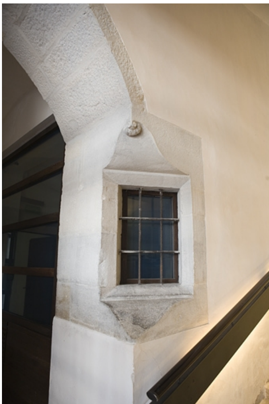
Escalier : fenêtre aménagée au rez-de-chaussée dans le mur d'échiffre.
