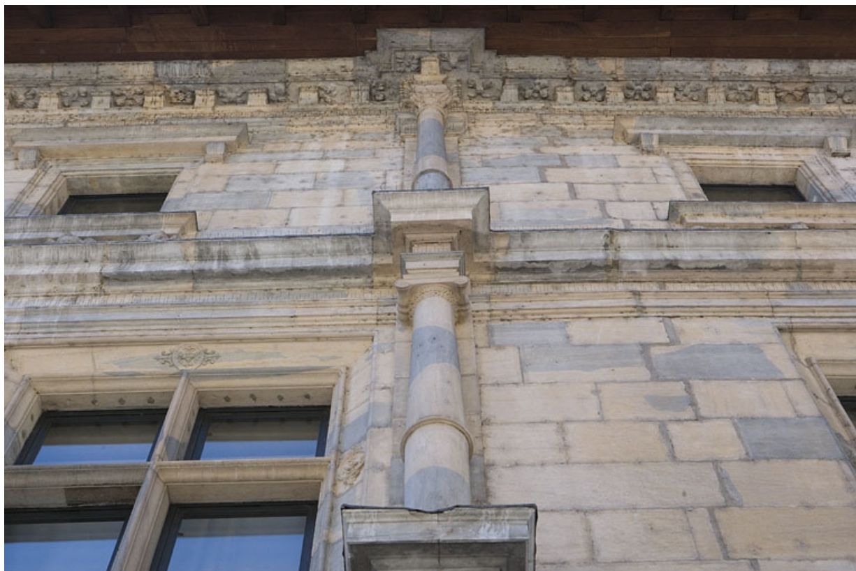
Façade principale : détail de deux colonnes ionique et composite superposées, en contre-plongée. 25, Besançon, 96 Grande Rue, lieudit : îlot Granvelle
