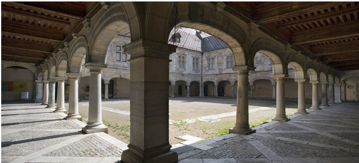
Vue de la cour depuis l'angle est du portique.
