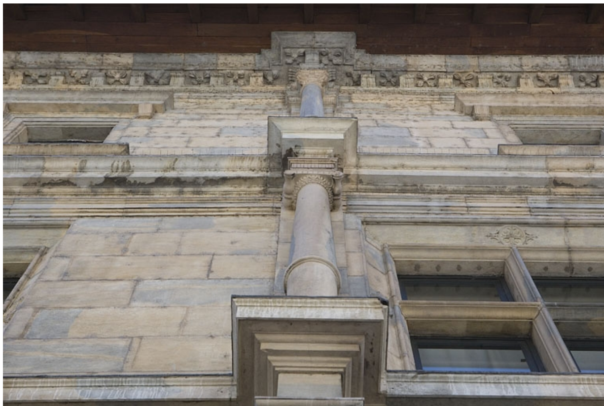
Façade principale : détail de deux colonnes ionique et composite superposées, en contre-plongée.
