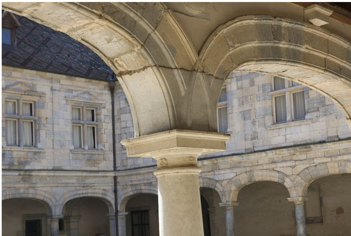
Détail de l'angle sud du portique depuis le nord-ouest.
