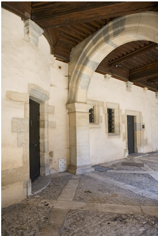
Détail de l'extrémité du portique nord-est.
