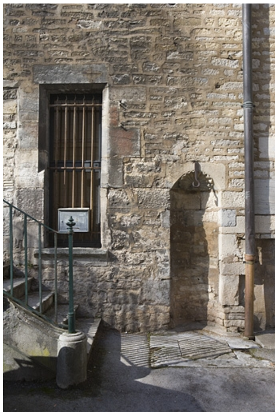
Façade latérale gauche : puits donnant sur l'ancienne cour des communs.
