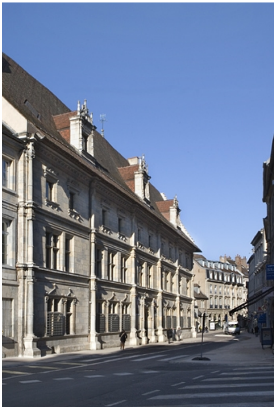
Façade principale, de trois quarts gauche : vue rapprochée.
