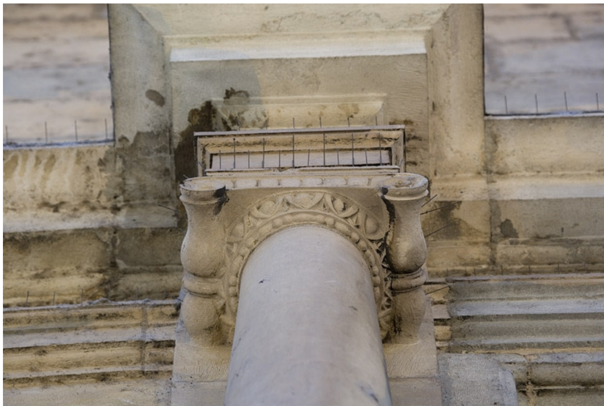
Façade principale : détail d'un chapiteau ionique, en contre-plongée.
