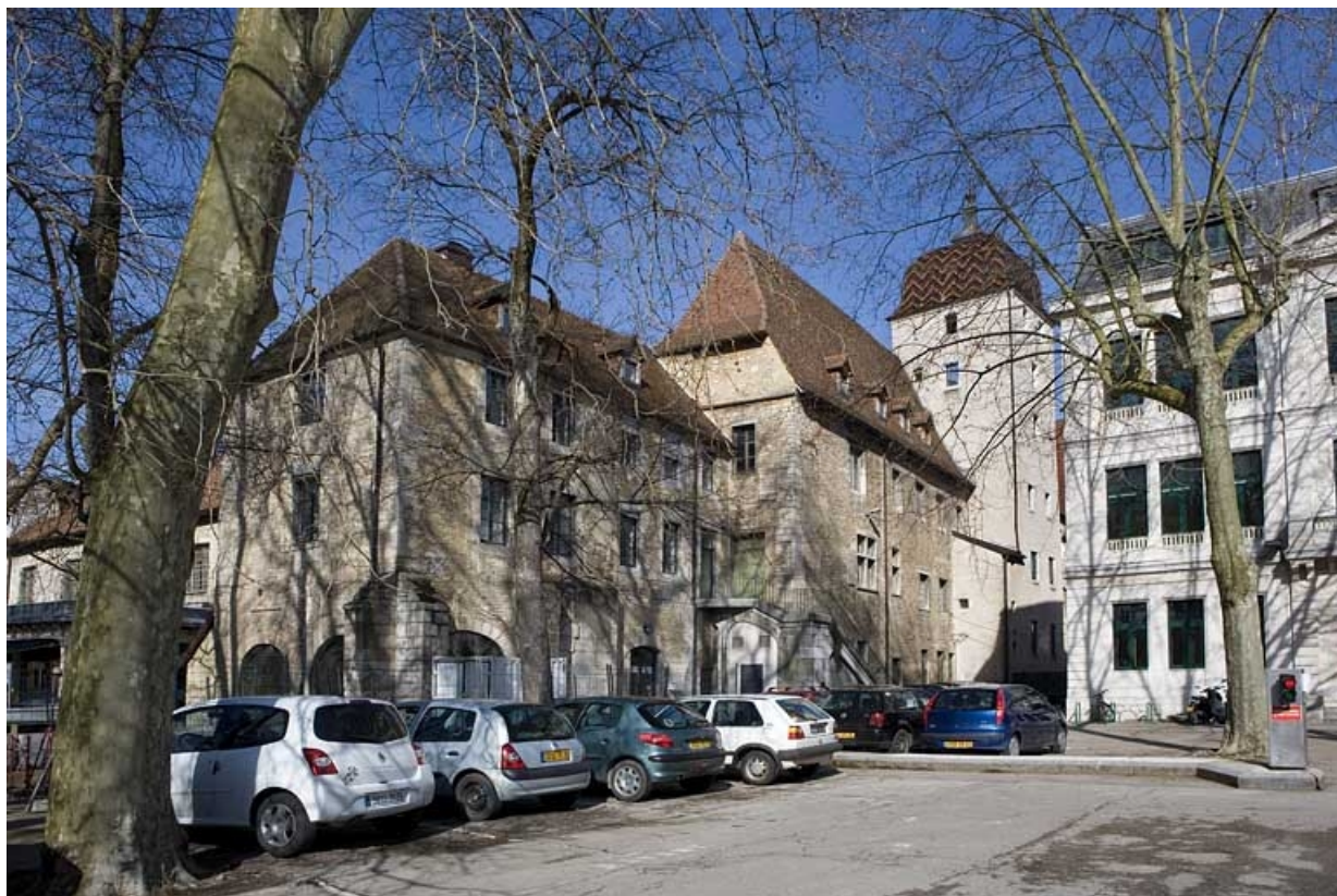
Vue d'ensemble de la façade latérale gauche donnant sur l'ancienne cour des communs.
