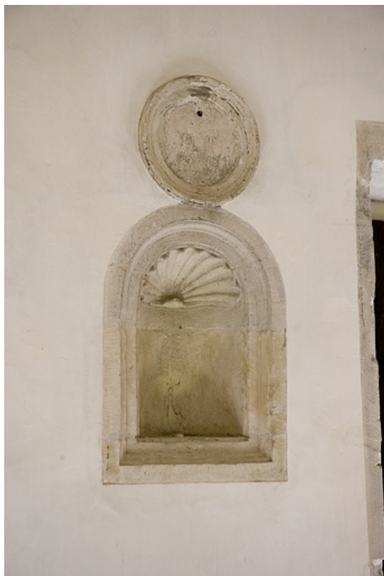
Escalier : niche entre les deux fenêtres du premier palier.
