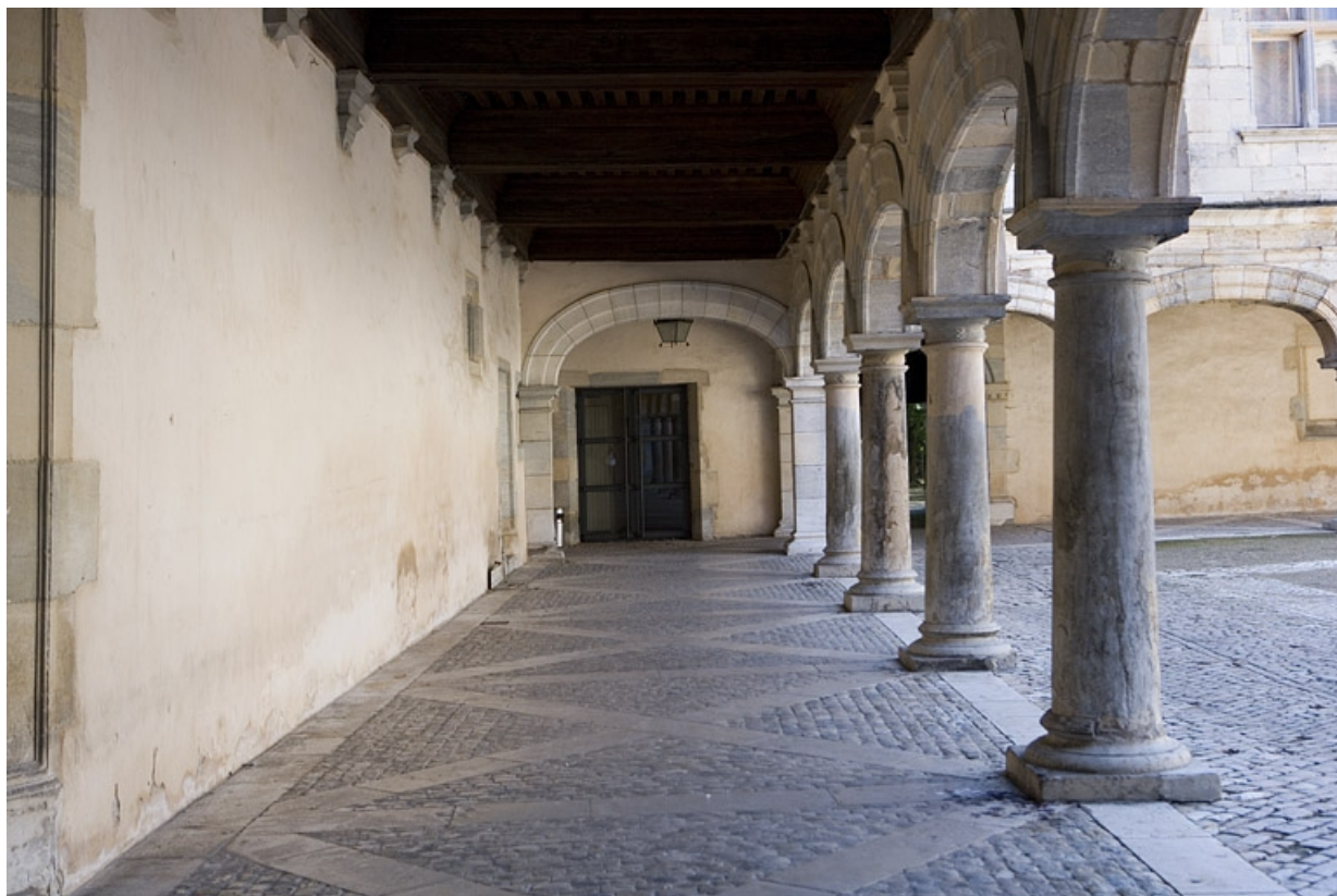
Vue du portique depuis le portail d'entrée.
