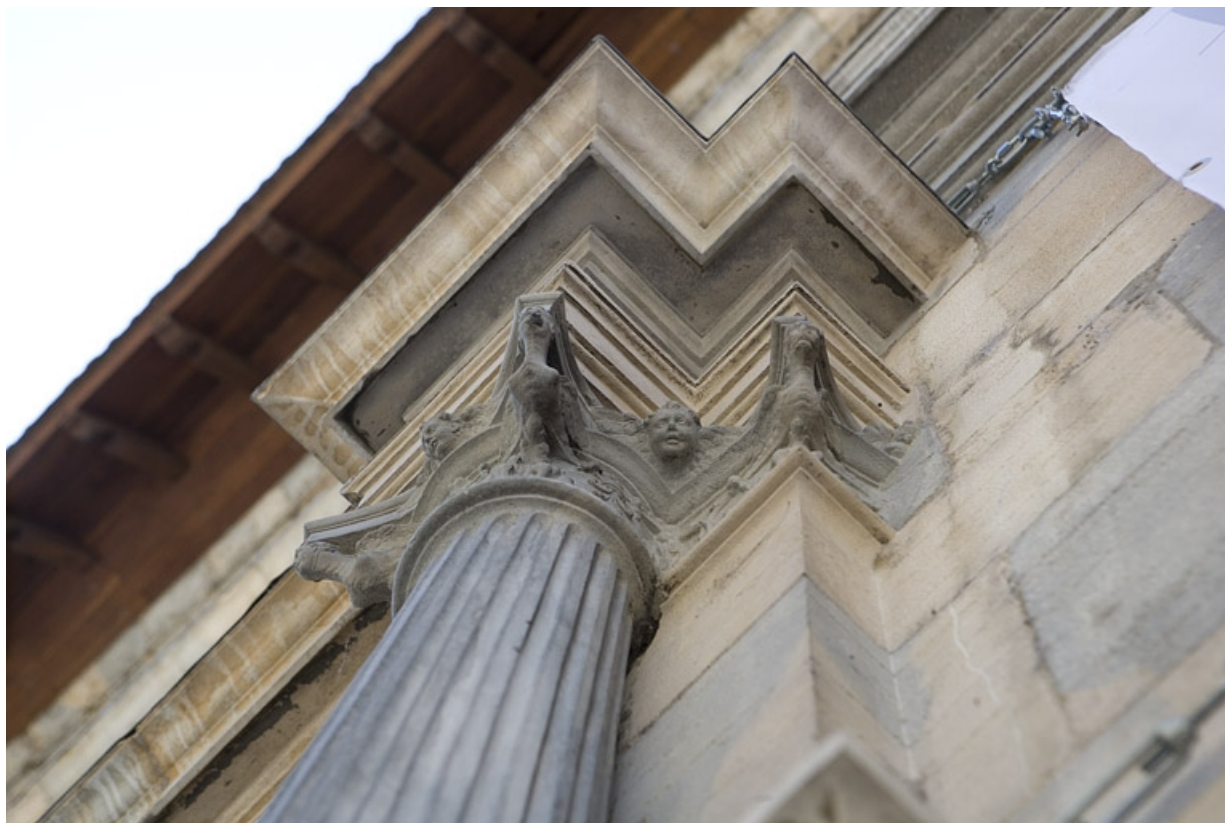
Façade principale : détail du chapiteau d'une colonne encadrant le portail d'entrée, vue rapprochée.
