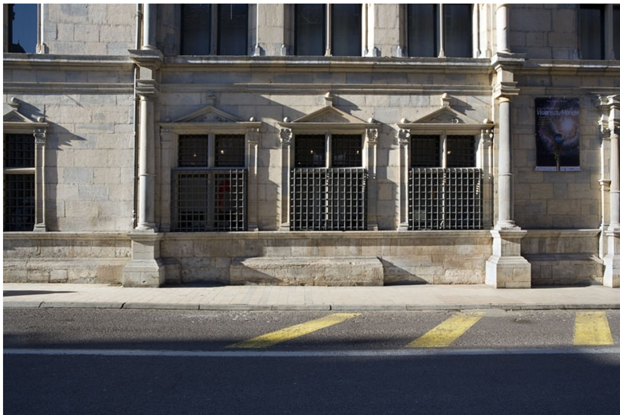
Façade principale : détail d'une partie du rez-de-chaussée à gauche du portail d'entrée.
