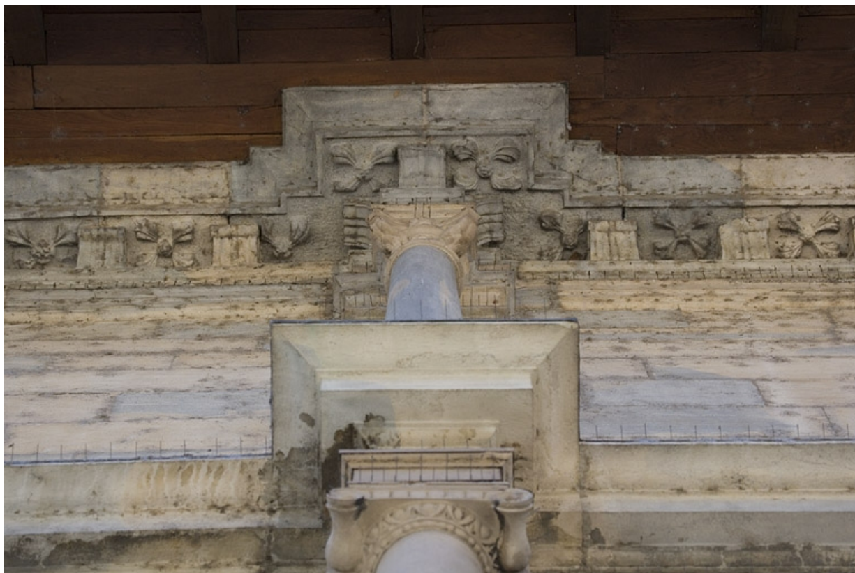
Façade principale : détail de deux chapiteaux ionique et composite, en contre-plongée.
