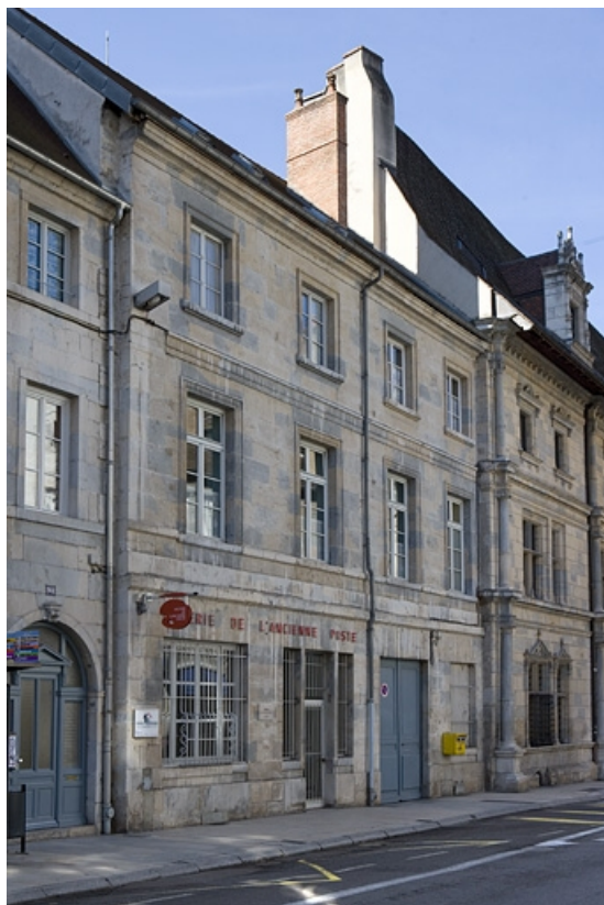
Immeuble du XIXe siècle à l'emplacement des anciens communs du palais, dits "le petit Granvelle". 25, Besançon, 96 Grande Rue, lieudit : îlot Granvelle
