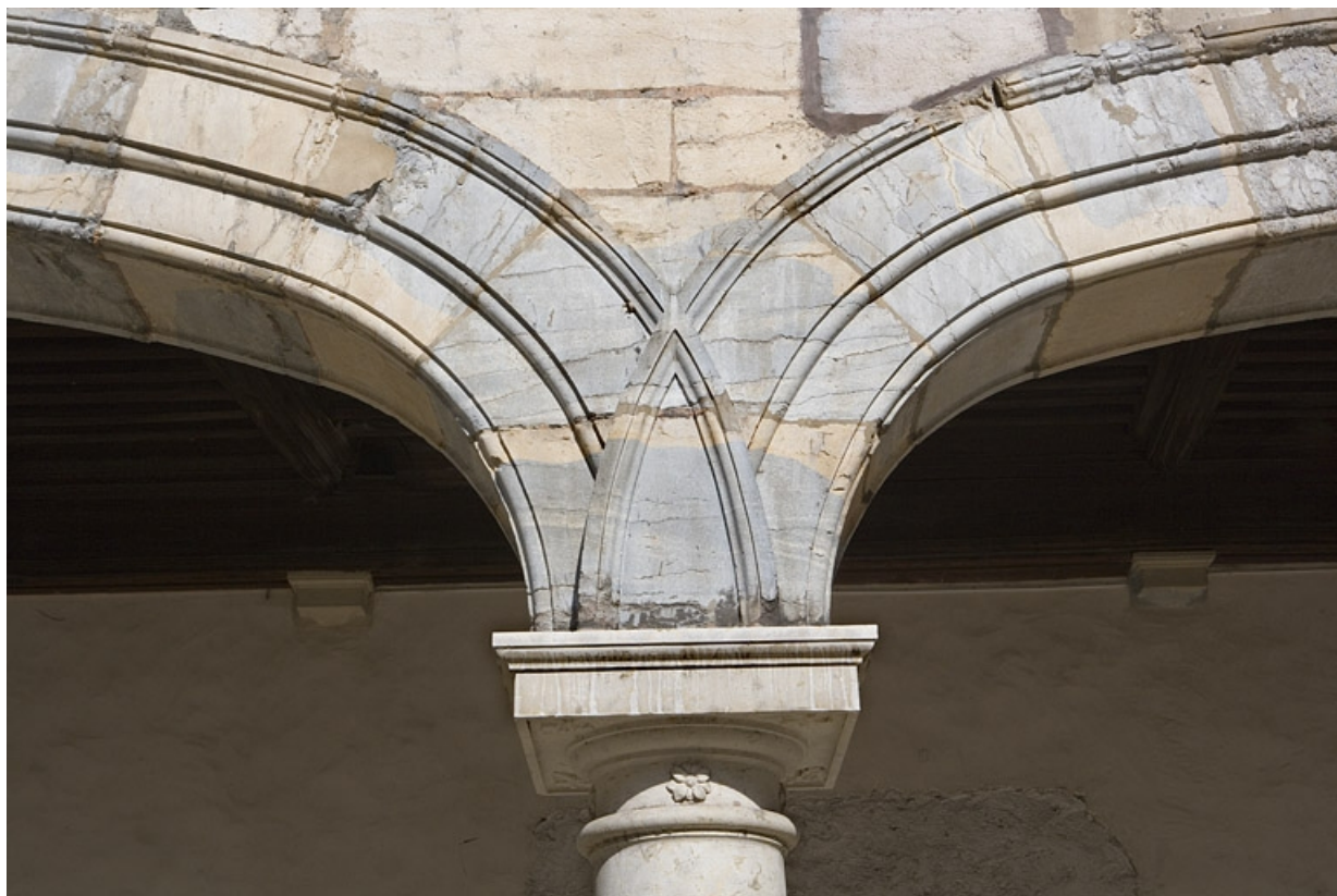
Détail d'un chapiteau du portique, de face.
