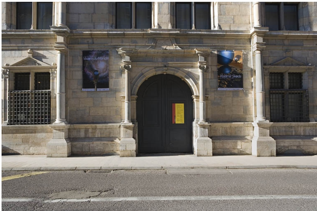
Façade principale : détail du portail d'entrée.
