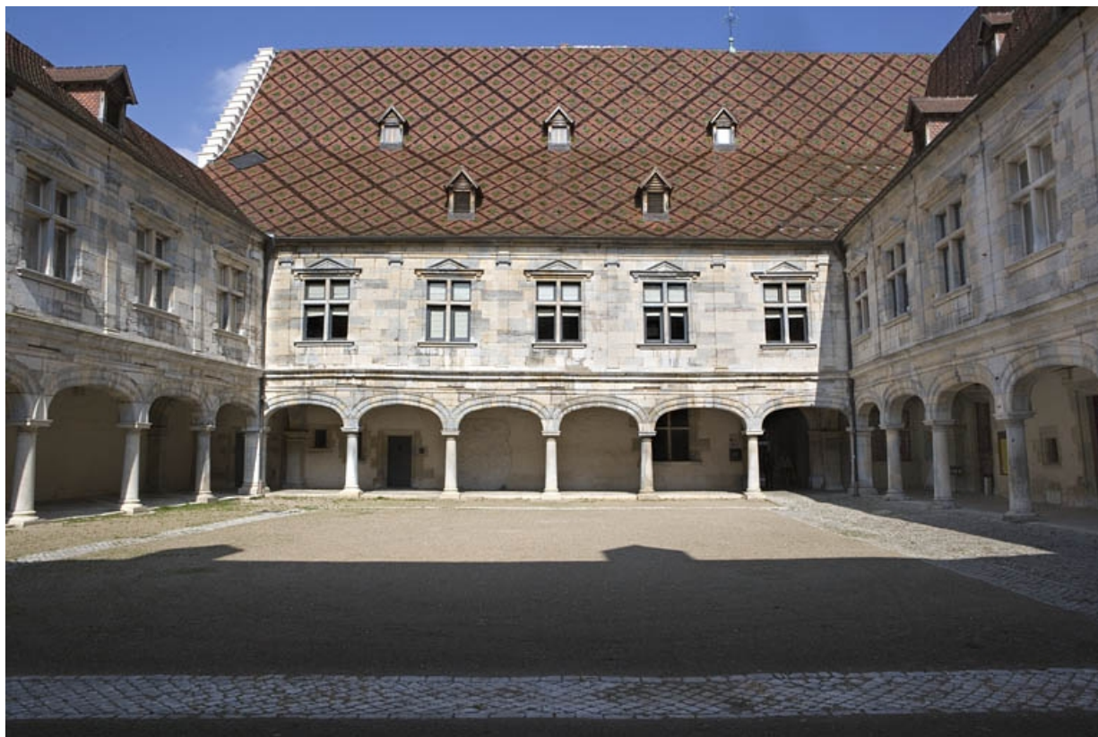
Vue d'ensemble des bâtiments depuis le fond de la cour.
