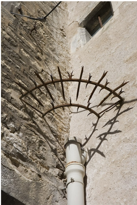
Façade latérale gauche : détail d'un élément horizontal en ferronnerie non identifié. 25, Besançon, 96 Grande Rue, lieudit : îlot Granvelle
