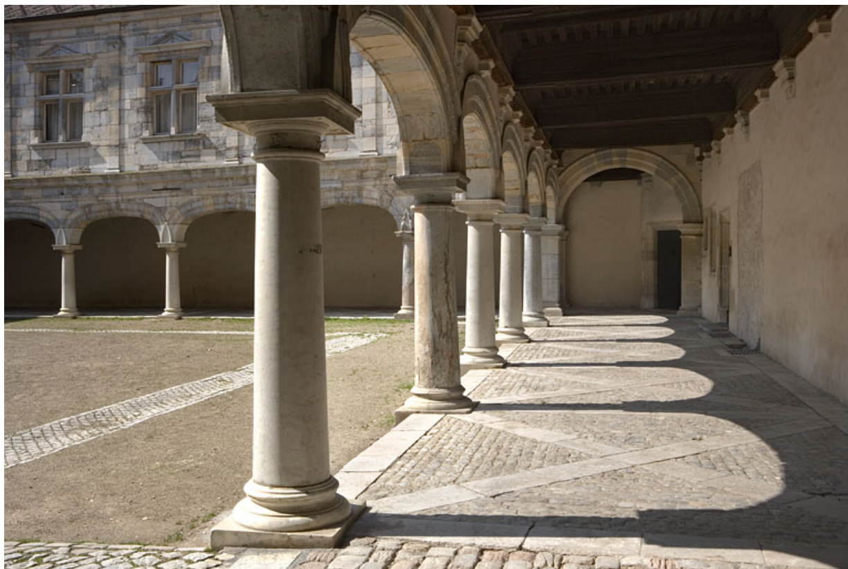
Vue d'une partie de la galerie nord-est.
