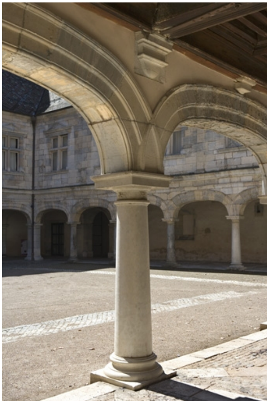
Détail du portique sud-ouest depuis le nord-ouest. 25, Besançon, 96 Grande Rue, lieudit : îlot Granvelle
