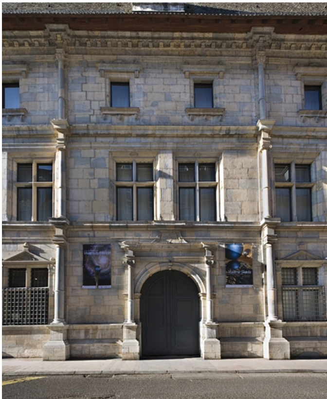
Façade principale : détail de la travée centrale.
