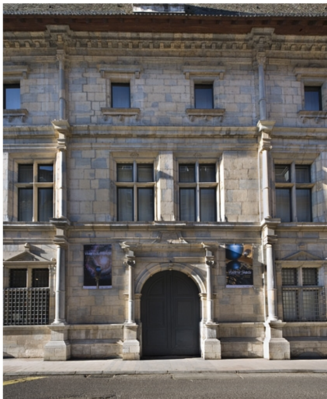
Façade principale : détail de la travée centrale.
