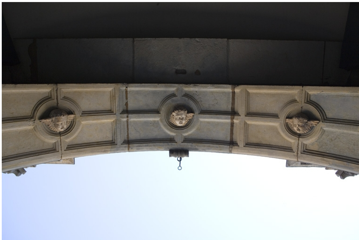
Arc du portail d'entrée : détail de l'intrados décoré de têtes d'anges, depuis le passage cocher.
