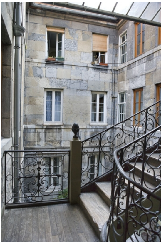
Façades sur cour du logis depuis l'escalier à cage ouverte. 25, Besançon, 1 rue de la Vieille Monnaie, lieudit : îlot Ronchaux
