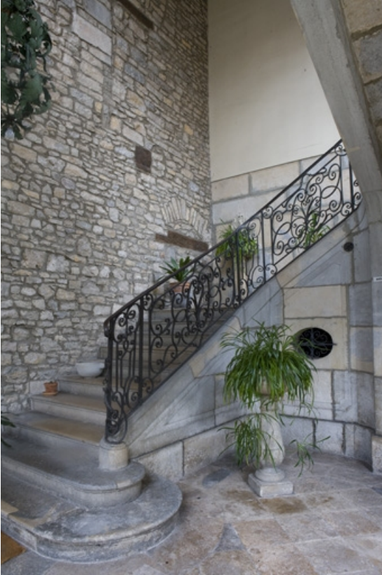
Intérieur : détail de la première volée de l'escalier d'honneur. 25, Besançon, 3 rue de la Vieille Monnaie, lieudit : îlot Ronchaux
