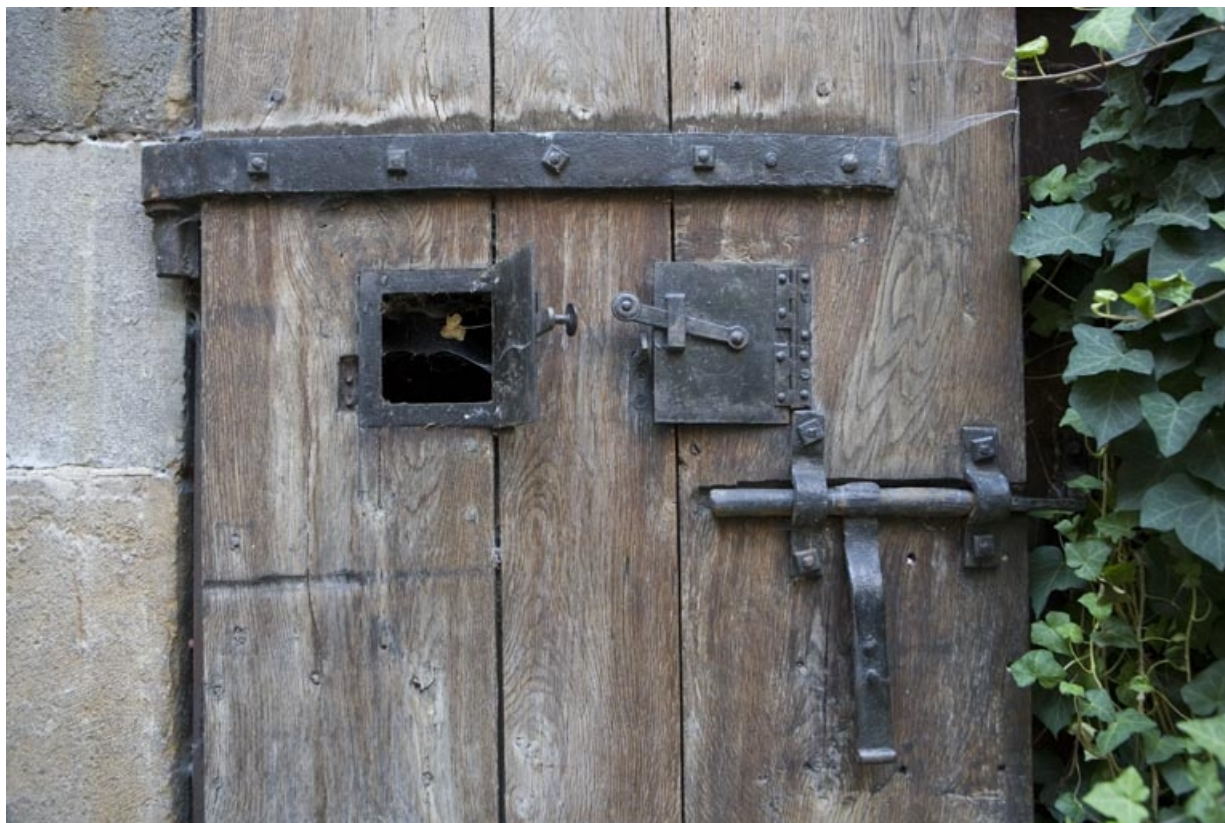
Porte dans le soubassement de l'escalier extérieur : détail de la fermeture et des guichets.
