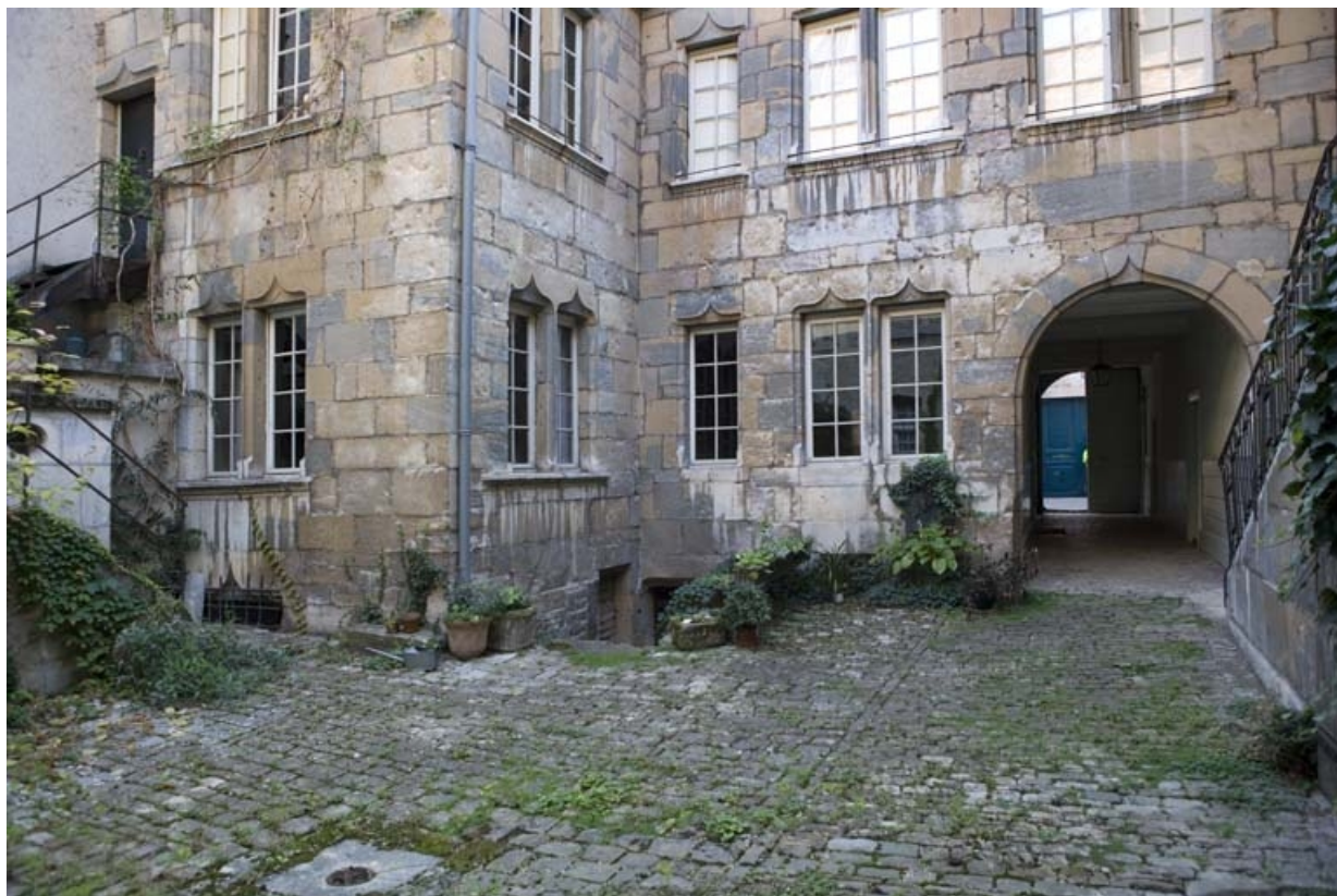
Rez-de-chaussée de la façade postérieure du logis, de trois quarts droit.
