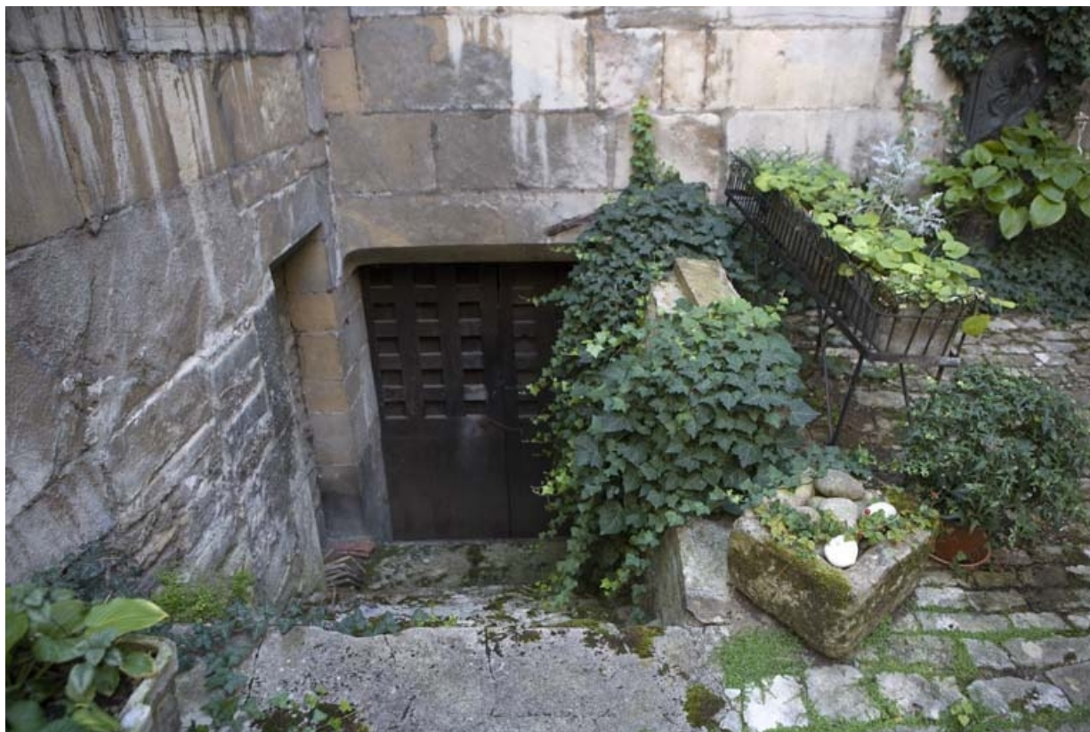
Façade postérieure du logis : entrée de cave.
