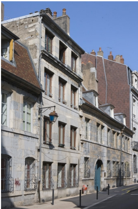
Vue d'ensemble éloignée du logis principal sur rue, de trois quarts gauche.
