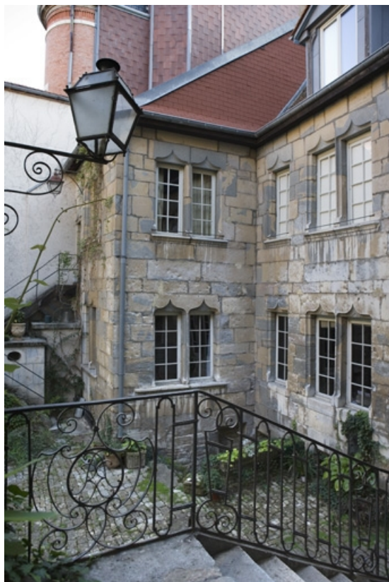
Façade postérieure du logis depuis l'escalier extérieur, de trois quarts droit. 25, Besançon, 36 rue Renan, lieudit : îlot Ronchaux
