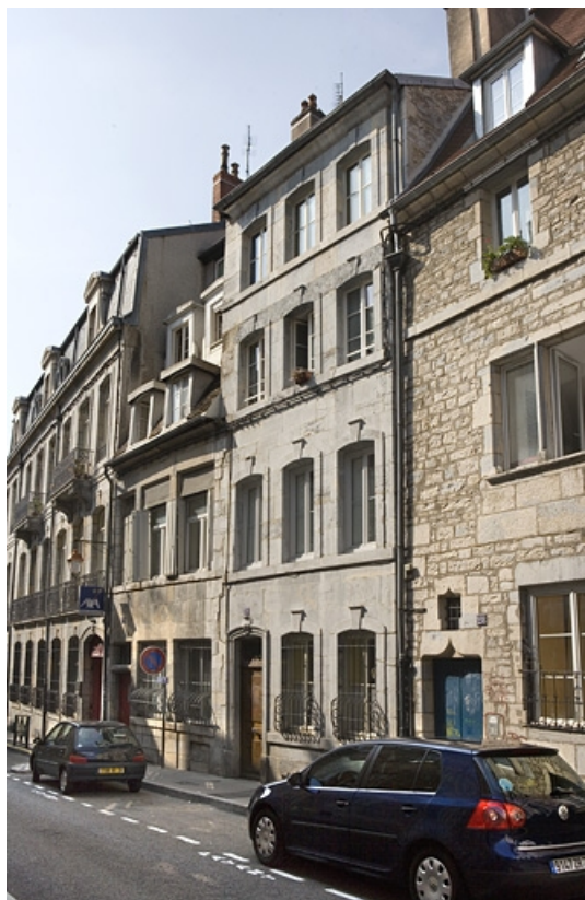
Vue d'ensemble de la façade sur rue, de trois quarts droit.
