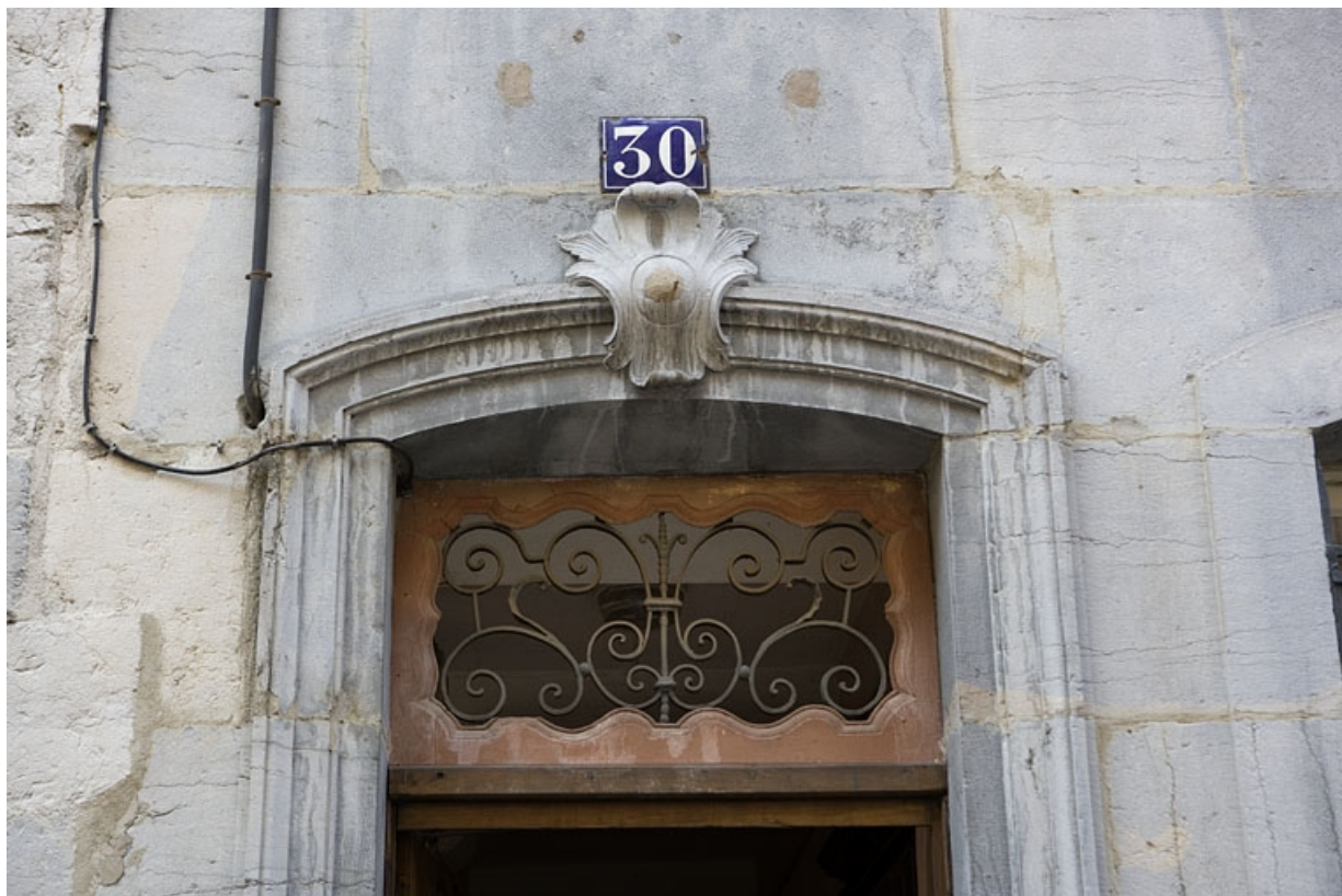
Façade sur rue : détail du dessus de porte du couloir d'entrée.
