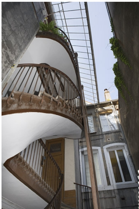
Vue d'ensemble de l'escalier à cage ouverte de la première cour.
