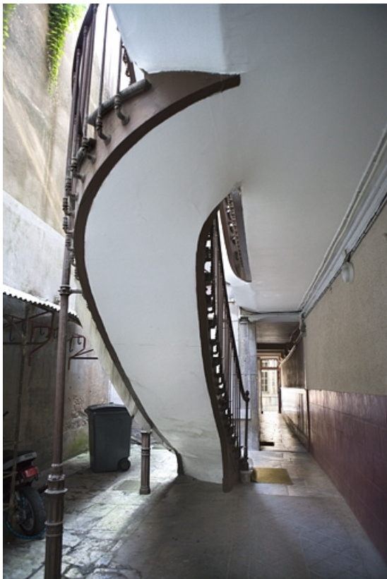
Détail de l'escalier à cage ouverte sur cour, depuis le fond de la première cour. 25, Besançon, 30 rue Renan, lieudit : îlot Ronchaux
