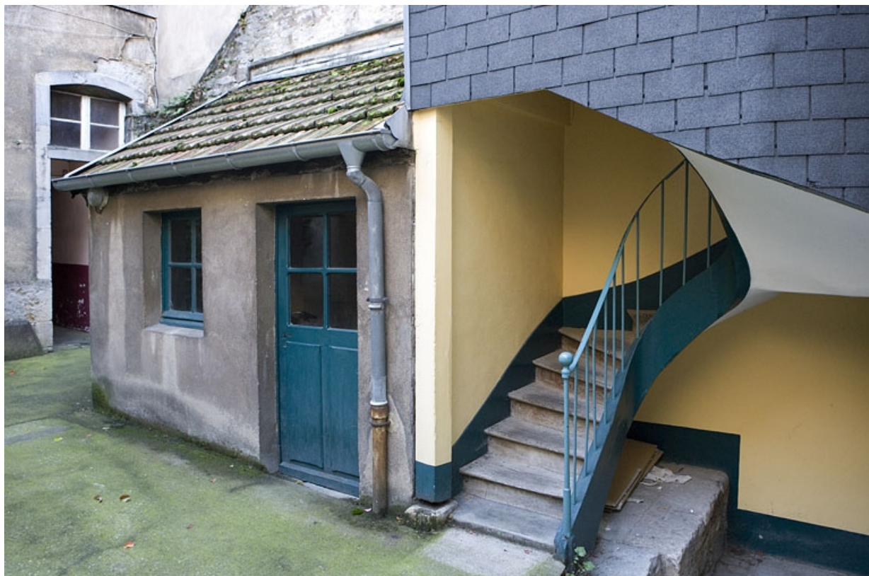
Détail de la buanderie dans la deuxième cour. 25, Besançon, 30 rue Renan, lieudit : îlot Ronchaux
