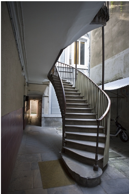
Détail de l'escalier à cage ouverte sur cour, depuis l'entrée de la première cour. 25, Besançon, 30 rue Renan, lieudit : îlot Ronchaux
