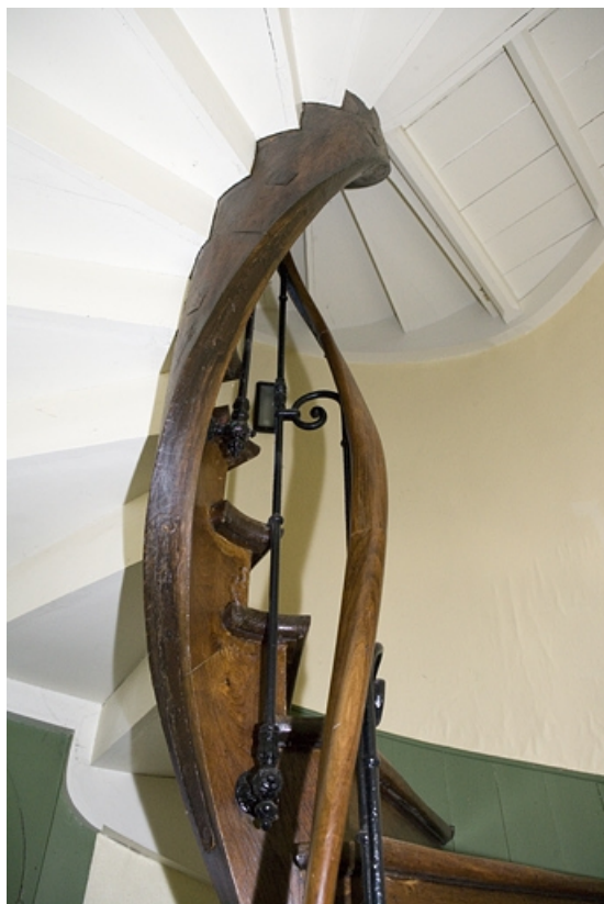
Détail de la rampe et du limon de l'escalier situé dans la tour.
