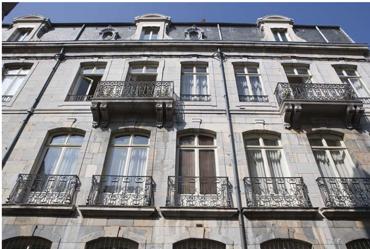
Façade antérieure du logis principal à partir du premier étage, de face.
