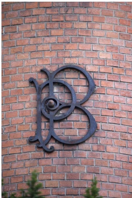
Détail des initiales en fer apposées sur la tour d'escalier.
