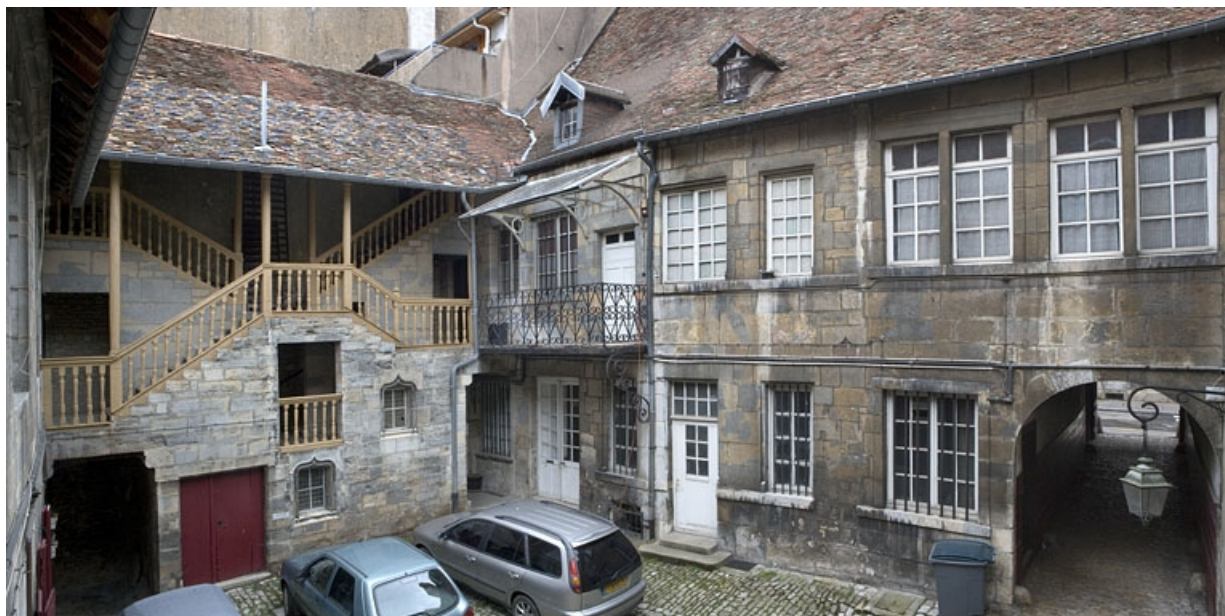
Vue d'ensemble de la façade postérieure du logis sur rue et de l'escalier à cage ouverte sur cour. 25, Besançon, 20 rue Renan, lieudit : îlot Ronchaux
