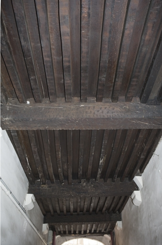
Détail du plafond à la française du passage cocher.
