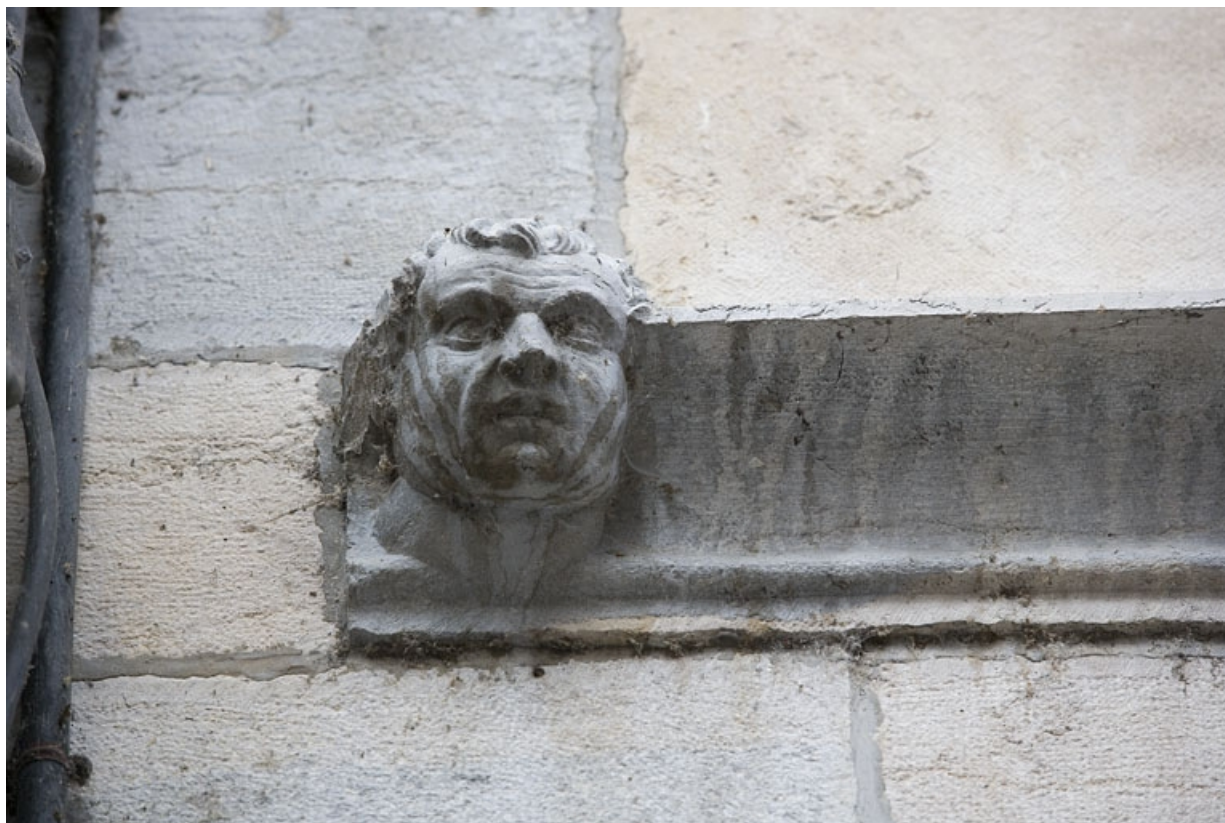
Façade sur rue : détail d'une tête d'homme à l'extrémité gauche du bandeau d'appui.
