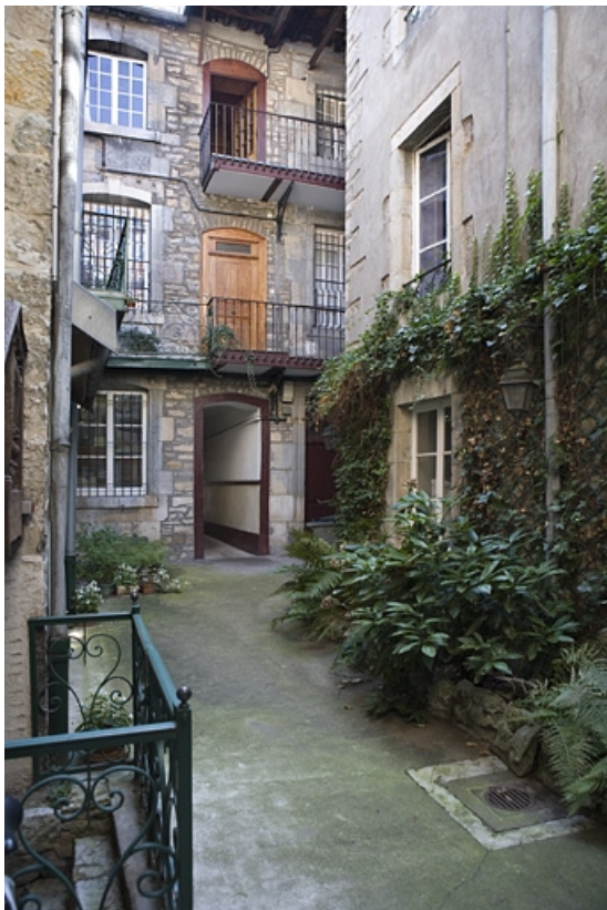
Vue d'ensemble de la façade postérieure du logis sur rue depuis le fond de la cour.
