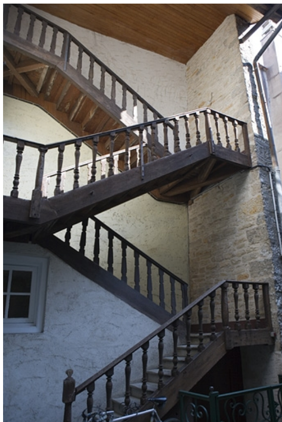
Détail de l'escalier à cage ouverte du logis secondaire.
