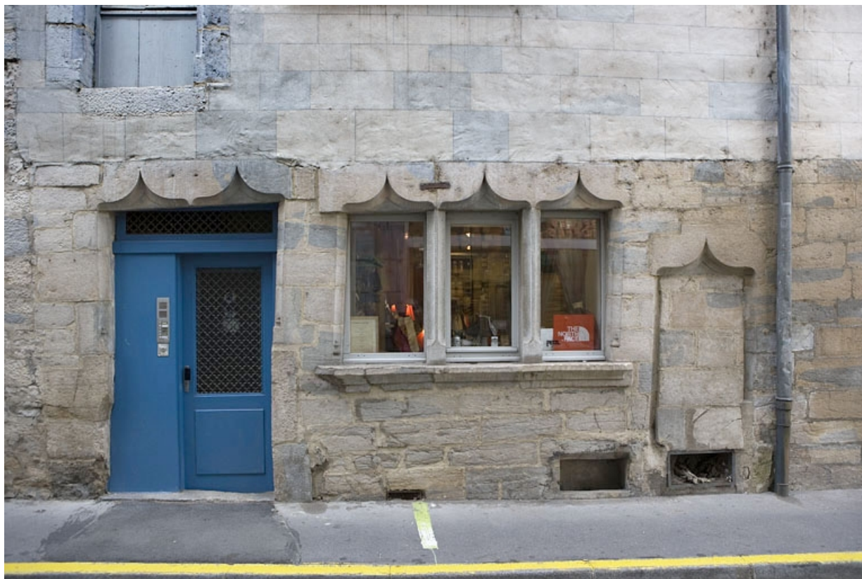
Détail du rez-de-chaussée de la façade sur la rue Renan.
