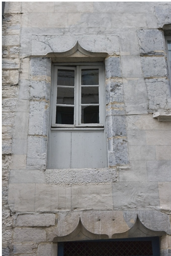
Rue Renan, détail d'une ancienne porte transformée en fenêtre au premier étage.
