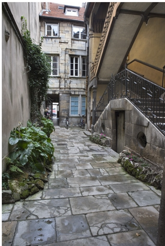
Façade postérieure du logis principal sur cour.
