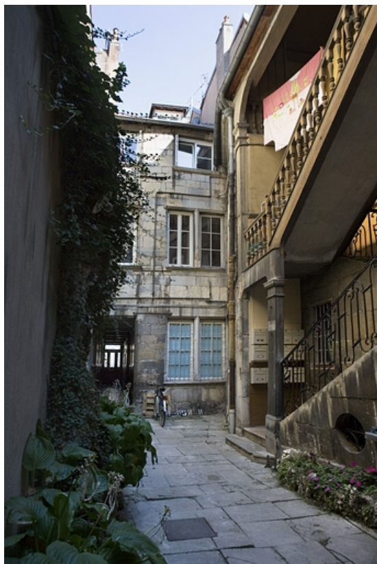
Vue d'ensemble de la façade postérieure du logis principal, depuis le fond de la cour. 25, Besançon Grande Rue 136, lieudit : îlot Ronchaux
