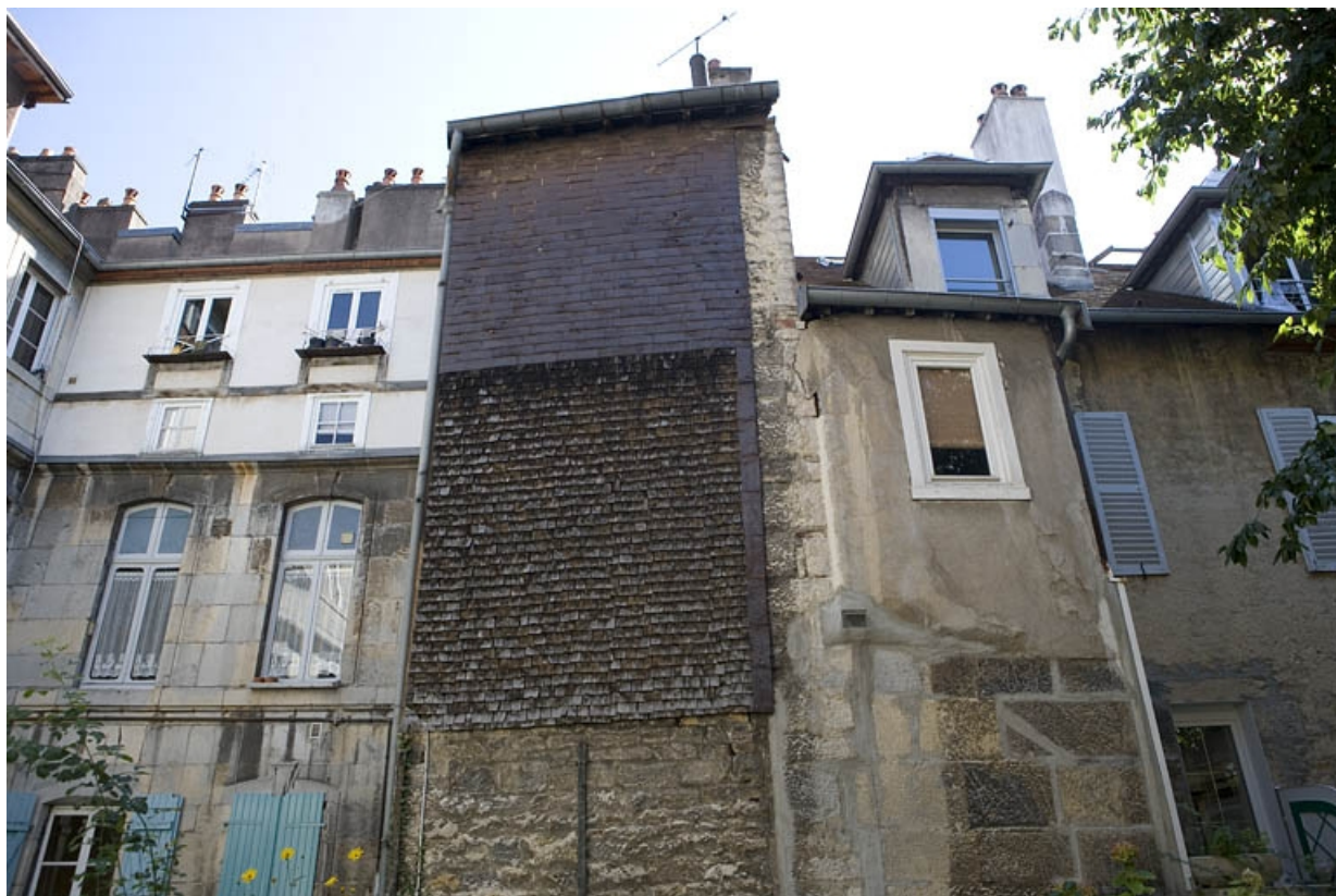
Détail de la façade postérieure de l'aile des bûchers sur jardin.
