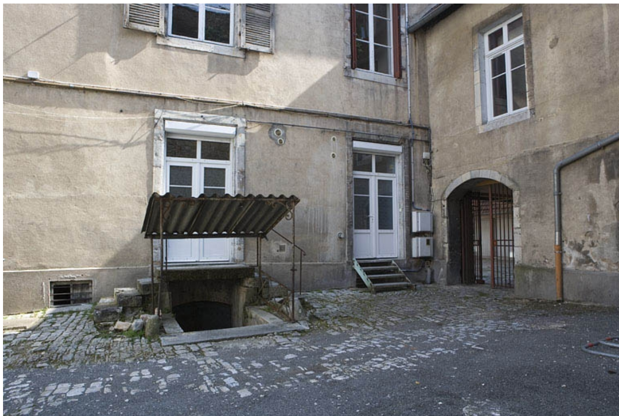
Cour secondaire donnant rue Ronchoux : détail d'une entrée de cave.
