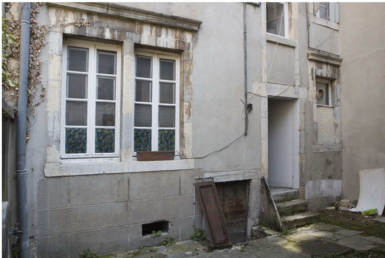
Façade postérieure du logis principal sur rue, partie droite : détail des fenêtres du rez-de-chaussée. 25, Besançon Grande Rue 132, 130, 128, lieudit : îlot Ronchaux
