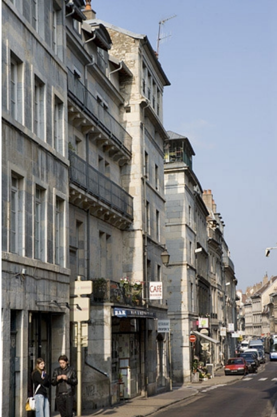
Partie centrale de la façade sur rue, de trois quarts gauche. 25, Besançon Grande Rue 132, 130, 128, lieudit : îlot Ronchaux
