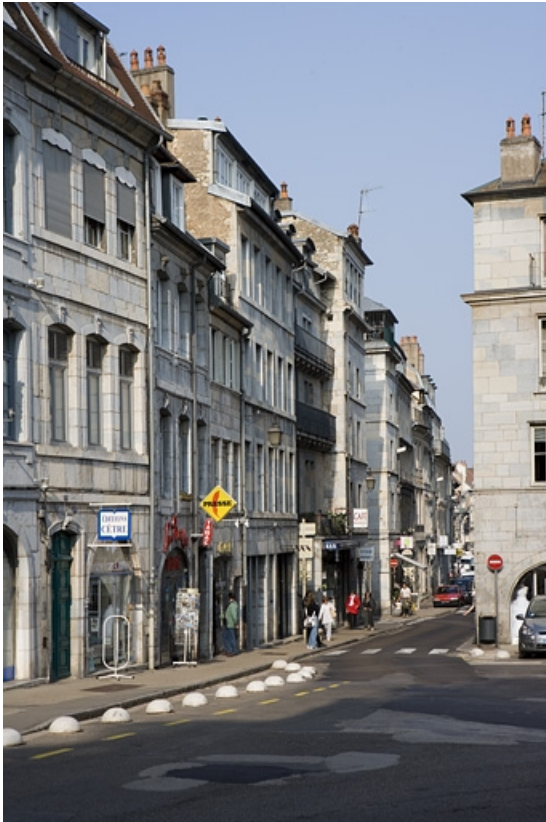
Façade sur rue, vue éloignée de trois quarts gauche.
