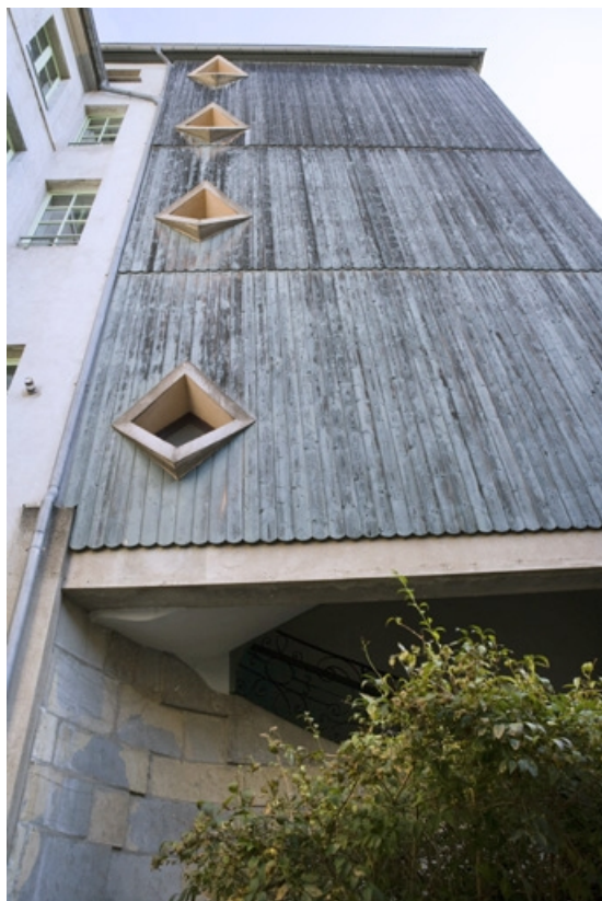
Escalier à cage ouverte sur cour : détail de la fermeture de la cage.
