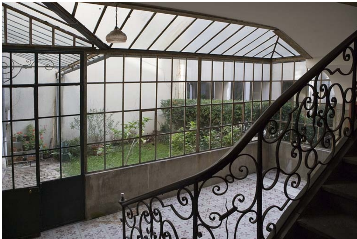
Vue intérieure de la verrière protégeant le rez-de-chaussée de la cage d'escalier.
