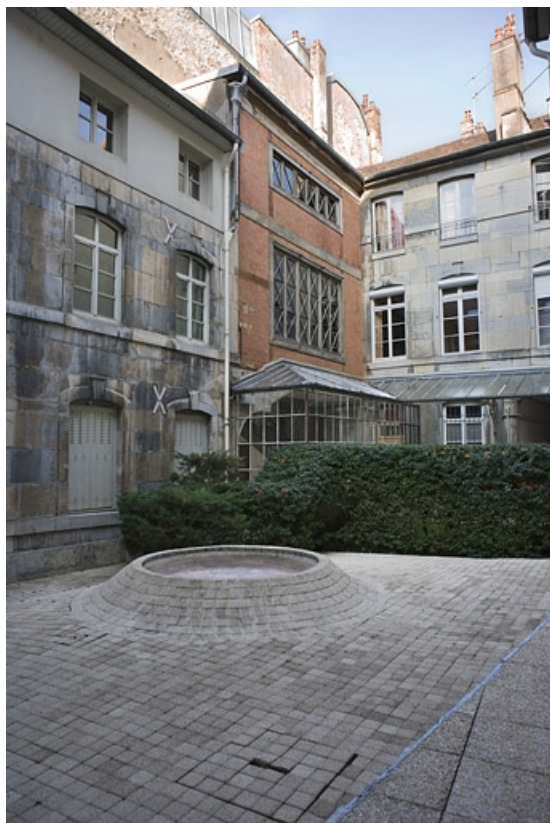
Vue d'ensemble des façades sur cour du logis principal, de trois quarts droit. 25, Besançon, 15 rue Ronchaux, lieudit : îlot Ronchaux
