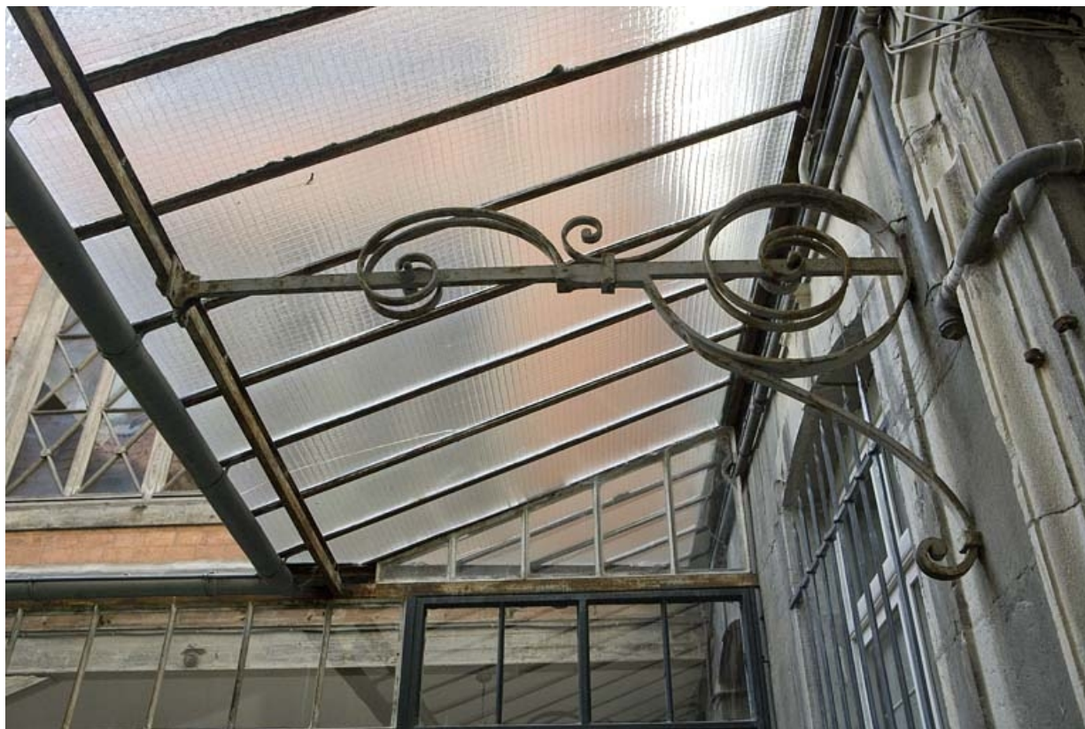
Détail de l'auvent situé sur la façade postérieure du logis principal.
