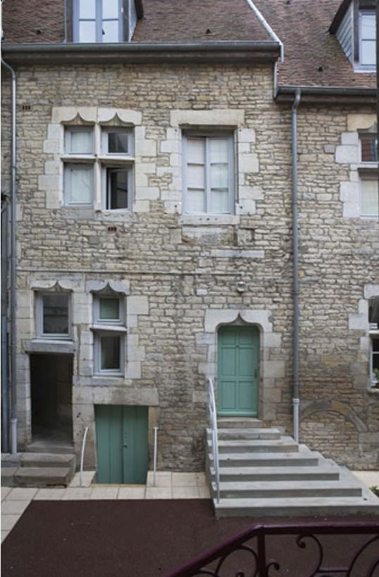
Vue d'une partie de l'aile gauche sur cour, de face. 25, Besançon Grande Rue 140, lieudit : îlot Ronchaux
