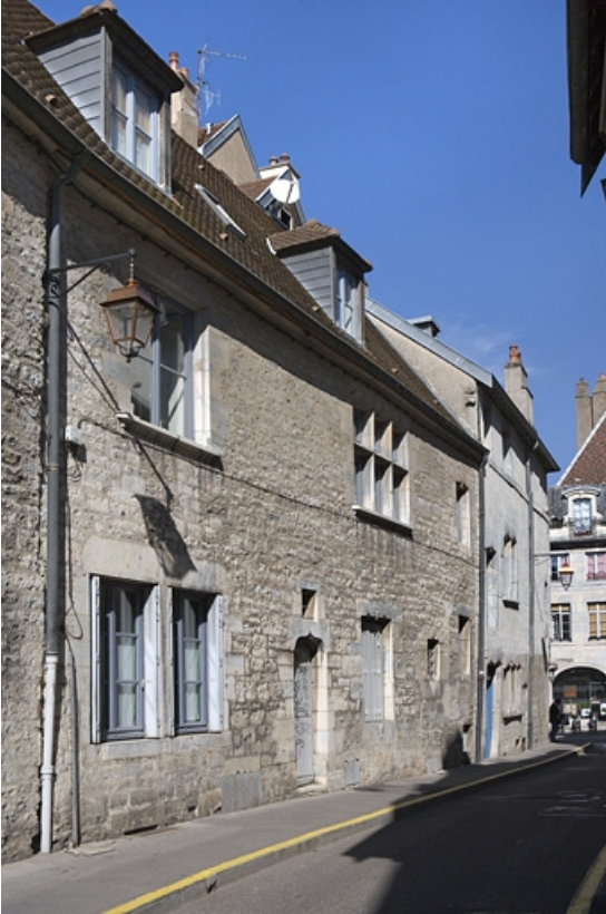
Façade latérale gauche, vue partielle.
