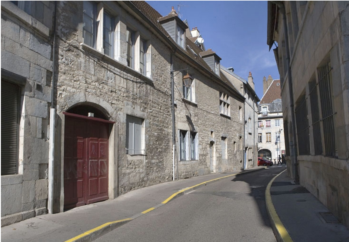
Façade latérale gauche, vue d'ensemble.
