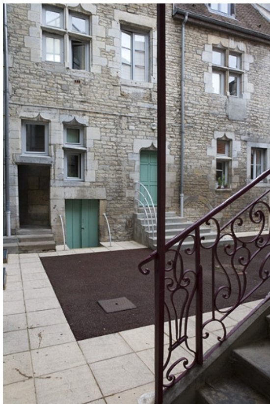
Vue de l'aile gauche depuis l'escalier à cage ouverte.
