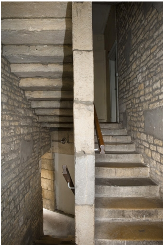
Détail de l'escalier rampe sur rampe dans oeuvre de l'aile gauche.
