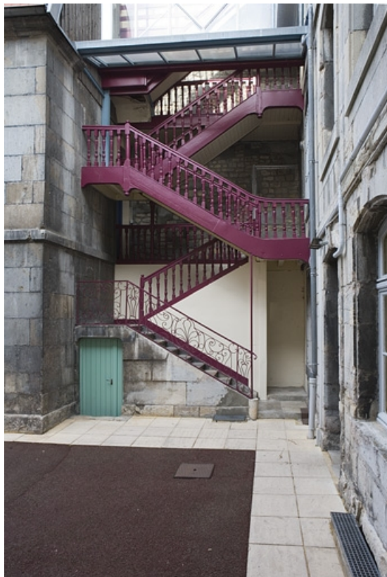
Vue d'ensemble de l'escalier à cage ouverte en dessous de la verrière.
