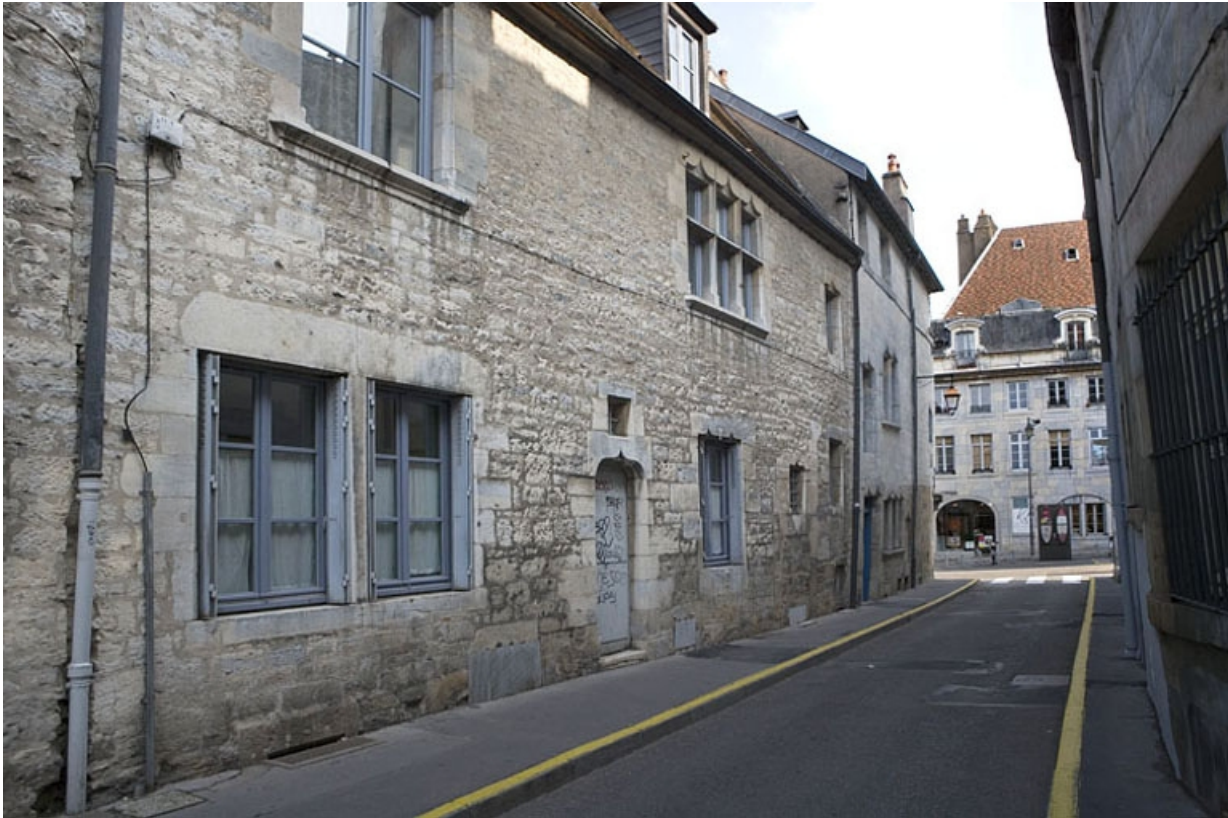
Vue d'ensemble de la façade latérale gauche, de trois quarts gauche.
