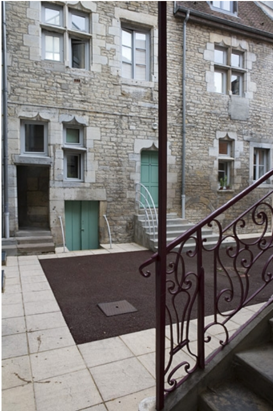
Vue de l'aile gauche depuis l'escalier à cage ouverte. 25, Besançon Grande Rue 140, lieudit : îlot Ronchaux
