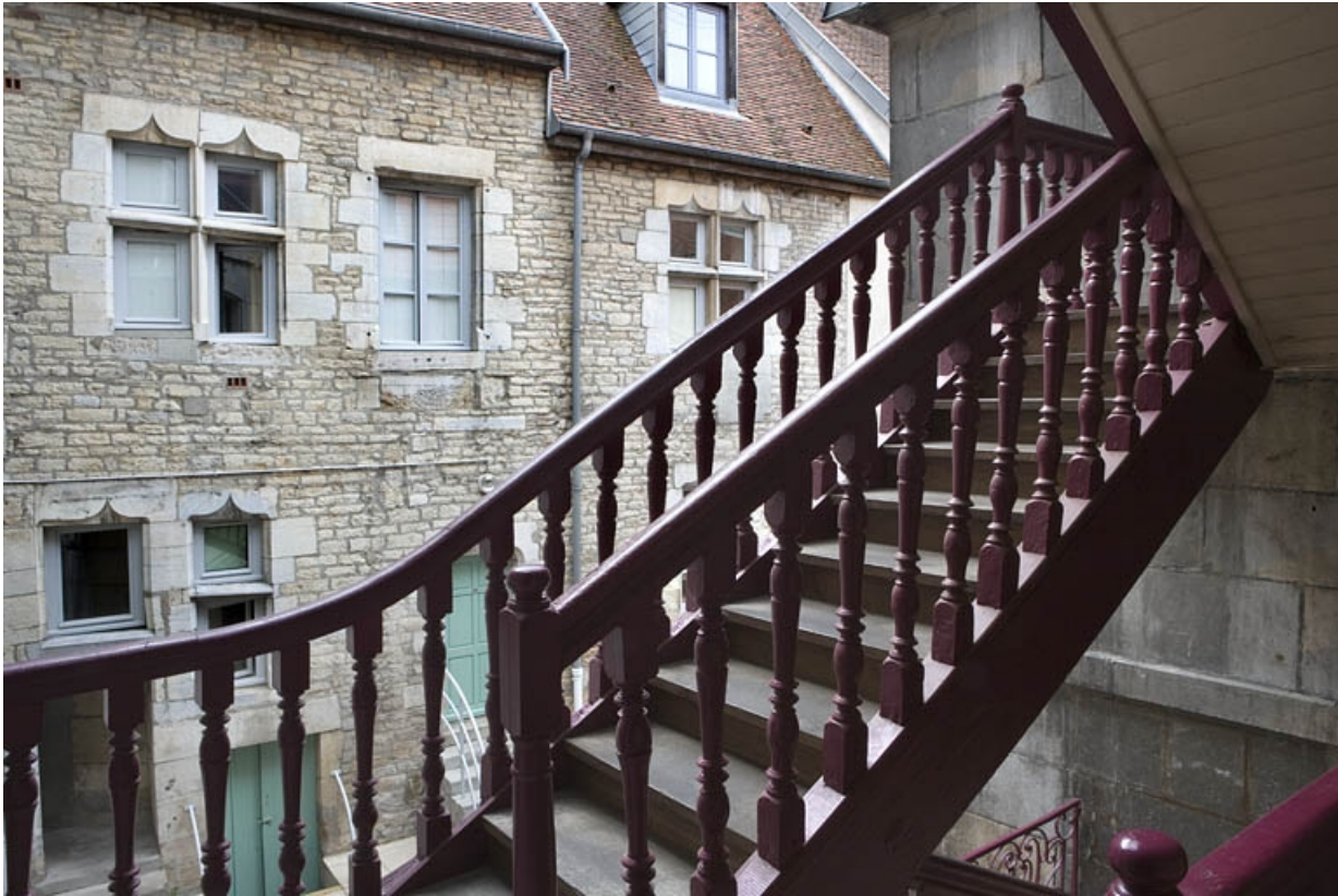
Escalier à cage ouverte sur cour, détail d'une volée.
