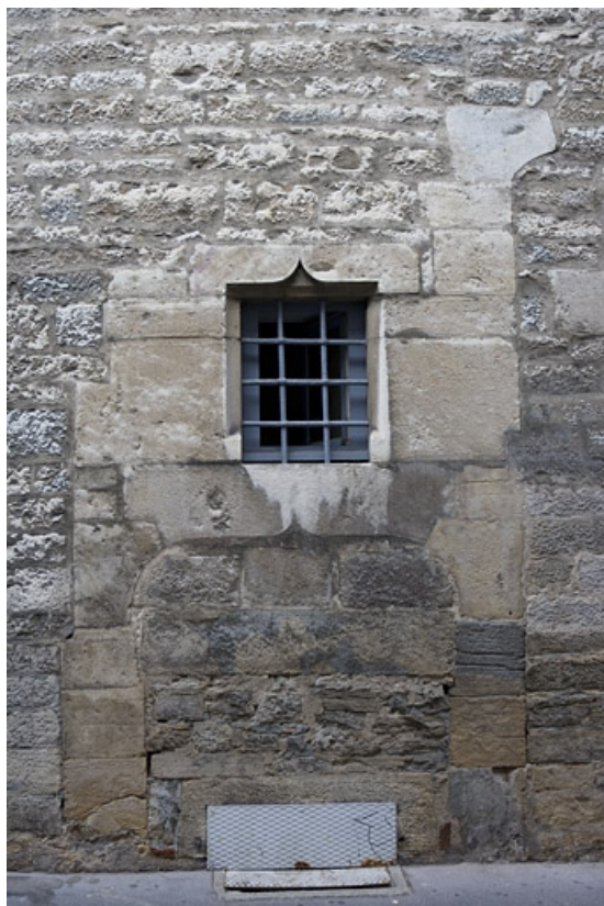
Façade latérale gauche : détail d'une fenêtre en accolade.
