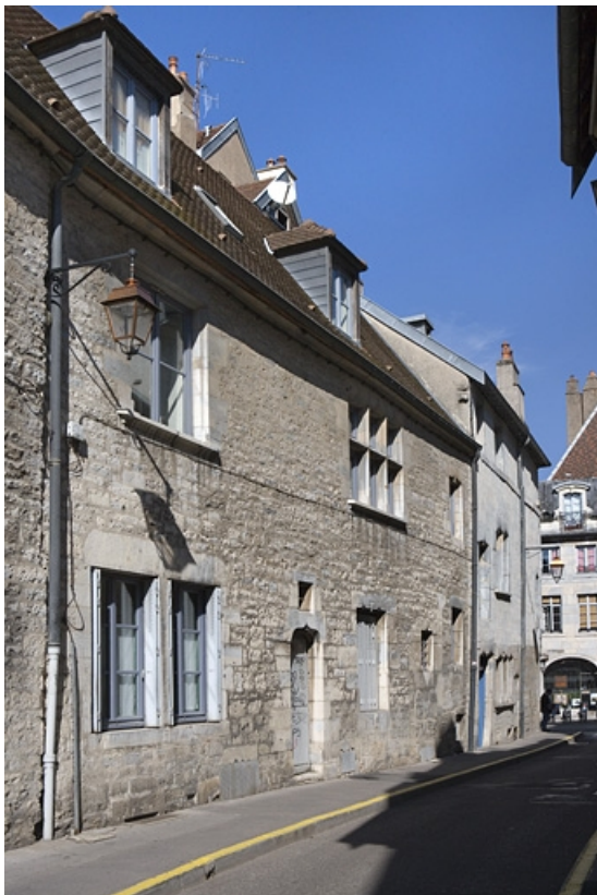
Façade latérale gauche, vue partielle.
