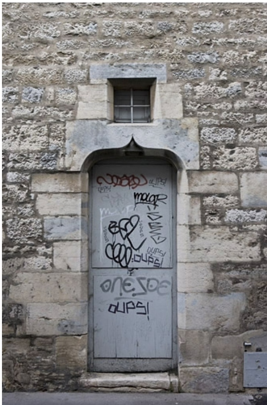
Façade latérale gauche : détail d'une porte en accolade.
