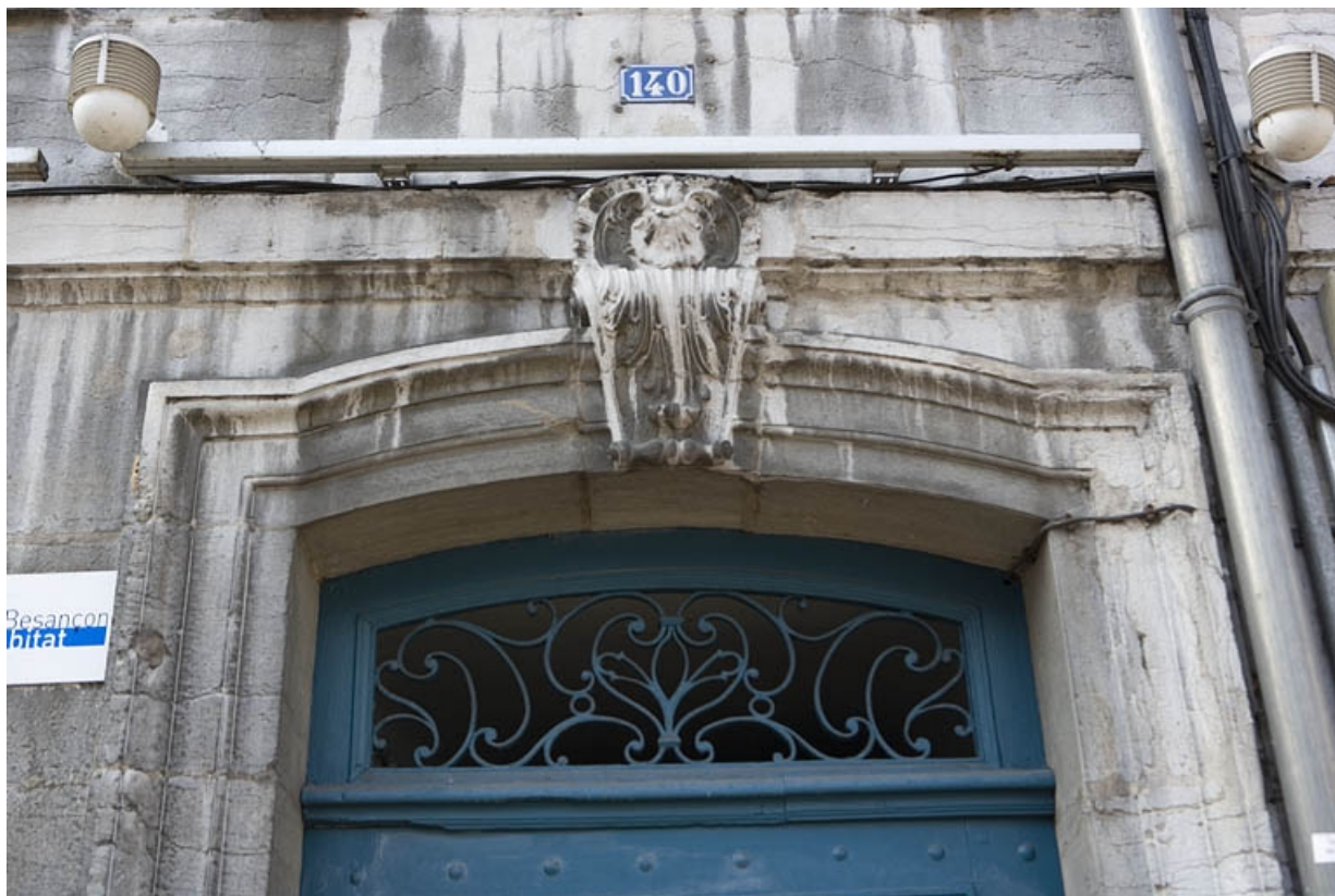
Façade sur rue : détail de la partie supérieure de la porte d'entrée.
