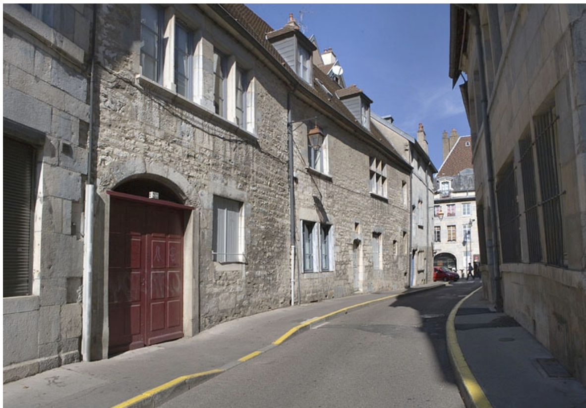
Façade latérale gauche, vue d'ensemble.
