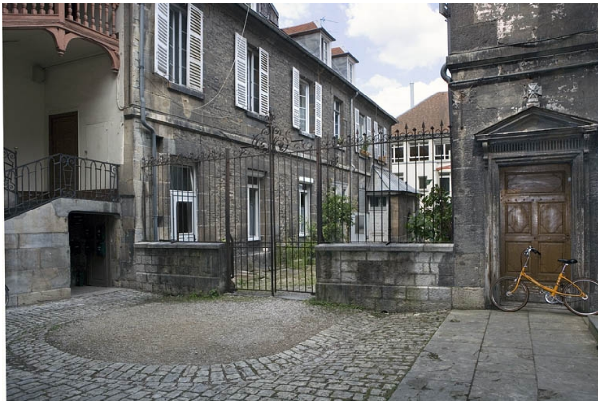
Vue de l'aile gauche dans la deuxième cour depuis la première cour.
