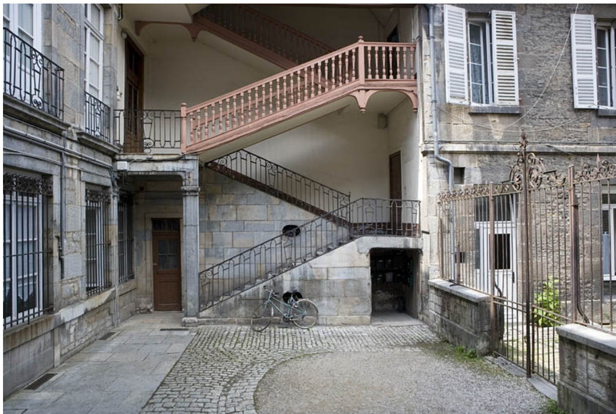
Vue de l'escalier à cage ouverte à gauche de la cour : de face.
