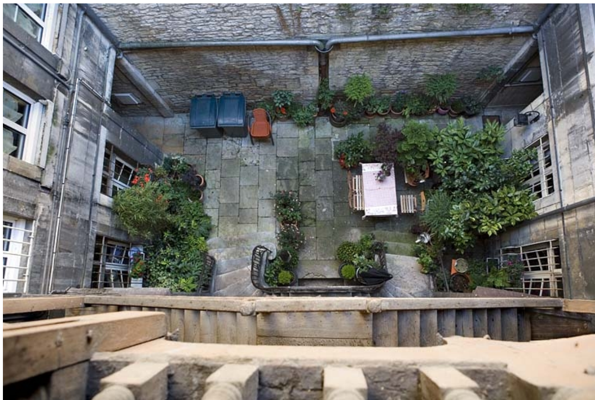
Vue d'ensemble de la cour depuis la partie supérieure de l'escalier à cage ouverte.
