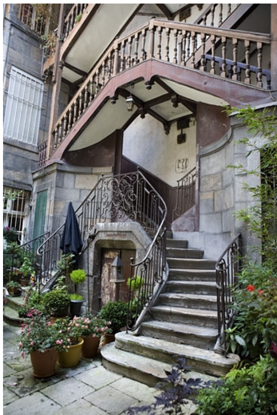
Vue de l'escalier à cage ouverte, de trois quart droit.
