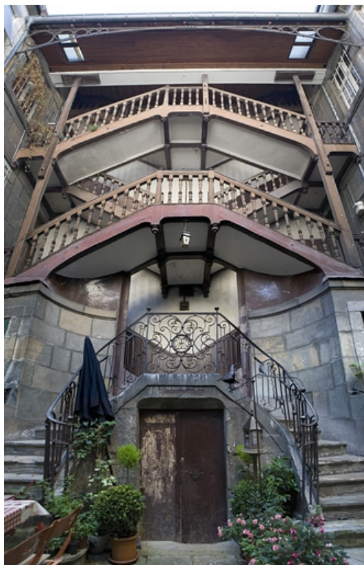
Vue d'ensemble de l'escalier à cage ouverte sur cour, de face.
