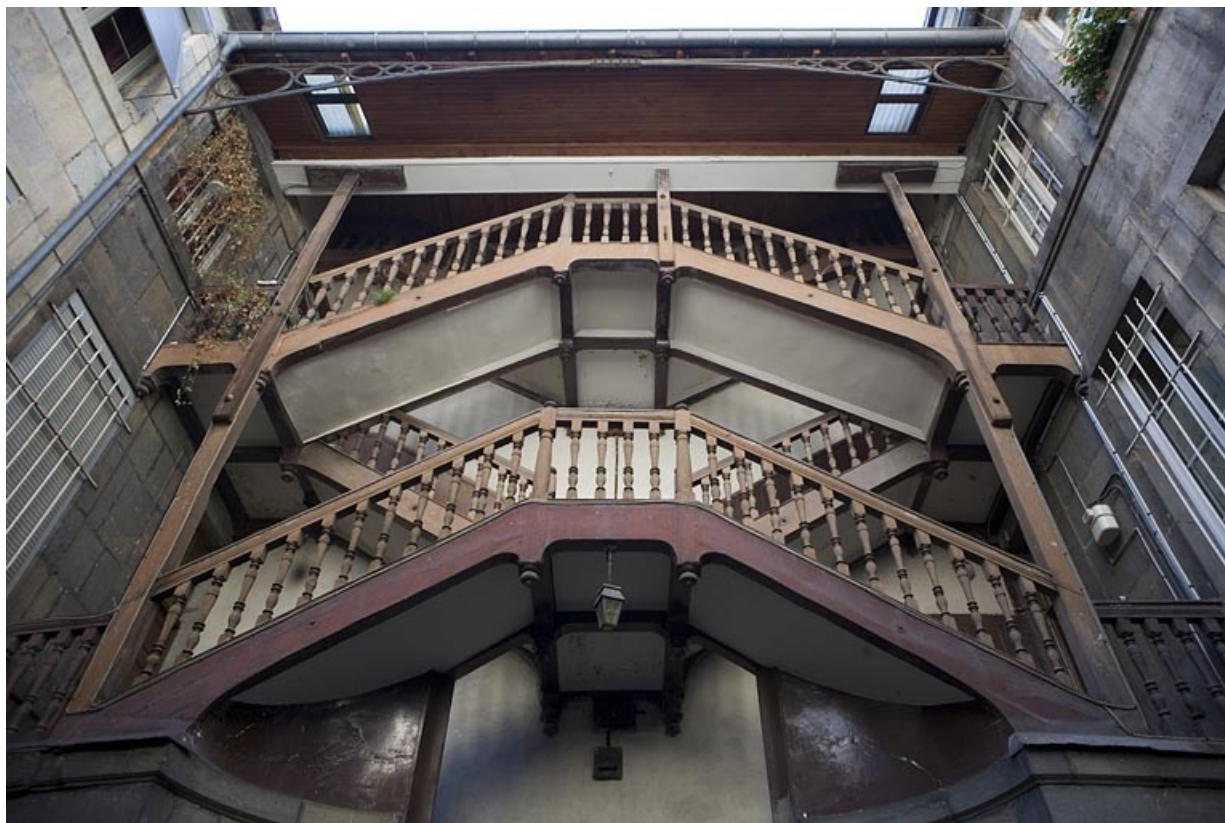
Détail de la partie supérieure de l'escalier à cage ouverte.
