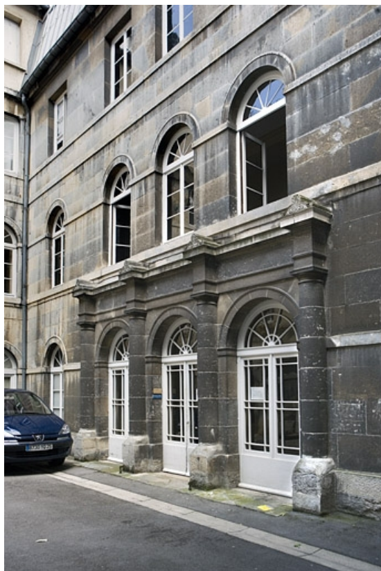
Aile droite sur cour : vue de l'entrée de l'escalier principal de trois quarts droit. 25, Besançon, 27 rue Mégevand, lieudit : îlot Terrier de Santans
