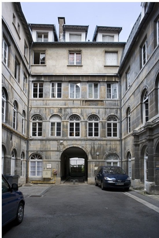
Vue d'ensemble de l'édifice depuis l'entrée de la cour.
