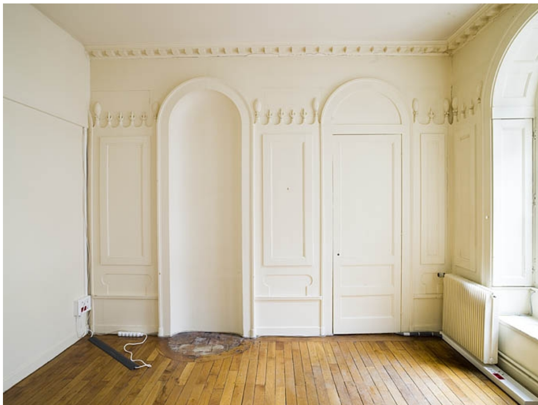
Logis principal, intérieur, salle à manger : détail du mur avec la niche du poêle.
