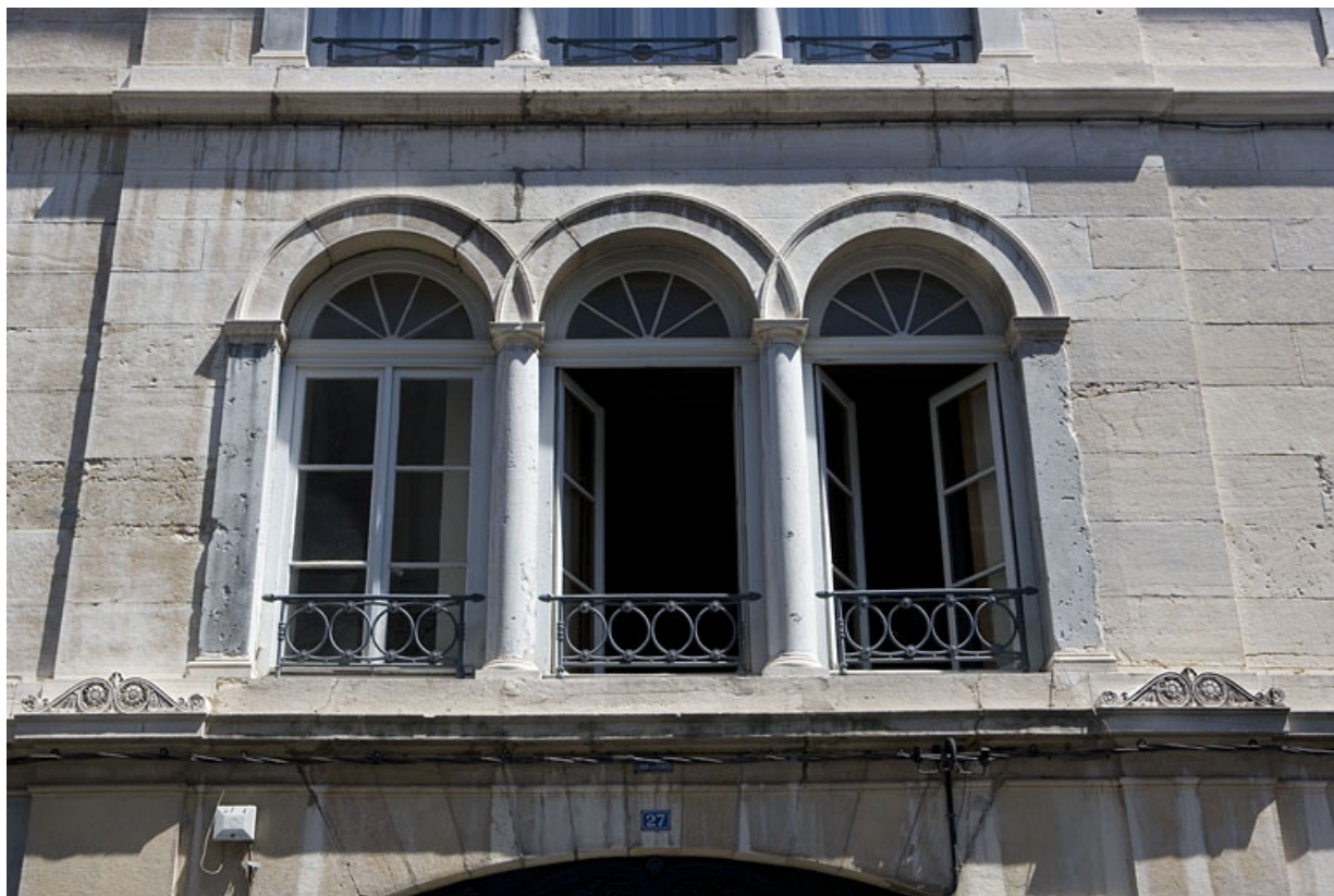
Façade sur rue : détail des fenêtres en triplet situées au-dessus du portail d'entrée.
