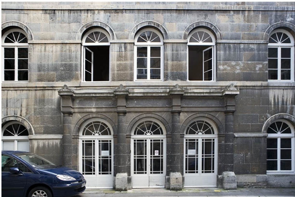
Aile droite sur cour : vue de l'entrée de l'escalier principal et du premier étage. 25, Besançon, 27 rue Mégevand, lieudit : îlot Terrier de Santans
