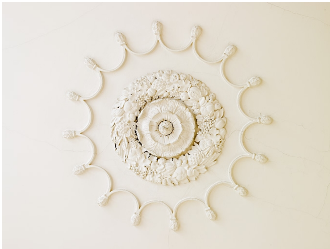
Logis principal, intérieur, salle à manger : détail du décor au centre du plafond. 25, Besançon, 27 rue Mégevand, lieudit : îlot Terrier de Santans
