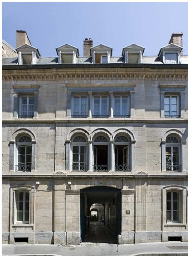
Vue de la façade sur rue, de face.
