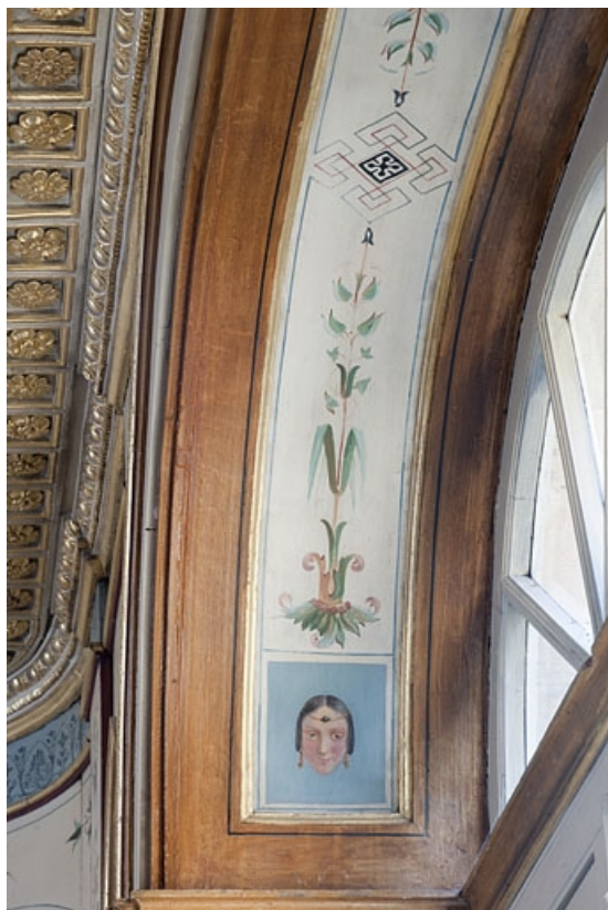
Logis principal, intérieur, salon : détail des motifs peints dans l'encadrement d'une fenêtre, partie gauche. 25, Besançon, 27 rue Mégevand, lieudit : îlot Terrier de Santans
