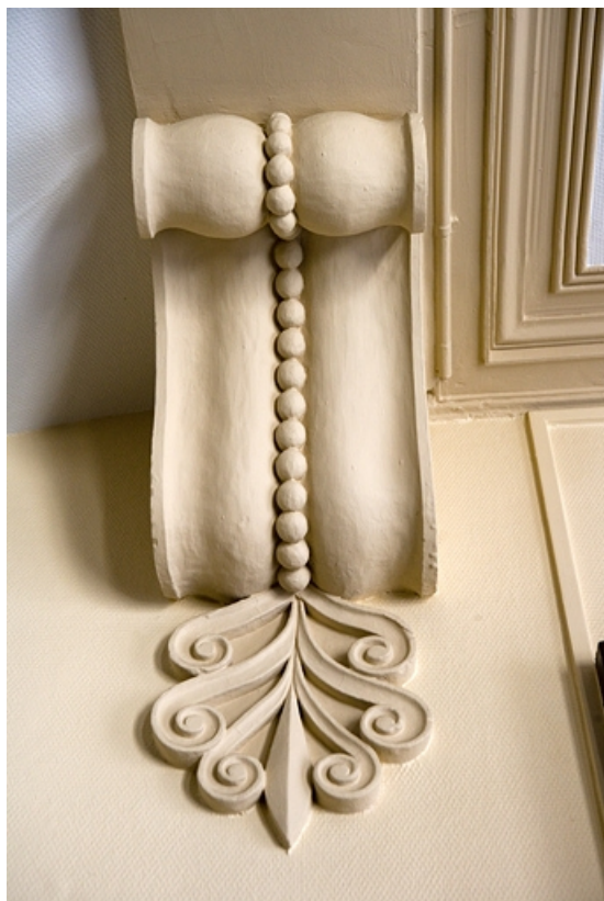
Détail d'une console soutenant le plafond de la cage d'escalier.
