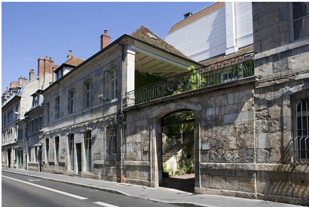
Vue d'ensemble de l'édifice depuis la rue, de trois quarts droit : vue rapprochée.
