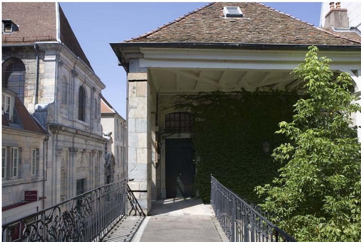
Vue du passage au-dessus du portail dans clôture depuis le bâtiment droit.
