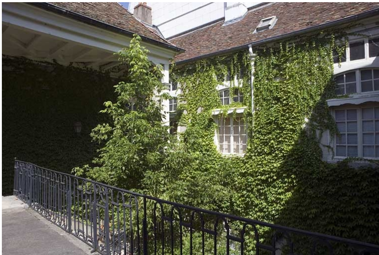
Détail de l'aile en fond de cour depuis le passage au-dessus du portail dans clôture.
