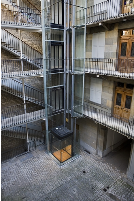
Vue de l'ascenseur situé à un angle de la cour.
