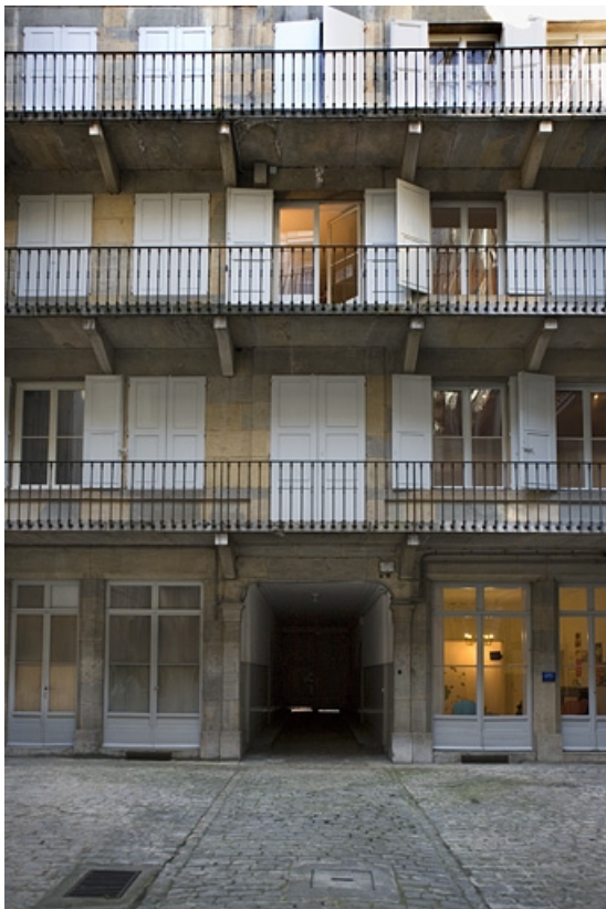
Vue de la façade postérieure du logis sur rue.
