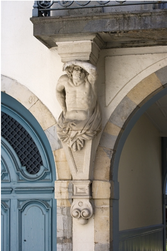
Détail de l'atlante gauche supportant le balcon du logis en fond de cour, de face. 25, Besançon, 17 rue Mégevand, lieudit : îlot Terrier de Santans
