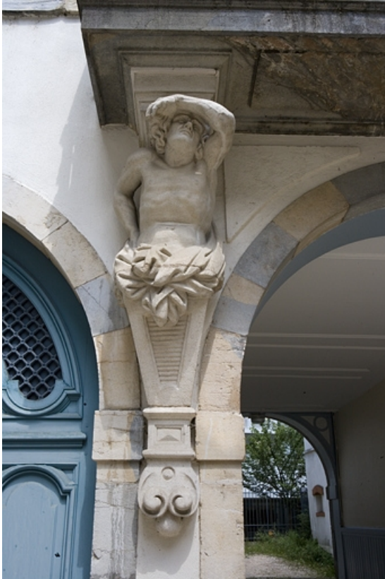
Détail de l'atlante gauche supportant le balcon du logis en fond de cour.
