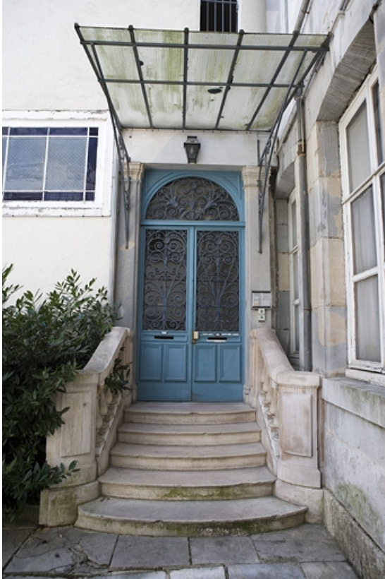
Détail de la porte d'entrée de l'escalier situé dans l'aile droite sur cour. 25, Besançon, 17 rue Mégevand, lieudit : îlot Terrier de Santans
