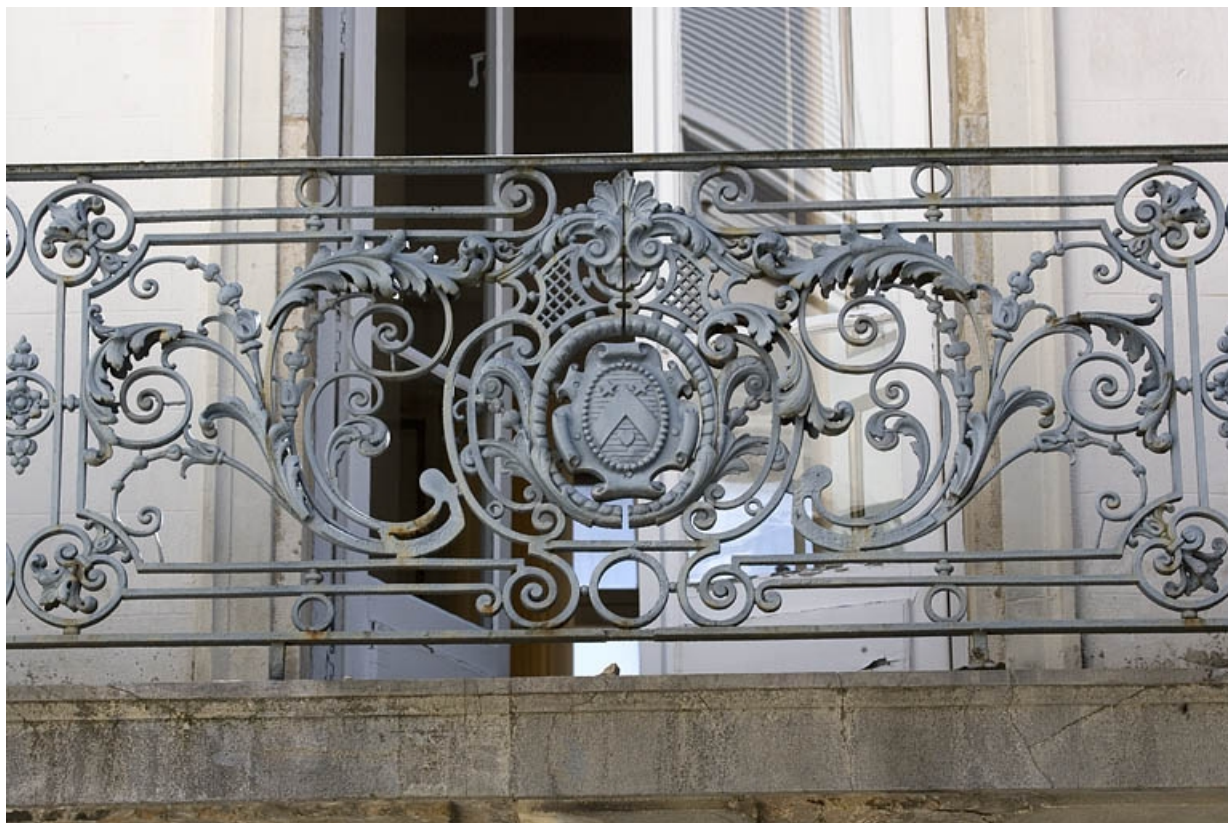
Détail des armoiries des Courlet de Boulot sur le balcon du logis en fond de cour.
