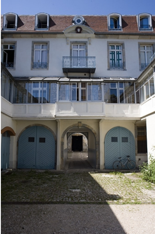
Vue de la partie centrale de la façade postérieure du logis secondaire, de face. 25, Besançon, 17 rue Mégevand, lieudit : îlot Terrier de Santans
