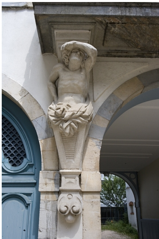
Détail de l'atlante gauche supportant le balcon du logis en fond de cour.
