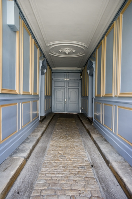
Logis principal : vue rapprochée du passage cocher depuis la cour. 25, Besançon, 17 rue Mégevand, lieudit : îlot Terrier de Santans
