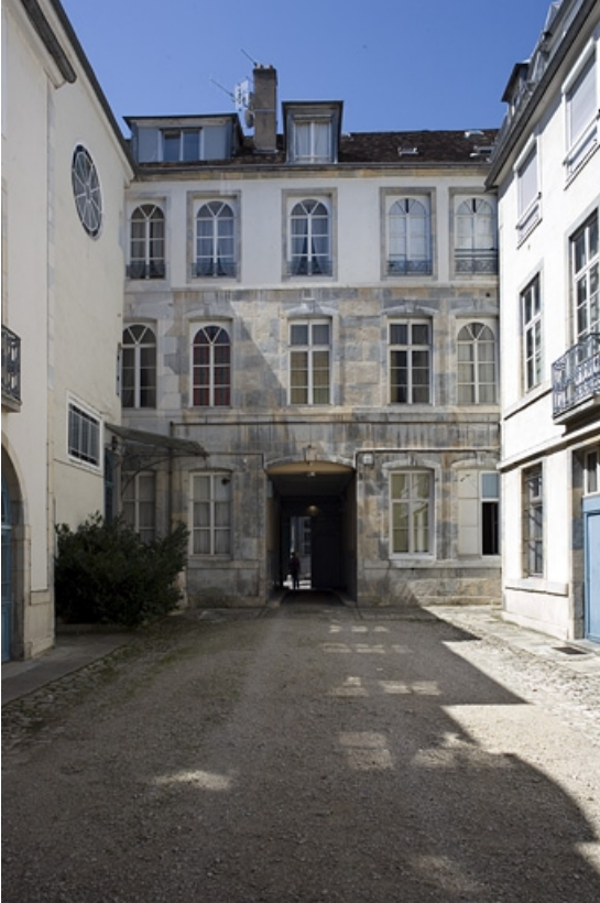
Vue d'ensemble des bâtiments autour de la première cour. 25, Besançon, 17 rue Mégevand, lieudit : îlot Terrier de Santans
