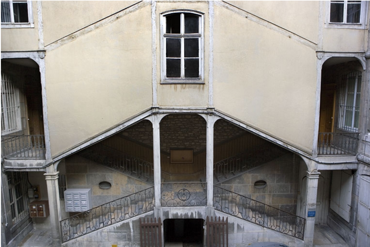
Vue d'ensemble de l'escalier à cage ouverte droit, de face, depuis l'escalier gauche. 25, Besançon, 64 Grande Rue, lieudit : îlot Terrier de Santans
