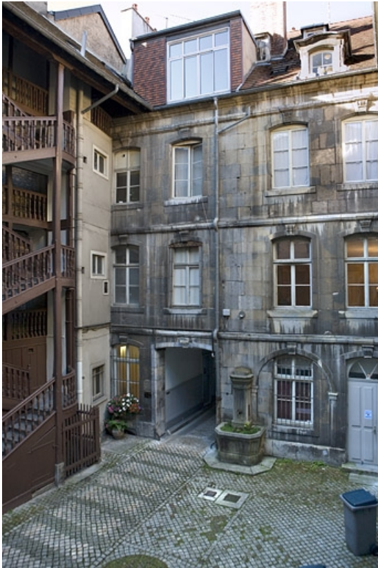
Vue du logis secondaire au fond de la première cour depuis l'escalier droit. 25, Besançon, 64 Grande Rue, lieudit : îlot Terrier de Santans
