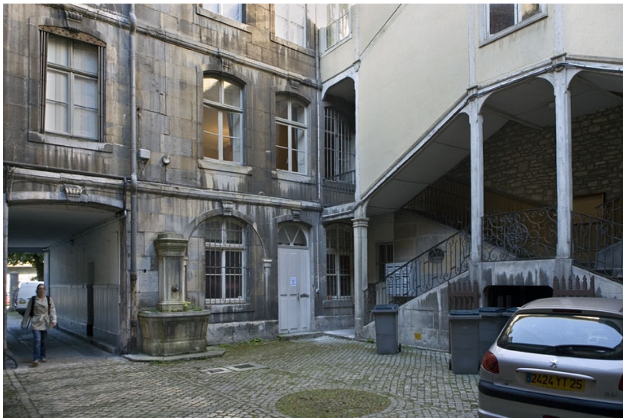
Vue de l'escalier à cage ouverte droit et du logis secondaire, de trois quarts gauche, depuis l'entrée de la première cour. 25, Besançon, 64 Grande Rue, lieudit : îlot Terrier de Santans
