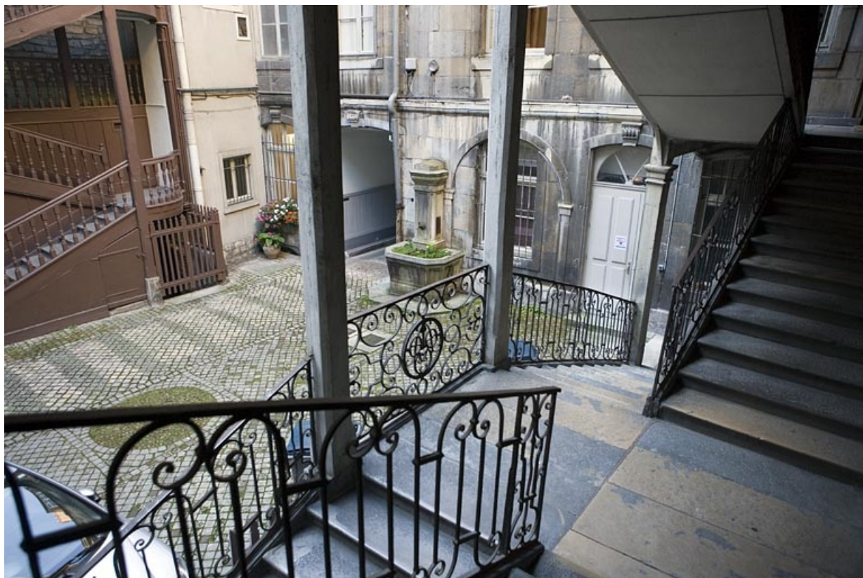
Vue de la rampe en ferronnerie de l'escalier à cage ouverte droit depuis le premier palier.
