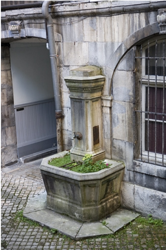
Détail de la borne fontaine située dans la première cour. 25, Besançon, 64 Grande Rue, lieudit : îlot Terrier de Santans
