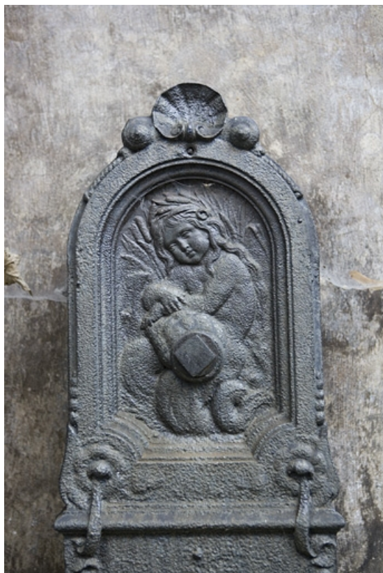
Détail de la partie supérieure de la borne fontaine située dans la deuxième cour. 25, Besançon, 64 Grande Rue, lieudit : îlot Terrier de Santans
