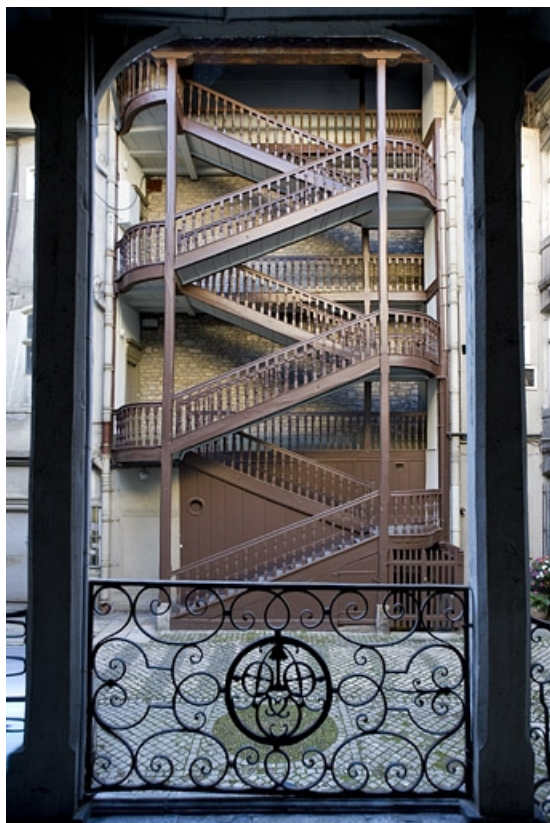
Vue de l'escalier à cage ouverte gauche, de face, depuis l'escalier droit. 25, Besançon, 64 Grande Rue, lieudit : îlot Terrier de Santans
