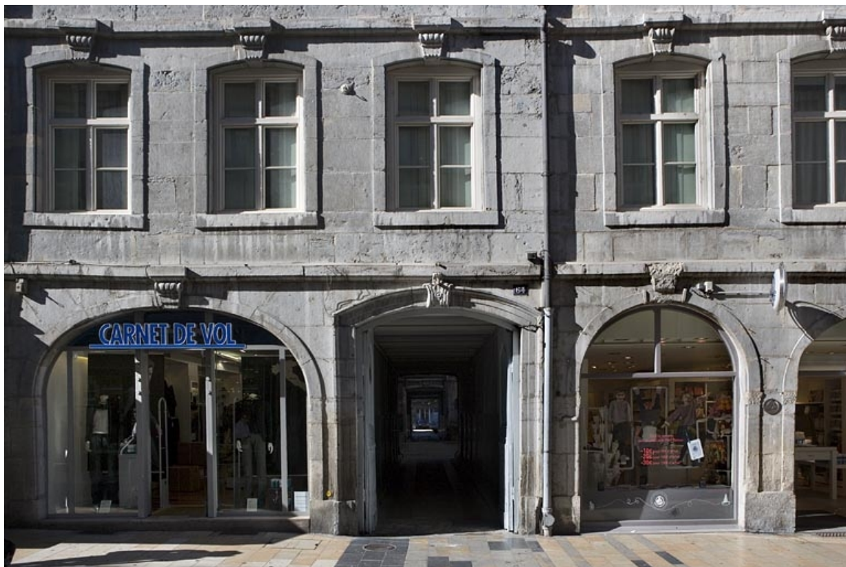
Façade sur rue du logis principal : détail du portail d'entrée, de face. 25, Besançon, 64 Grande Rue, lieudit : îlot Terrier de Santans
