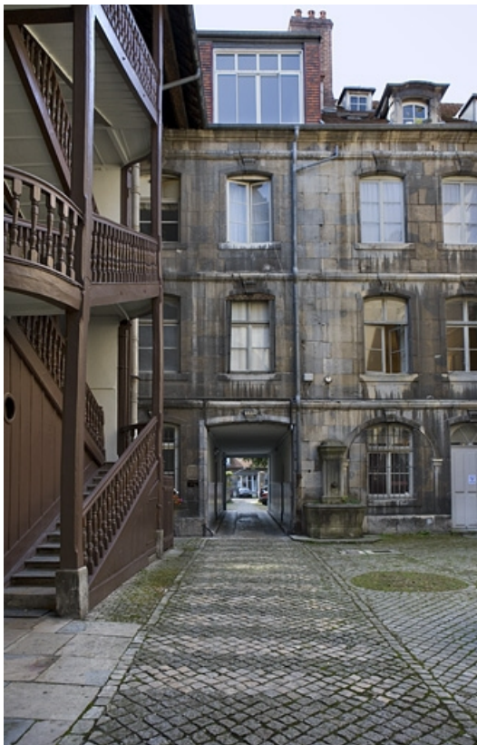
Vue d'ensemble de l'escalier gauche et du logis secondaire depuis l'entrée de la première cour.
