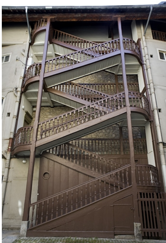
Vue de l'escalier à cage ouverte gauche, de face, depuis la cour.
