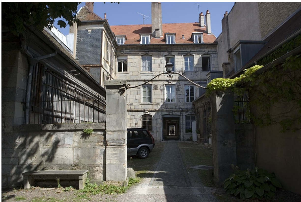
Vue de la façade postérieure du logis secondaire depuis l'entrée de la troisième cour.
