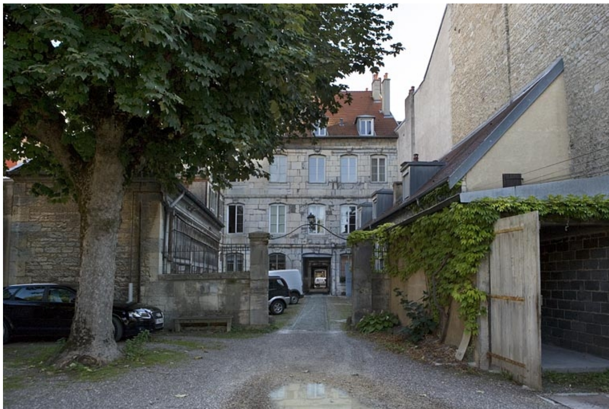
Vue d'ensemble des bâtiments depuis le fond de la parcelle.
