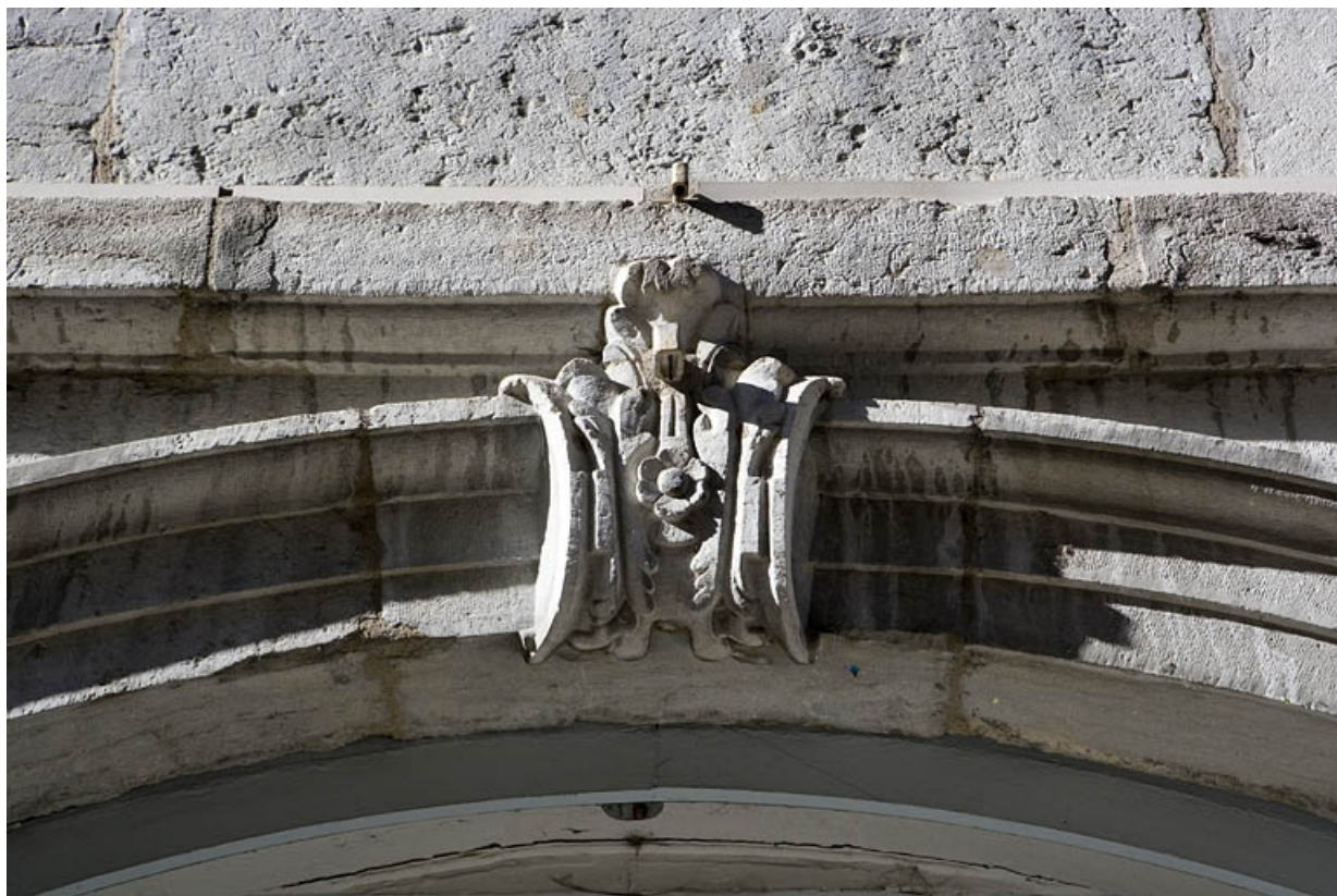
Portail d'entrée : détail de la clé de l'arc.
