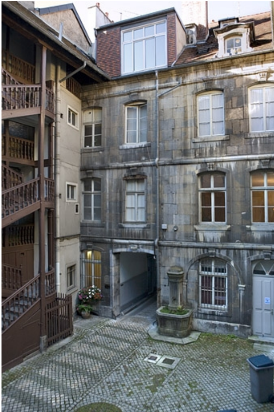
Vue du logis secondaire au fond de la première cour depuis l'escalier droit. 25, Besançon, 64 Grande Rue, lieudit : îlot Terrier de Santans
