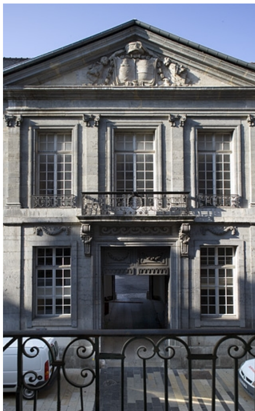
Vue d'ensemble de la partie centrale de la façade sur rue, de face. 25, Besançon Grande Rue 68, lieudit : îlot Terrier de Santans
