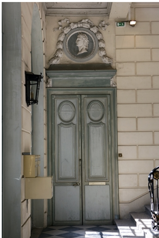
Escalier d'honneur : vue de la porte gauche située au rez-de-chaussée. 25, Besançon Grande Rue 68, lieudit : îlot Terrier de Santans
