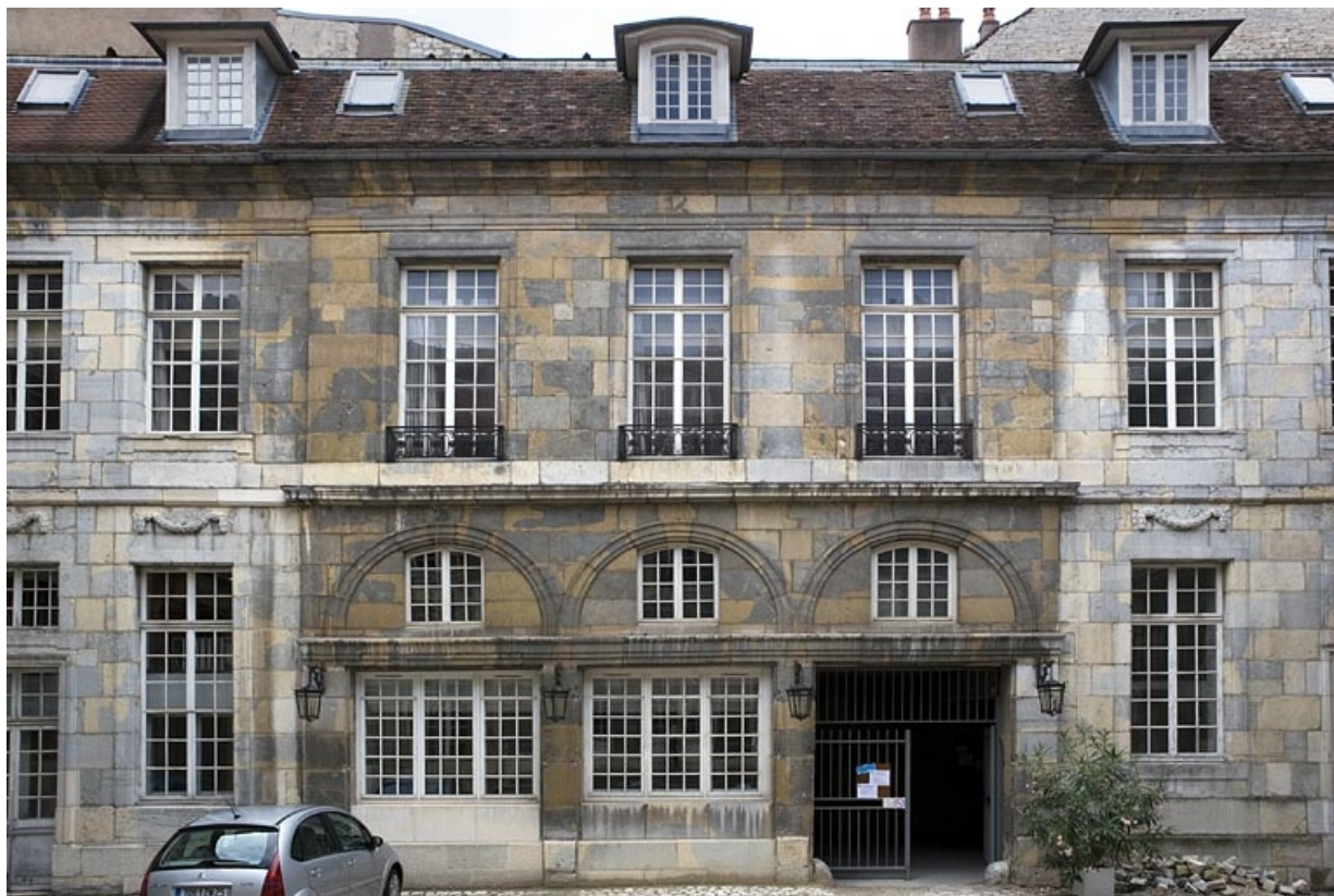
Aile à gauche de la cour d'honneur contenant le passage donnant sur la cour des communs. 25, Besançon Grande Rue 68, lieudit : îlot Terrier de Santans
