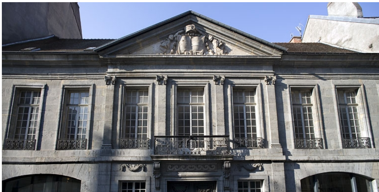
Vue d'ensemble du premier étage de la façade sur rue, de face.
