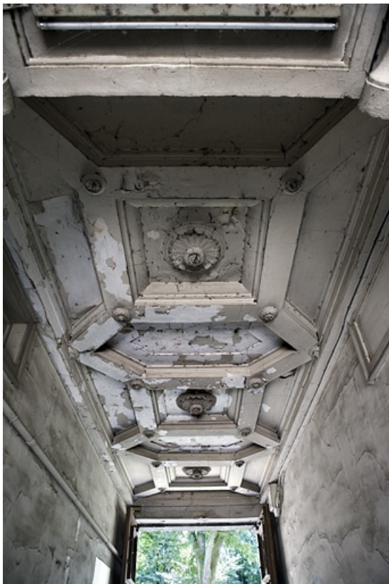
Détail du plafond du passage cocher depuis l'entrée.
