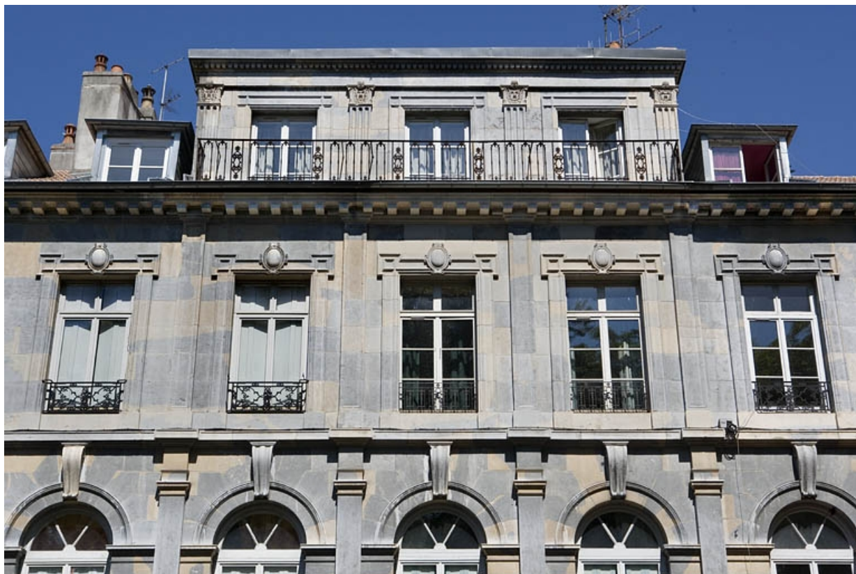
Vue d'ensemble de la partie haute de la façade sur rue.
