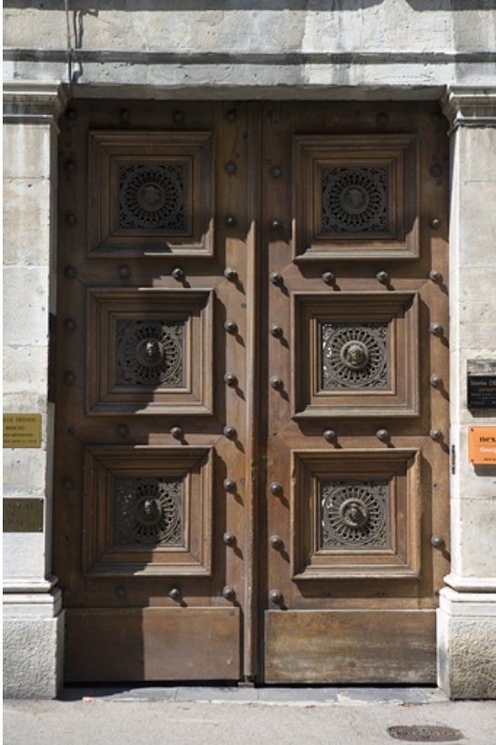
Façade sur rue : détail des vantaux en menuiserie du portail d'entrée. 25, Besançon, 10 rue de la Préfecture, lieudit : îlot Terrier de Santans
