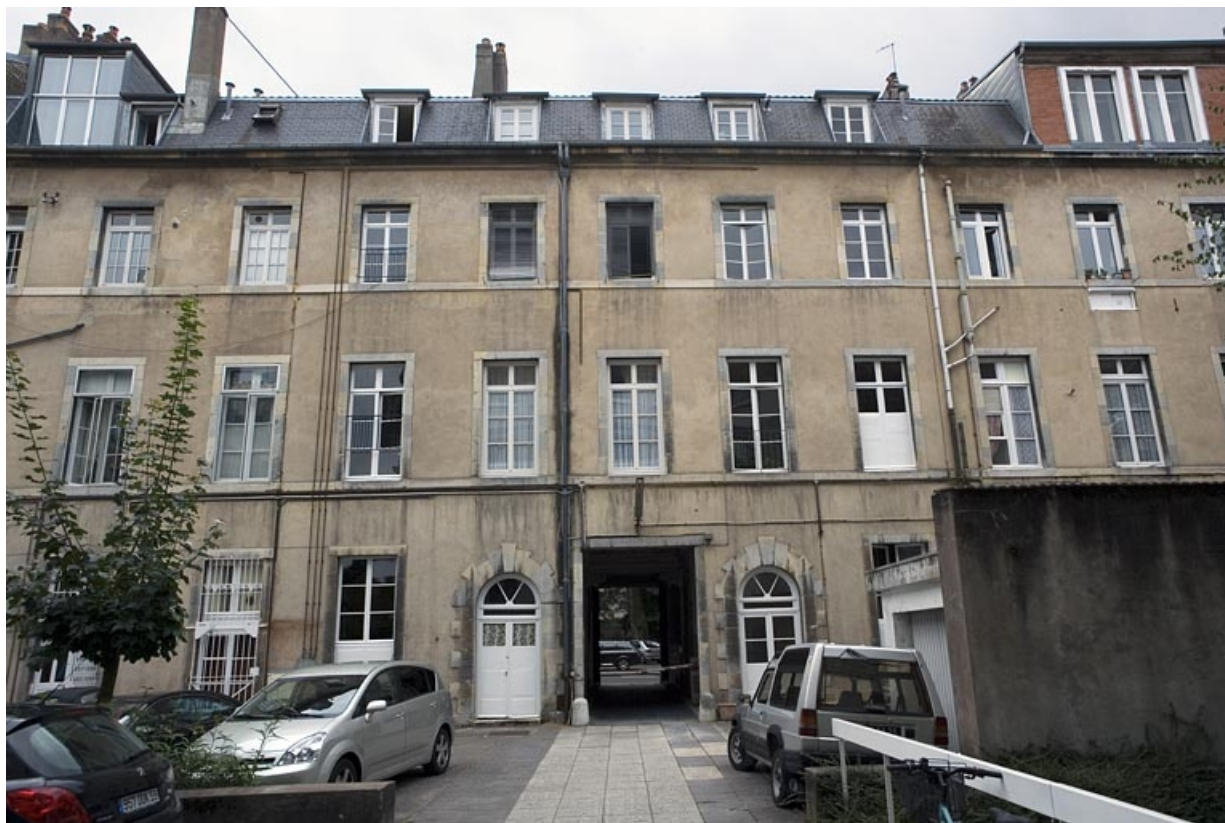
Vue d'ensemble de la façade postérieure du logis principal.
