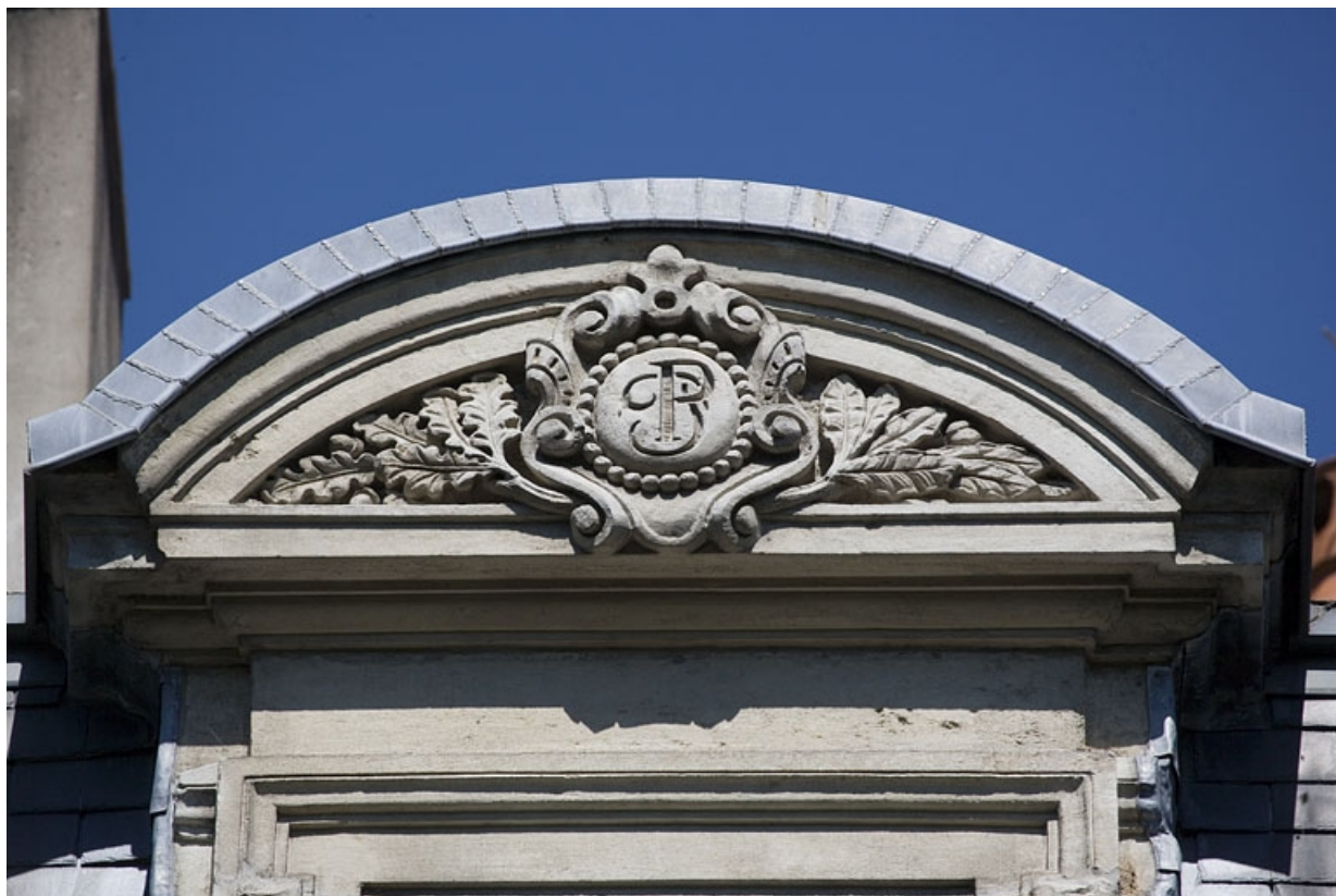
Détail du monogramme sur l'un des frontons cintrés de l'étage de comble.
