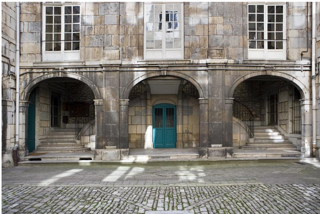
Première cour : détail du rez-de-chaussée de l'aile gauche, de face. 25, Besançon Grande Rue 74, lieudit : îlot Terrier de Santans
