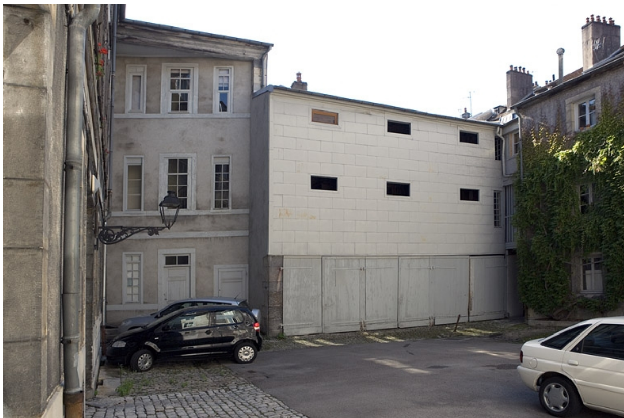
Deuxième cour : vue d'ensemble de l'aile gauche et du bâtiment des remises et des bûchers, de face. 25, Besançon Grande Rue 74, lieudit : îlot Terrier de Santans
