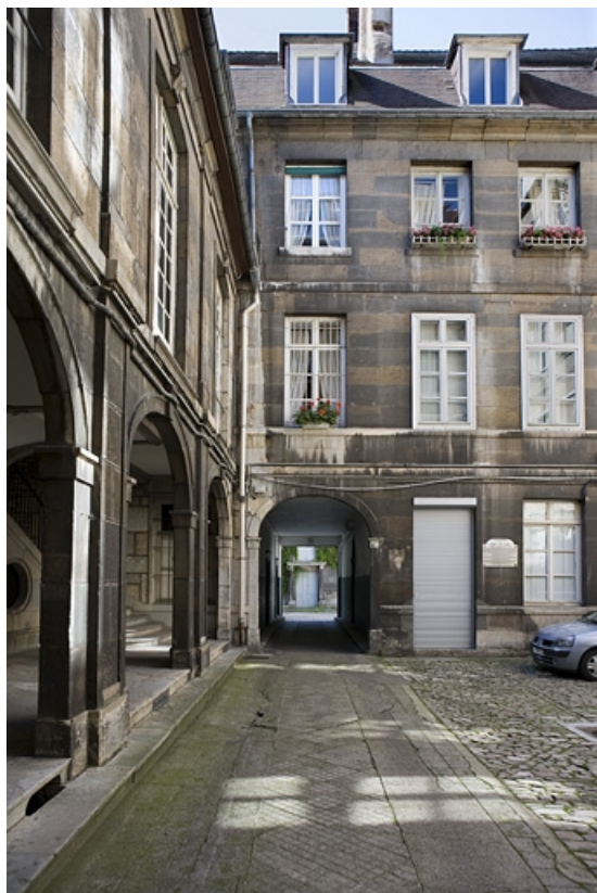
Détail de l'aile droite et de la façade antérieure du logis secondaire depuis l'entrée de la première cour. 25, Besançon Grande Rue 74, lieudit : îlot Terrier de Santans
