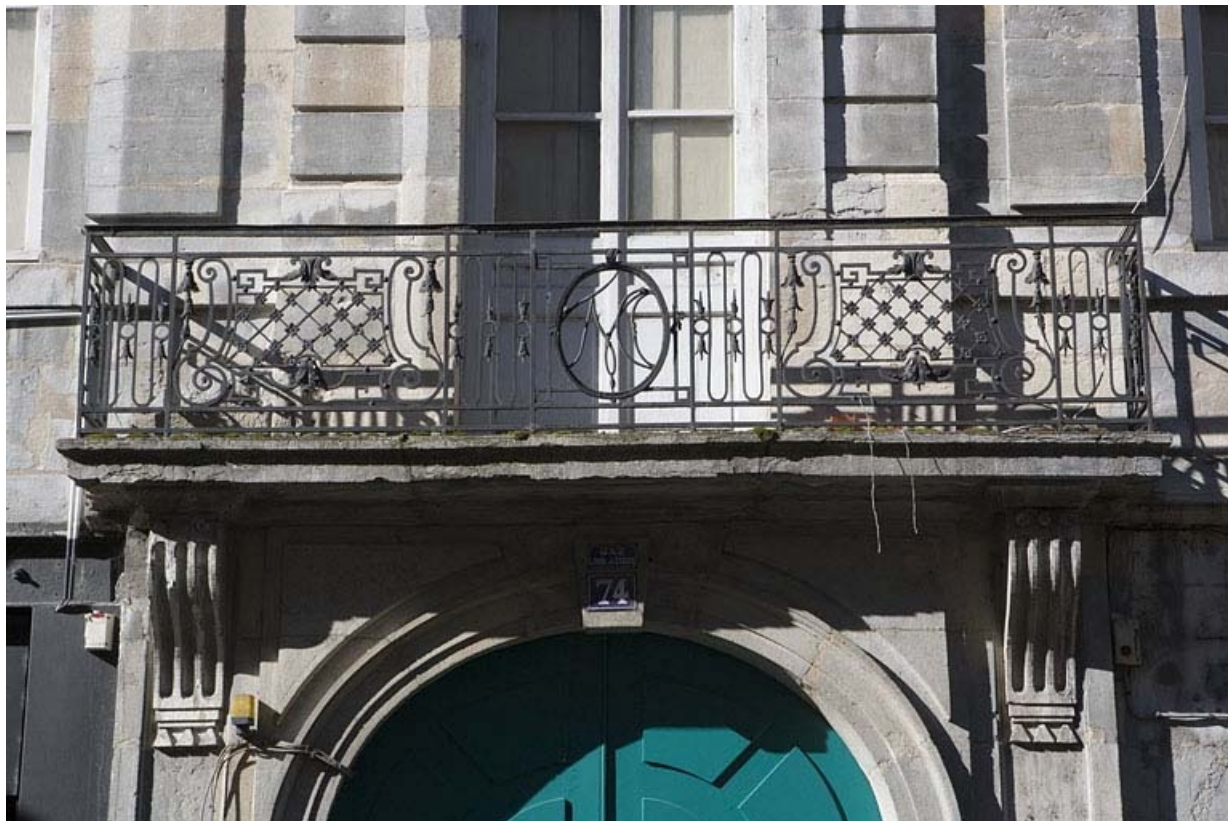
Détail du balcon situé au-dessus du portail d'entrée.
