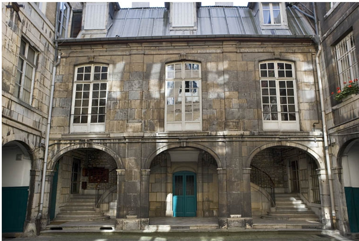
Première cour : vue d'ensemble de l'aile gauche, de face. 25, Besançon Grande Rue 74, lieudit : îlot Terrier de Santans
