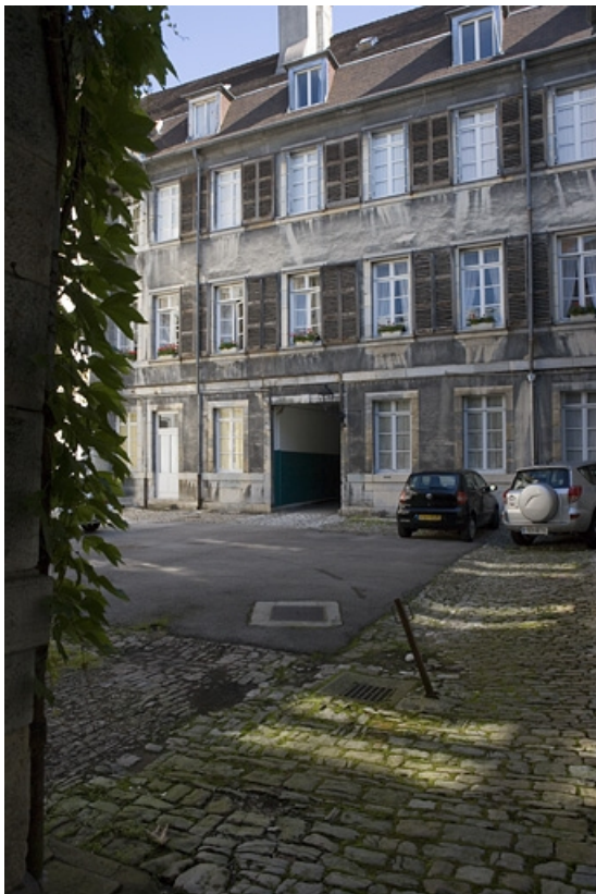
Deuxième cour : vue d'ensemble de l'aile droite, de trois quarts droit. 25, Besançon Grande Rue 74, lieudit : îlot Terrier de Santans
