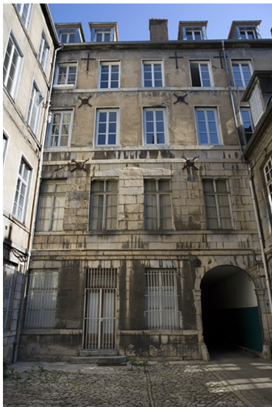
Vue d'ensemble de la façade postérieure du logis sur rue, de face. 25, Besançon Grande Rue 74, lieudit : îlot Terrier de Santans
