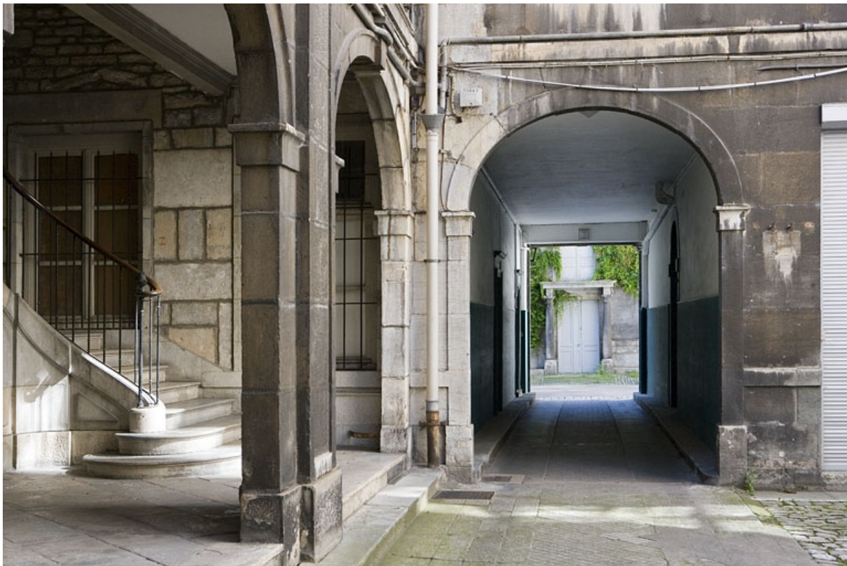
Détail de l'entrée du passage cocher au rez-de-chaussée du logis secondaire. 25, Besançon Grande Rue 74, lieudit : îlot Terrier de Santans
