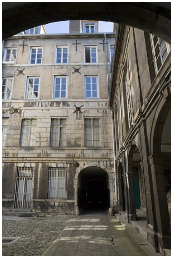
Vue d'ensemble de la façade postérieure du logis sur rue depuis le fond de la première cour. 25, Besançon Grande Rue 74, lieudit : îlot Terrier de Santans
