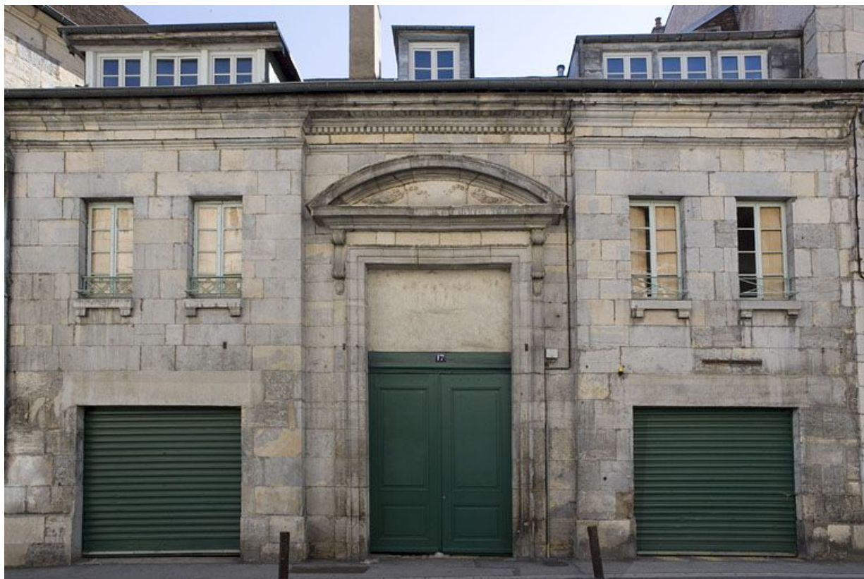
Vue d'ensemble du portail d'entrée des communs depuis la rue du Lycée.
