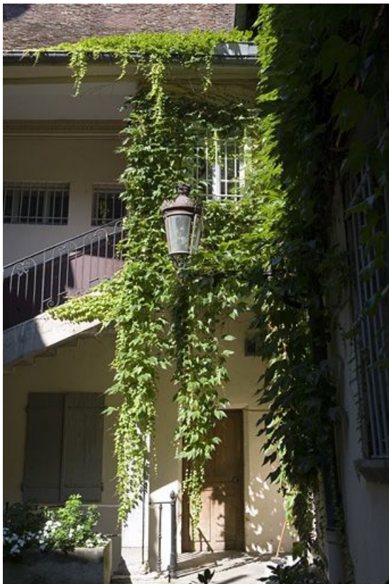
Vue de la partie droite de l'escalier à cage ouverte. 25, Besançon, 12 rue Pasteur, lieudit : îlot d' Anvers
