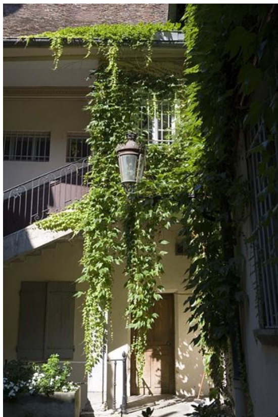
Vue de la partie droite de l'escalier à cage ouverte. 25, Besançon, 12 rue Pasteur, lieudit : îlot d' Anvers
