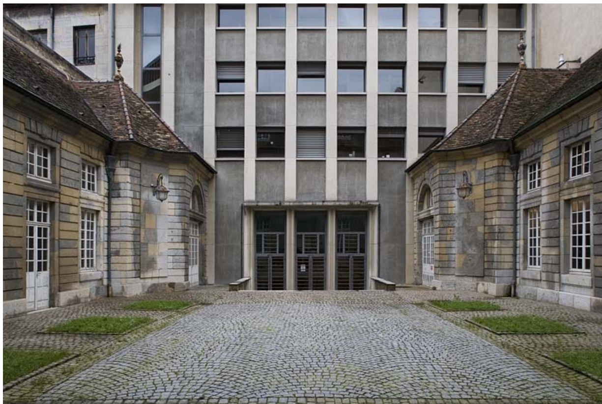
Vue d'ensemble de la cour avec l'immeuble de bureaux.
