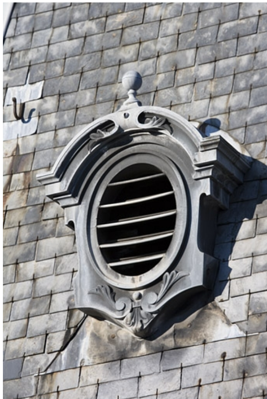
Détail d'une lucarne sur la toiture de la tourelle d'escalier.
