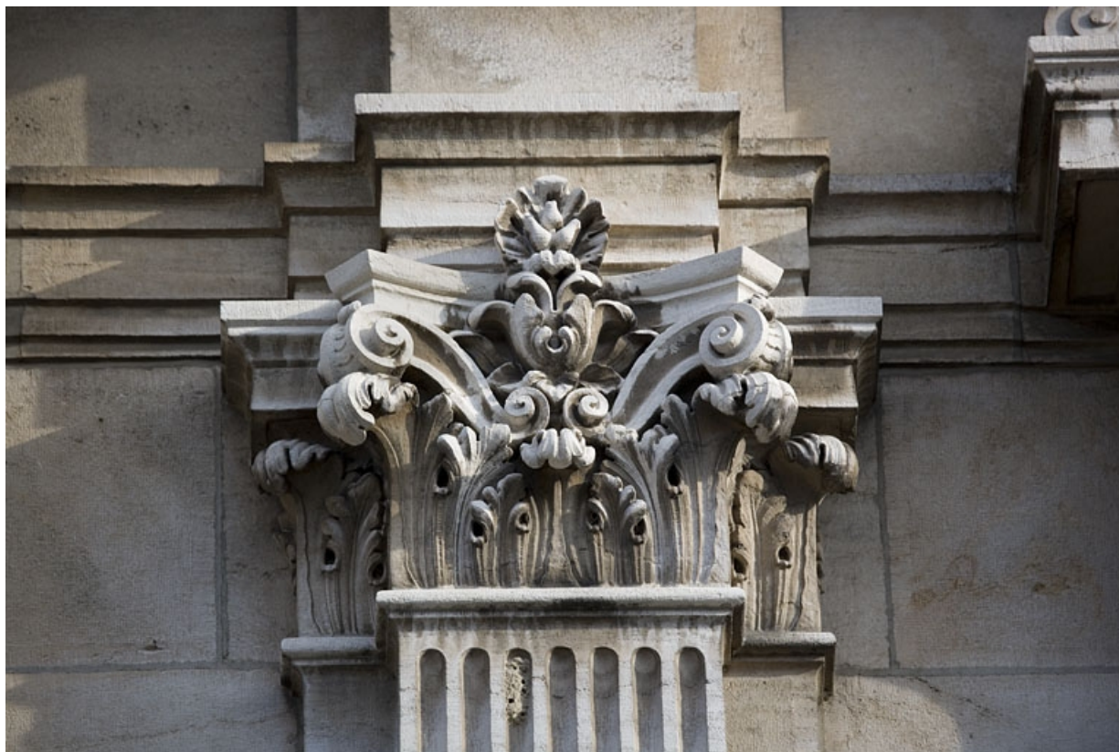
Détail d'un chapiteau sur la façade sur rue.
