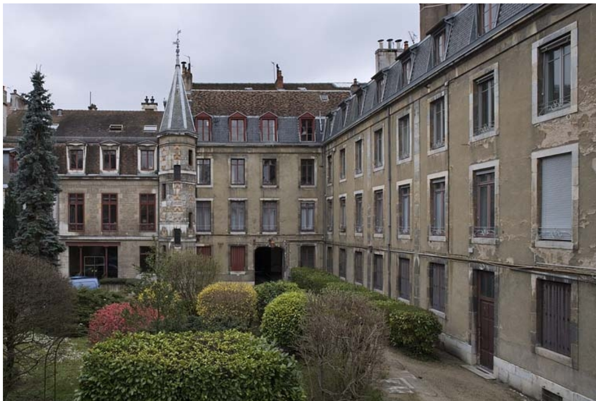
Vue d'ensemble des bâtiments depuis le fond de la cour, de trois quarts droit.
