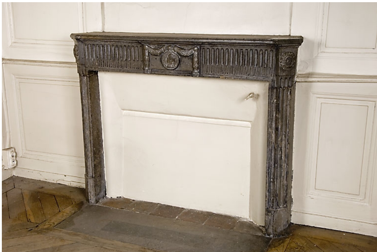
Détail d'une cheminée : pièce au rez-de-chaussée.
