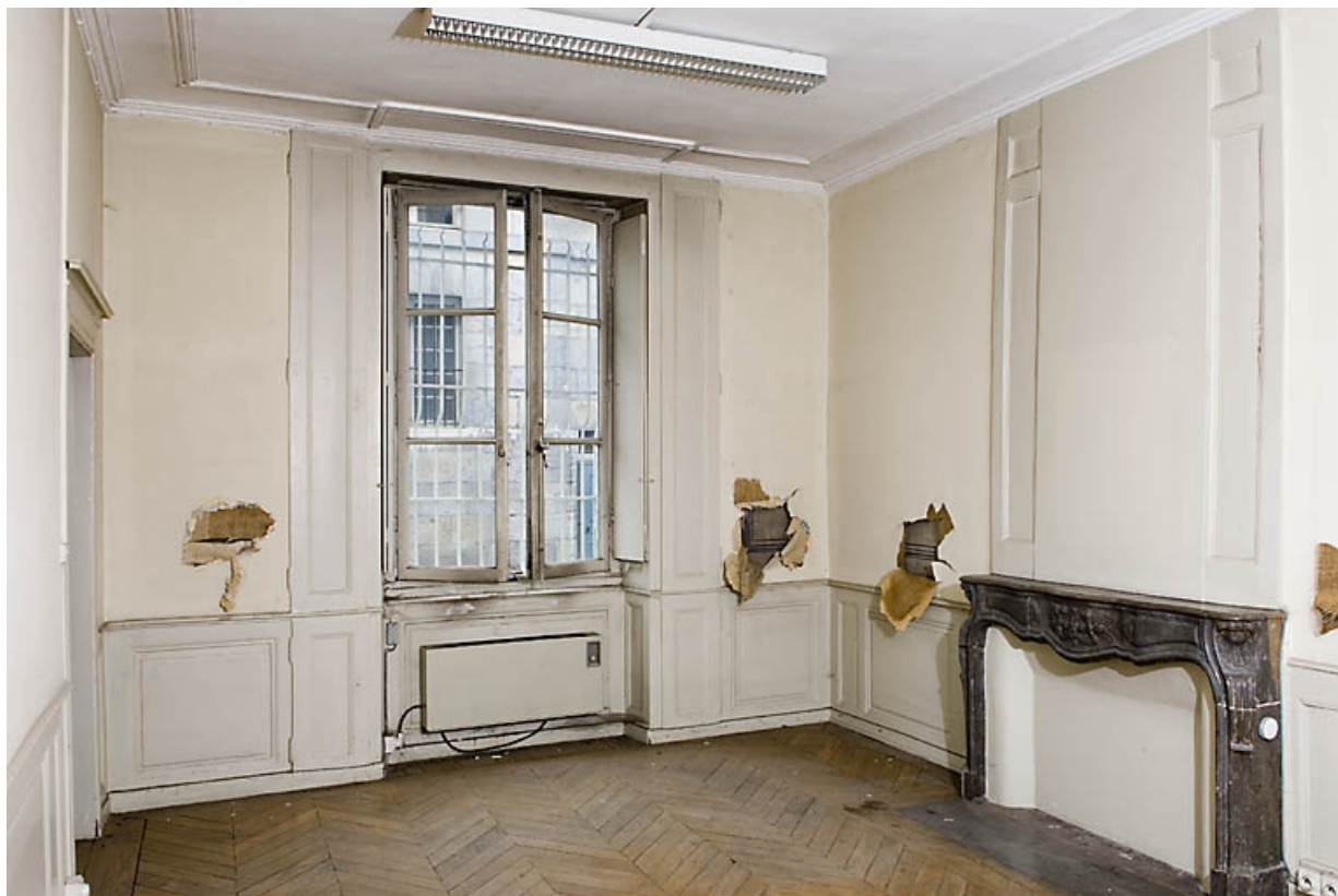
Vue d'ensemble d'une pièce en rez-de-chaussée à gauche de l'escalier principal. 25, Besançon, 9, 9 bis rue Charles Nodier, lieudit : îlot Banque de France
