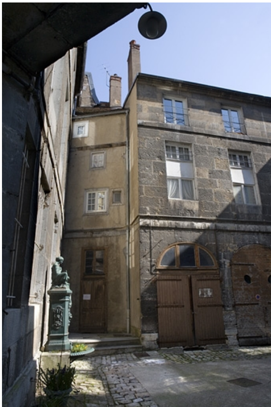
Vue de l'angle gauche de l'aile sur cour depuis l'entrée.
