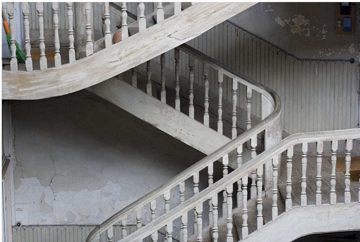
Détail de la rampe en bois tourné de l'escalier droit.
