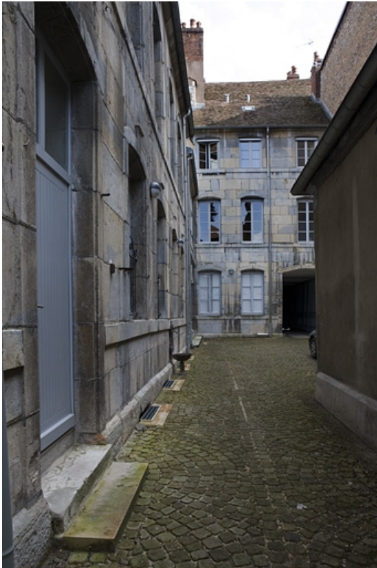
Vue d'ensemble des bâtiments depuis le fond de la cour. 25, Besançon, 24 rue Chifflet, lieudit : îlot Banque de France
