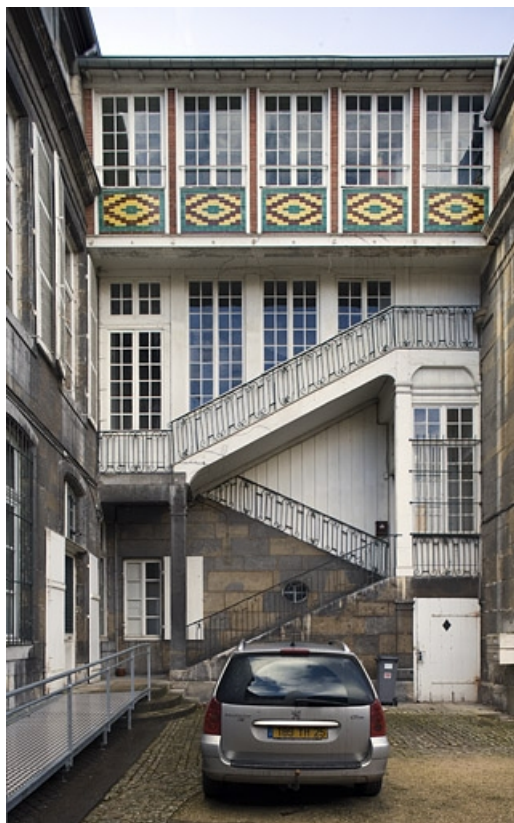
Vue d'ensemble de l'escalier à cage ouverte, de face.
