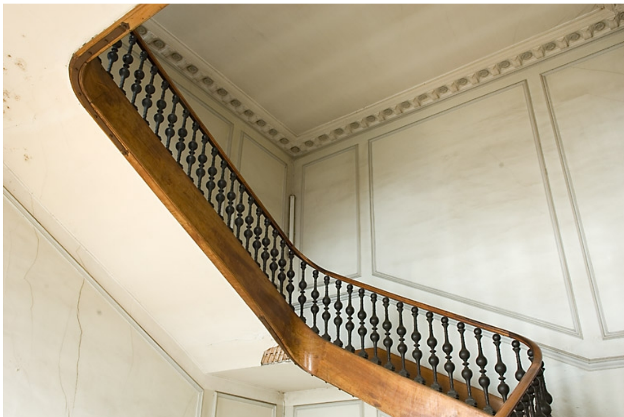
Escalier d'honneur : vue d'ensemble avec le plafond de la cage.
