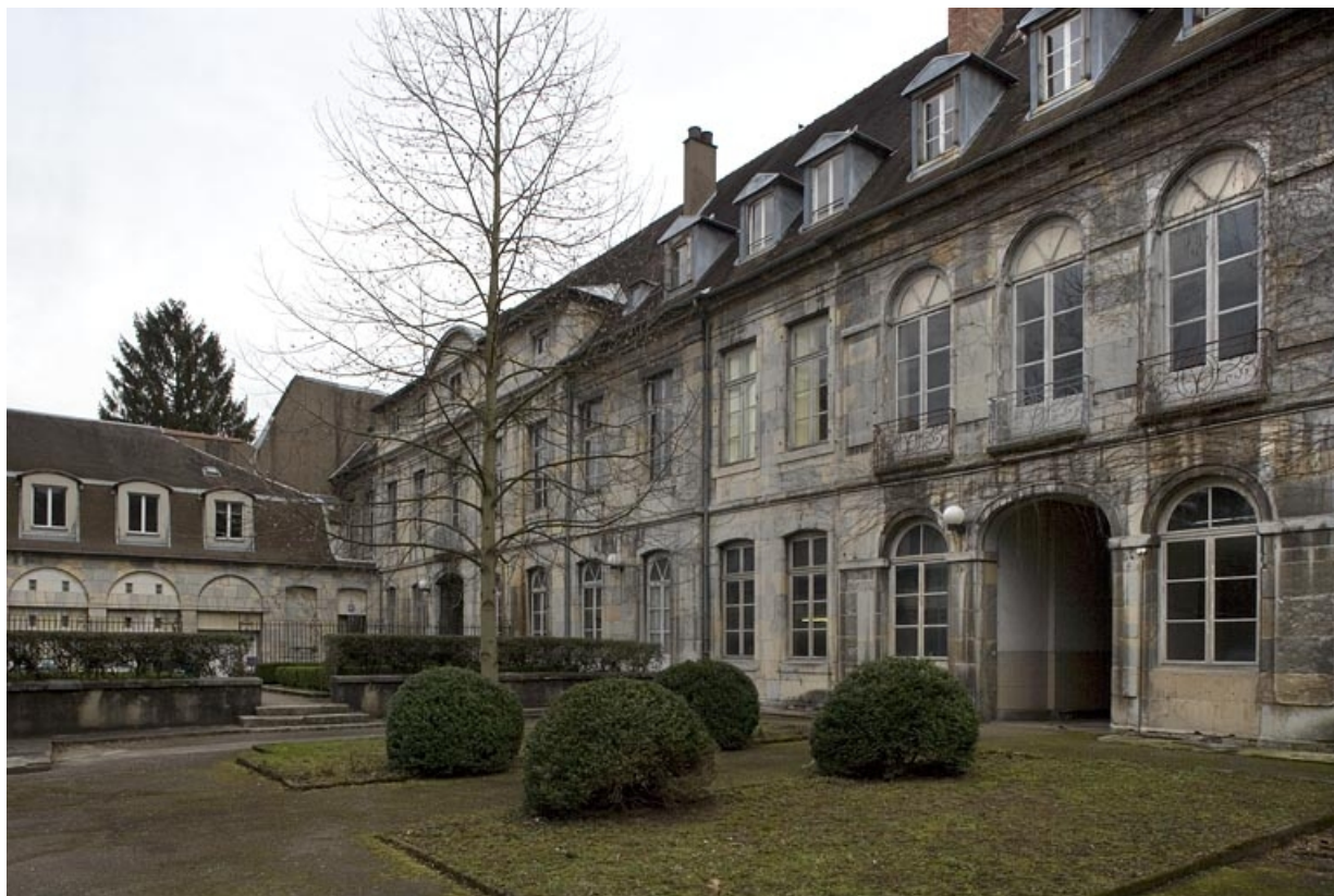
Vue d'ensemble de la façade sur cour de trois-quart droit.
