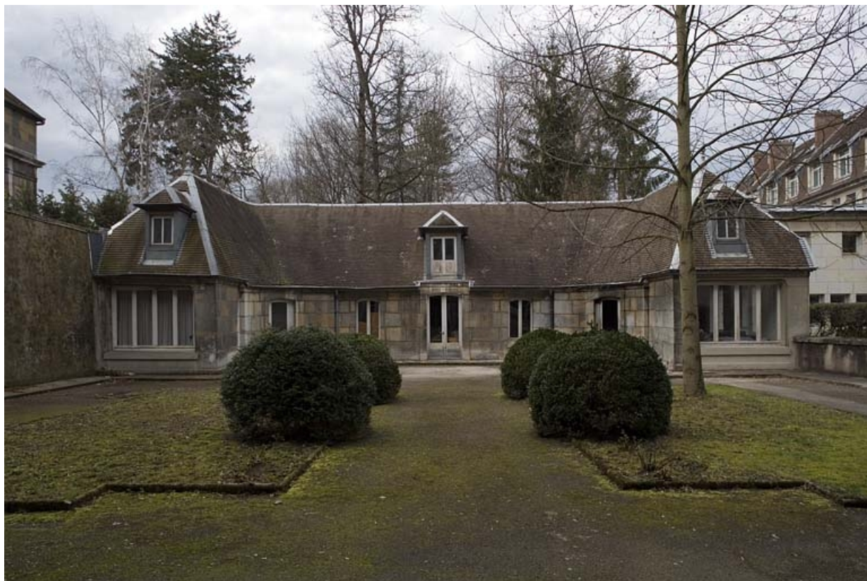
Bâtiment des anciennes écurie et remise : vue d'ensemble.
