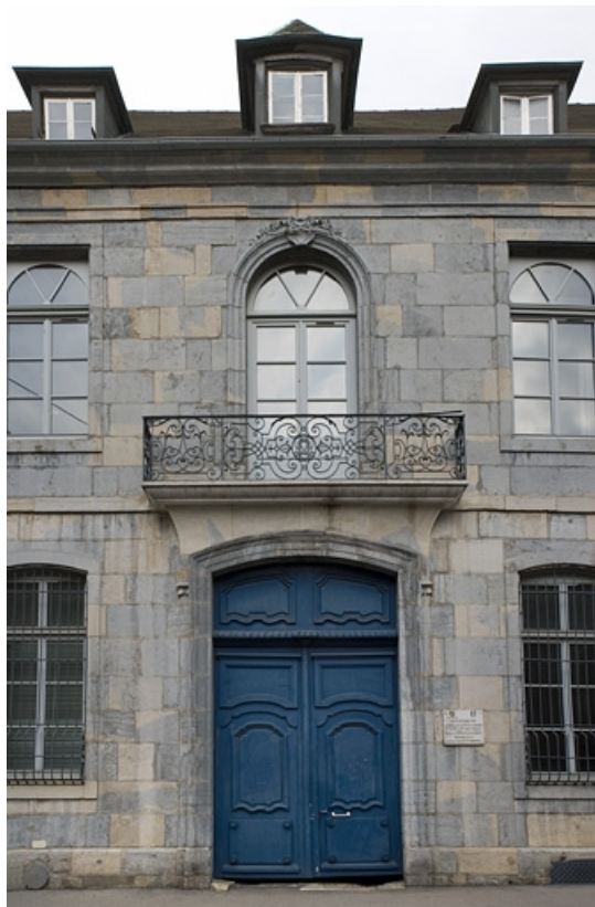
Détail du portail d'entrée et du balcon de la façade sur rue, de face.
