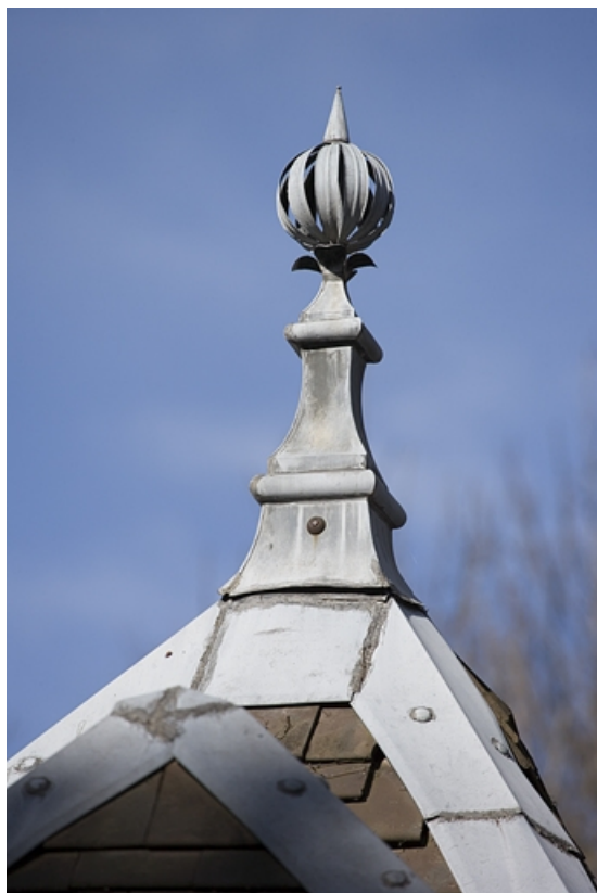
Bâtiment des anciennes écurie et remise : détail d'un épi de faitage.
