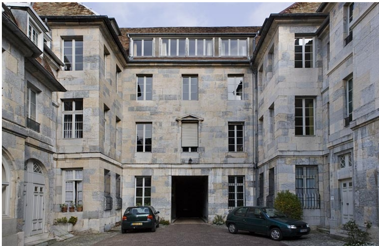
Vue d'ensemble des façades sur cour du logis principal depuis le fond de la cour.
