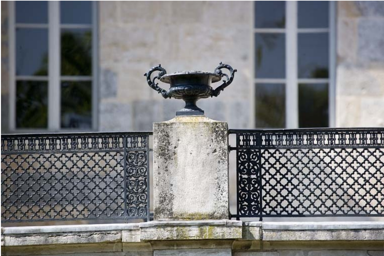
Détail d'un vase en fonte ornant le parapet de la terrasse du jardin d'hiver.
