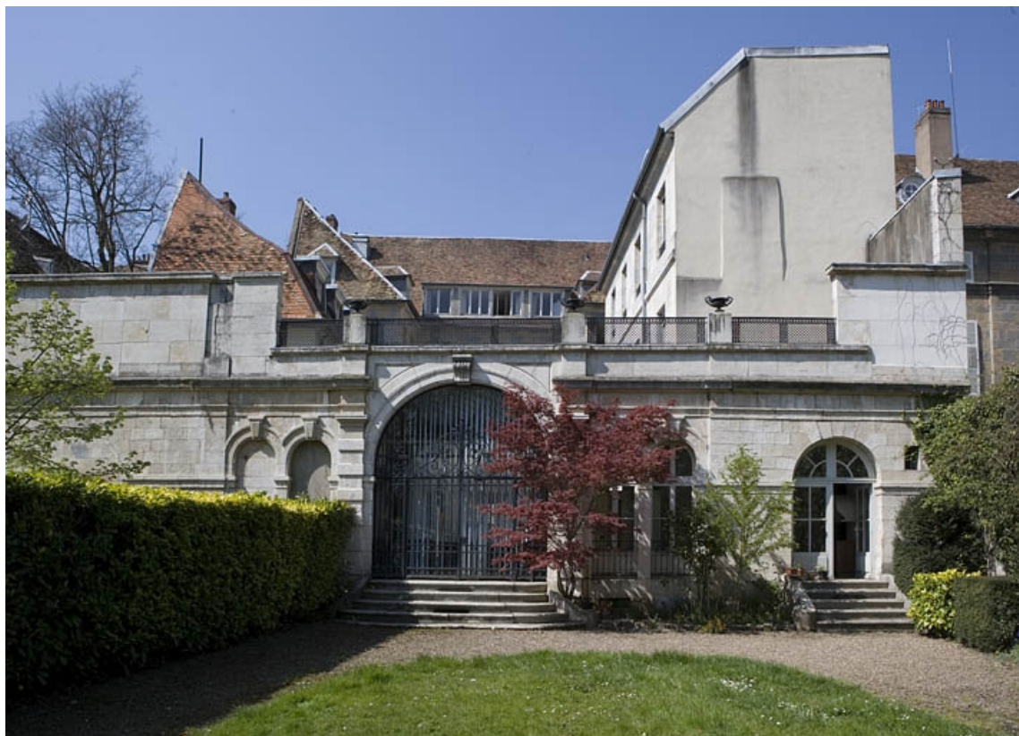
Vue de la façade postérieure du jardin d'hiver.
