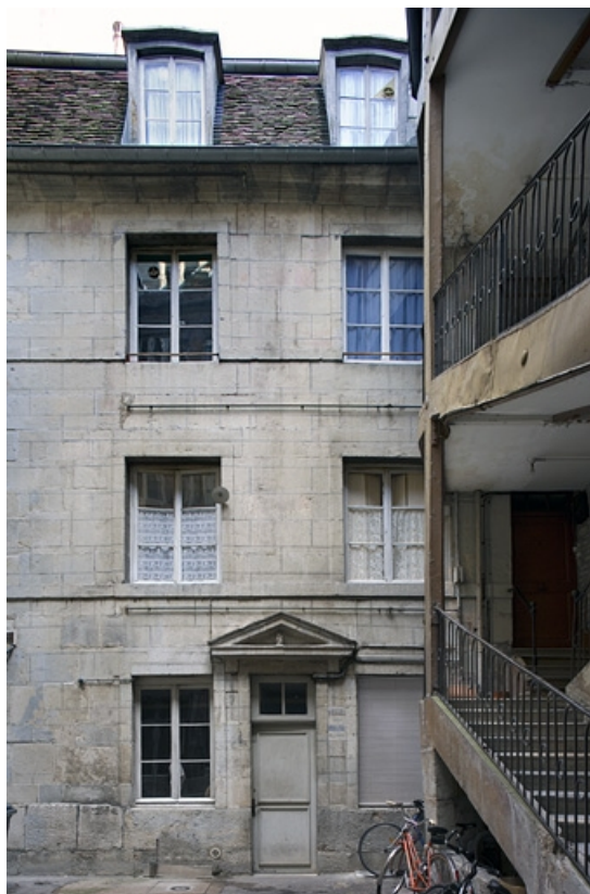
Vue de la façade sur cour du logis secondaire.
