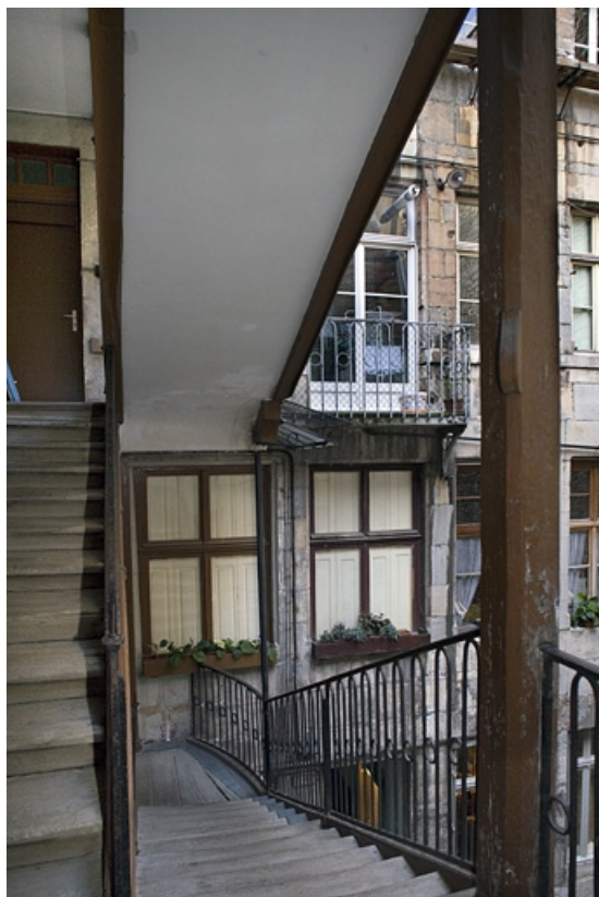
Vue de la façade sur cour du logis principal depuis l'escalier.
