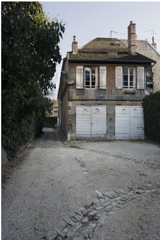
Vue d'ensemble de face du bâtiment des remise et écurie gauche.
