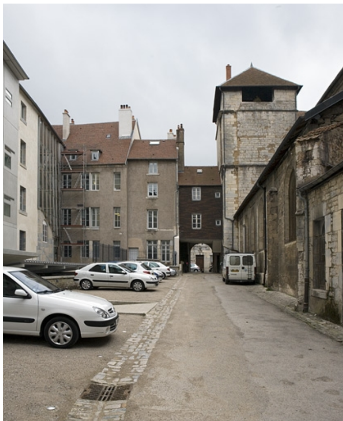
Vue de l'arrière de l'immeuble depuis le fond de l'impasse.
