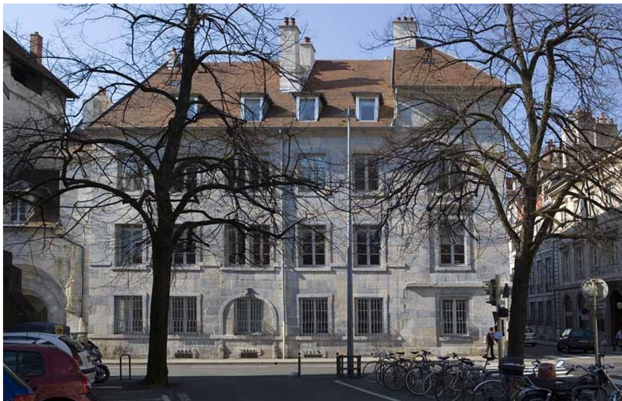
Vue d'ensemble de la façade latérale gauche depuis la promenade Granvelle. 25, Besançon, 13 rue de la Préfecture, lieudit : îlot Banque de France
