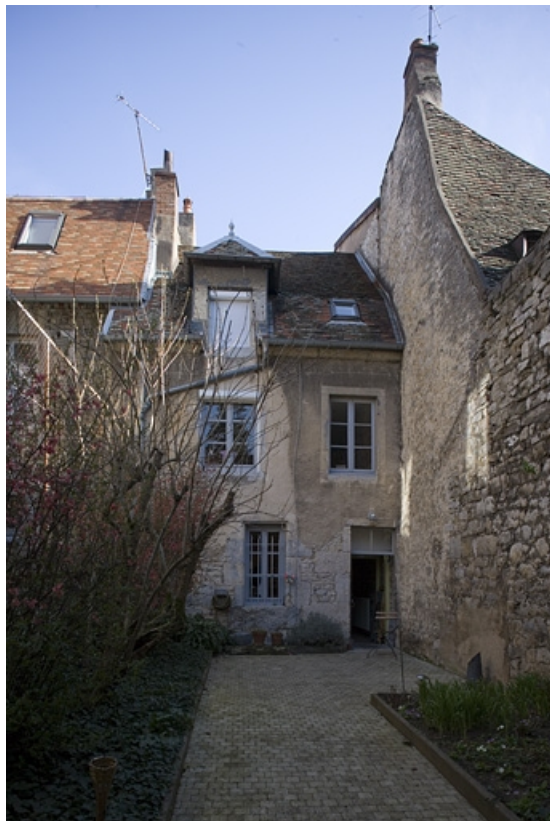
Façade postérieure du logis en fond de première cour depuis la deuxième cour. 25, Besançon, 38 rue Mégevand, lieudit : îlot Banque de France
