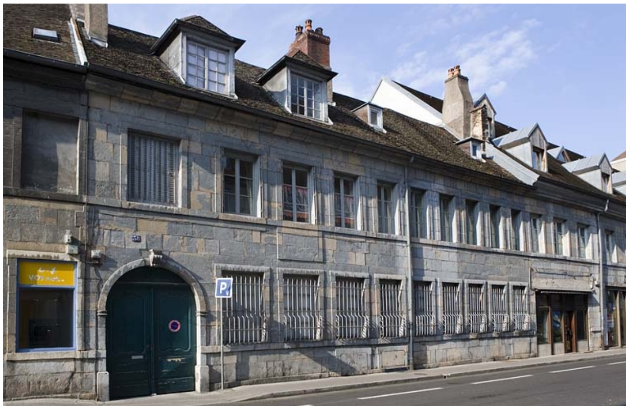
Vue d'ensemble depuis la rue de trois quarts gauche.
