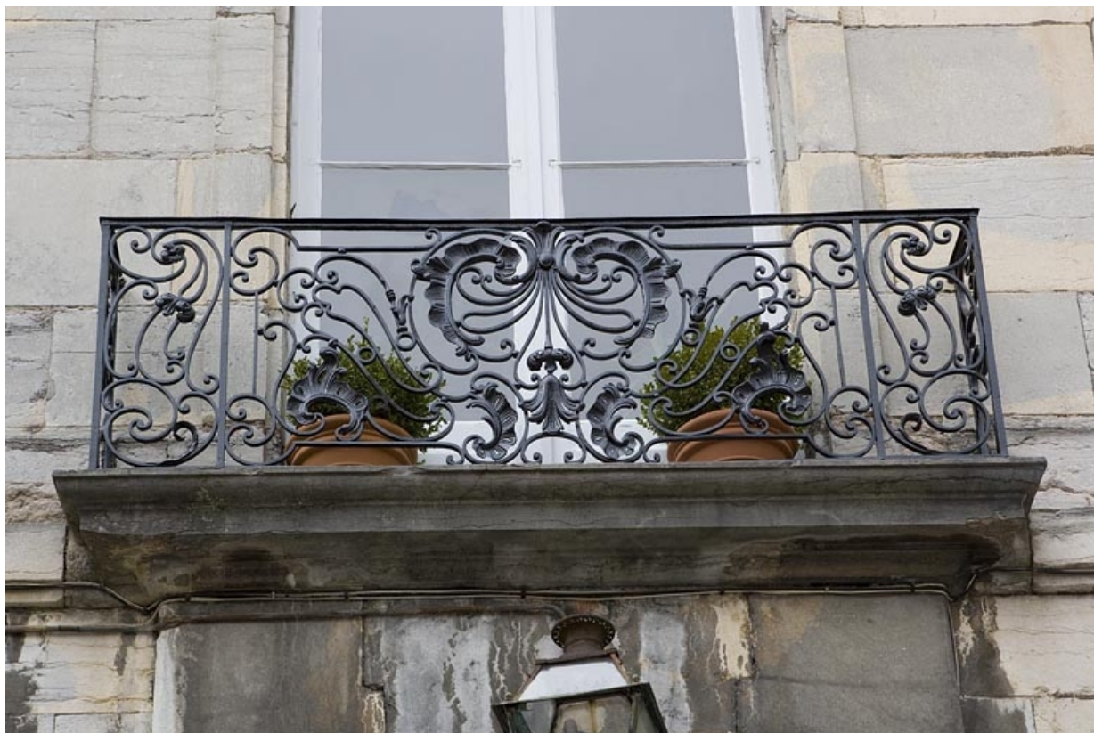
Détail du balcon en ferronnerie sur la façade sur cour du logis principal.
