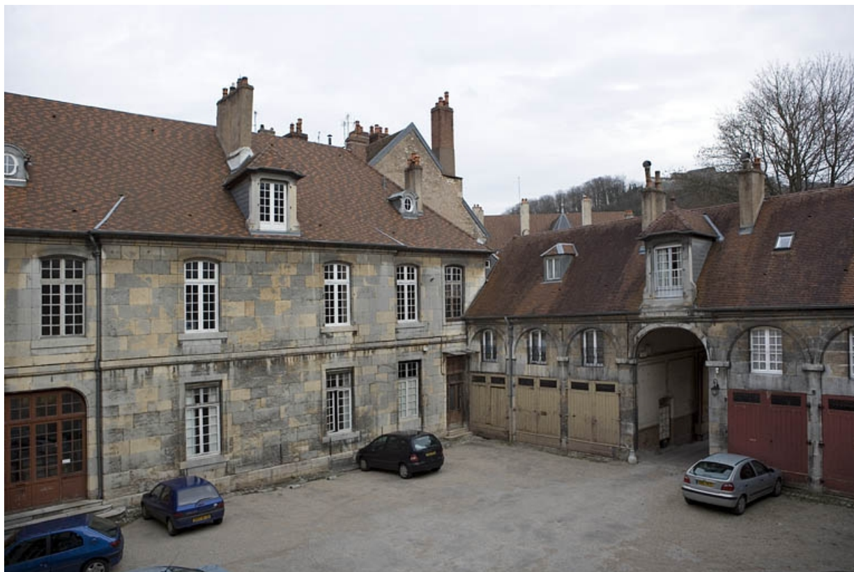
Vue d'ensemble de l'aile droite sur cour et du bâtiment sur rue, de trois quarts gauche.
