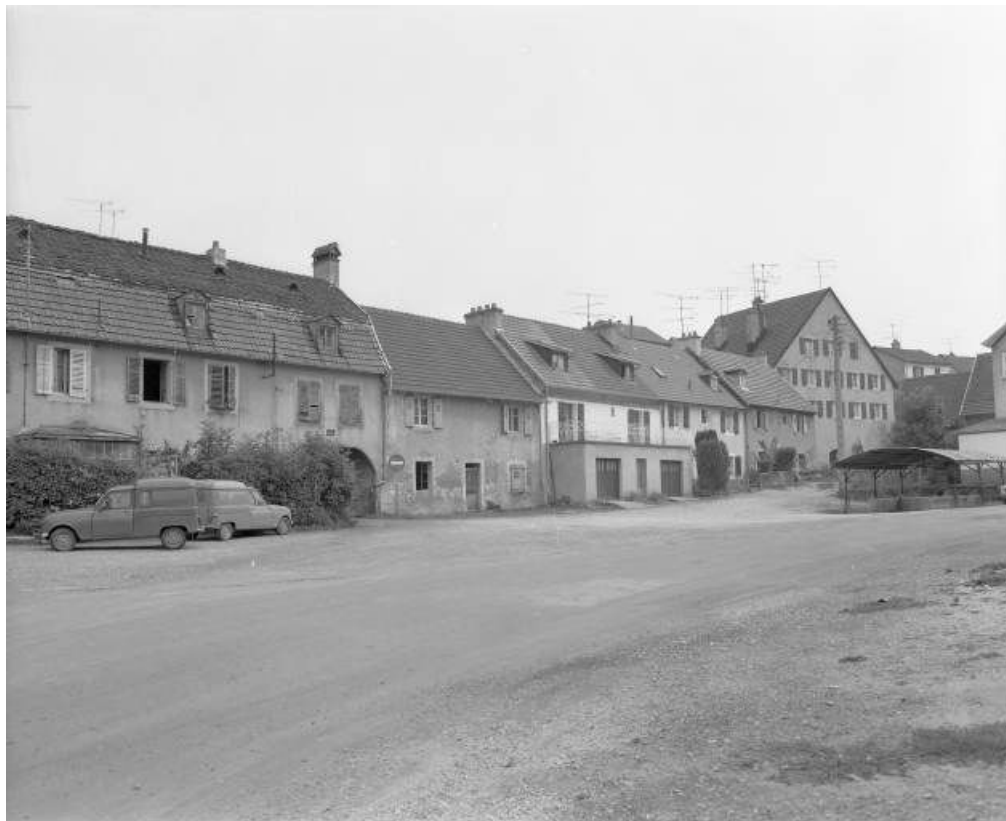
Maison de direction et logements ouvriers au sud de l'usine en 1981.
