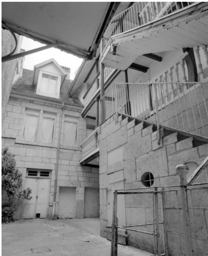
Logis sur cour et escalier depuis l'entrée de la cour. 25, Besançon, 11 rue Claude Pouillet, lieudit : îlot Pasteur
