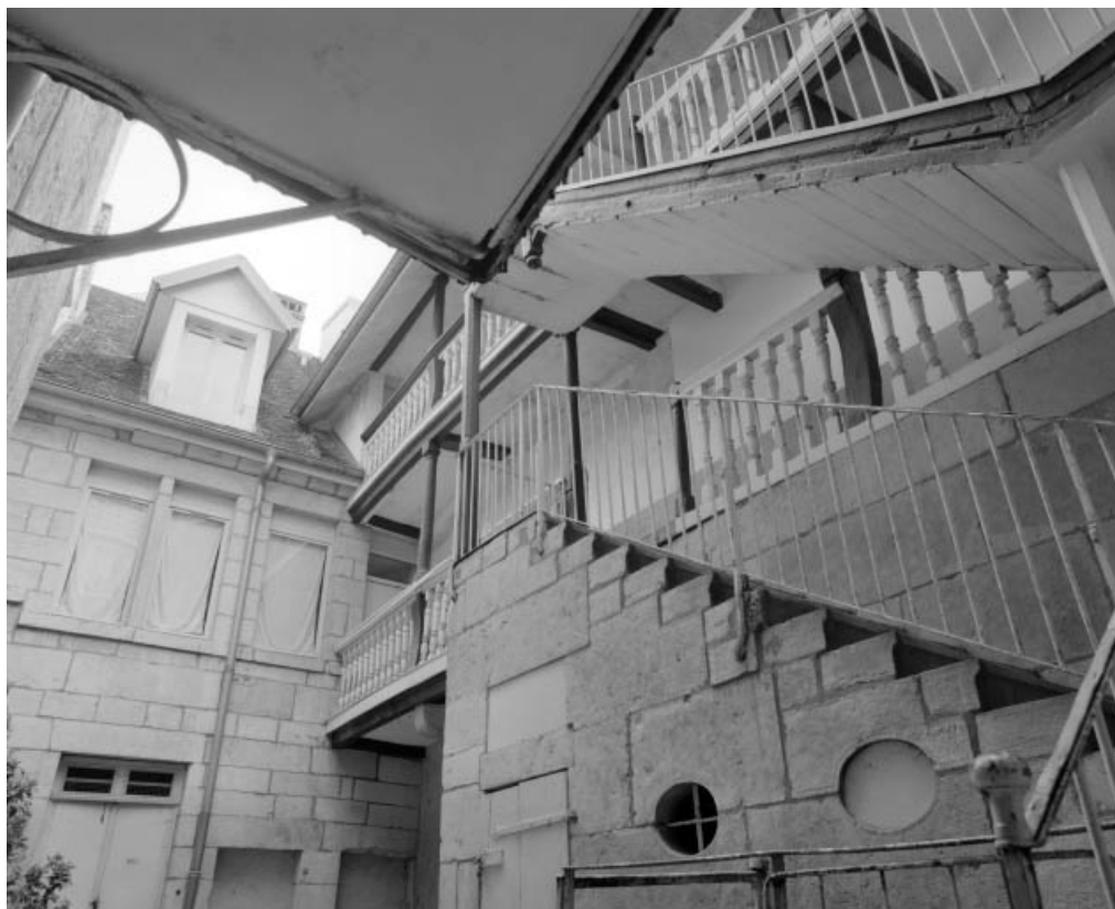
Détail de l'escalier à cage ouverte sur cour, de trois quarts gauche.
