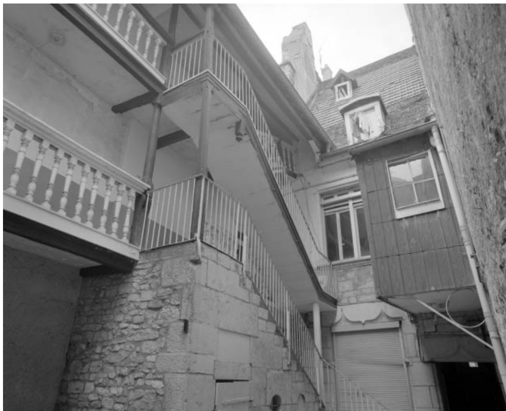
Détail de l'escalier et de la coursière depuis le fond de la cour.
